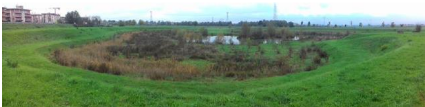
Figura 62. Cassa di espansione 2
