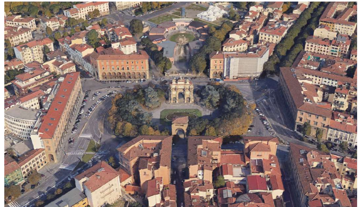
Piazza della Libertà: foto aerea della Diretrice principale su cui si allineano via San Gallo, Porta San Gallo, l'arco dei Lorena ed il Parterre
