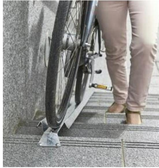
***Esempio rampa ciclabile per scale in acciaio zincato***
