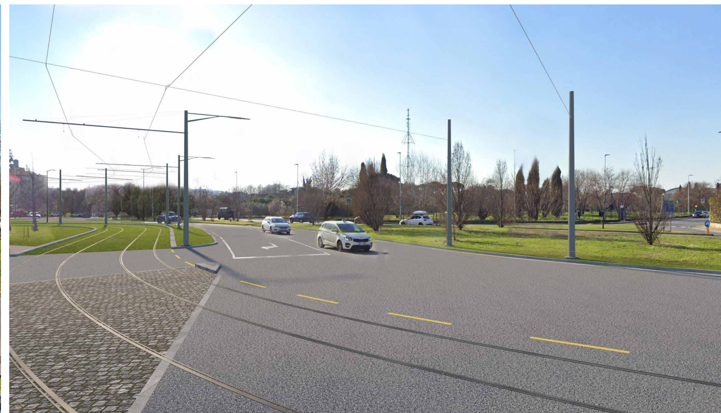
FOTOINserIMENTO 28. Ex ospedale psichiatrico di S. Salvi | Vincolo architettonico | (PR 28)
