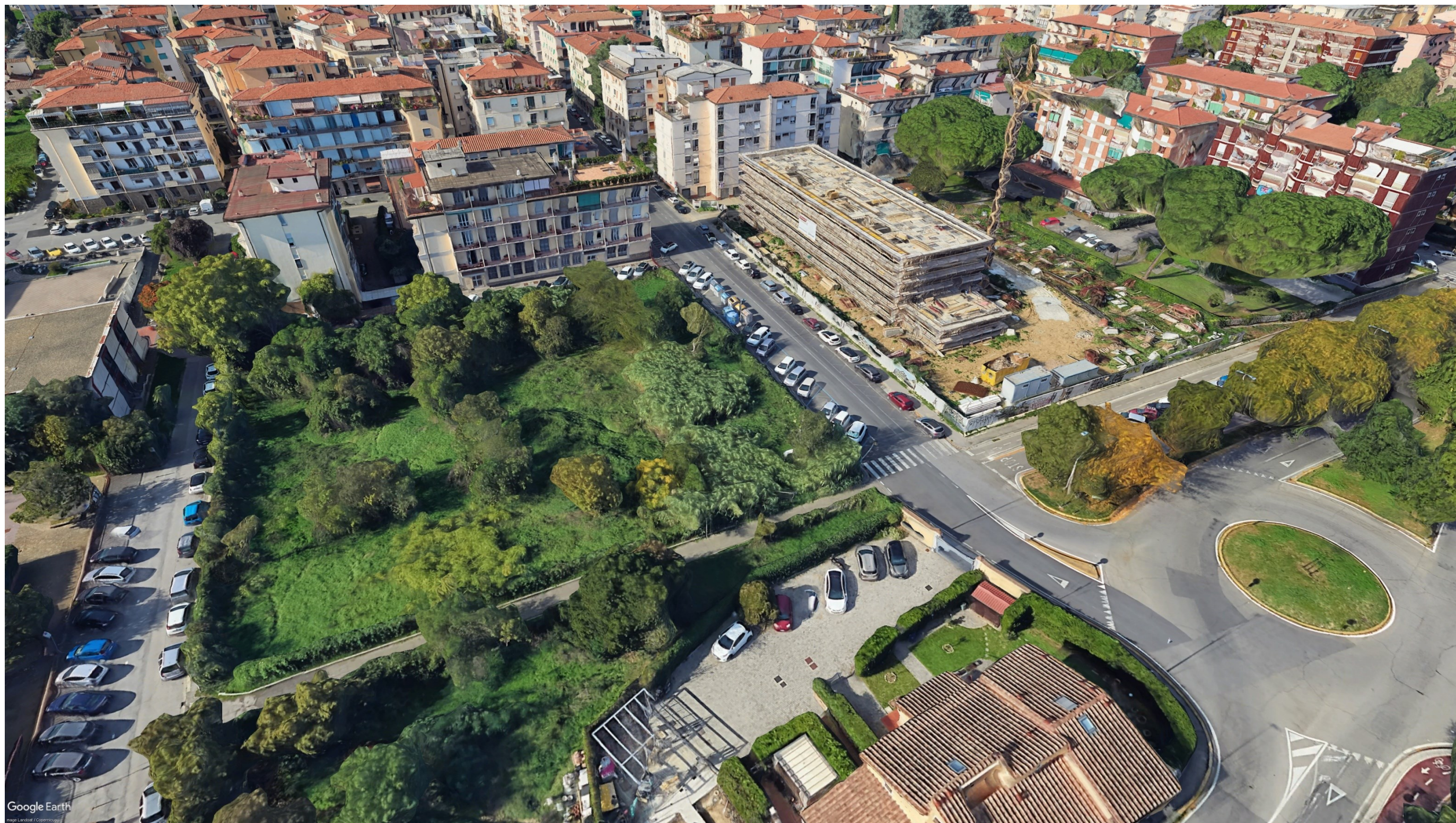
Figura 1. Area del Parcheggio Rondinella stato attuale
