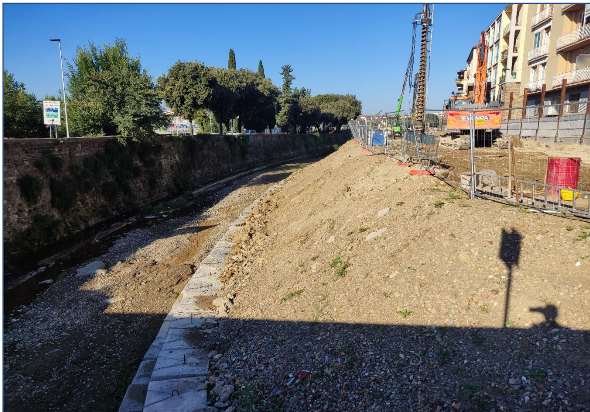
Vista area di cantiere d'alveo del Mugnone
