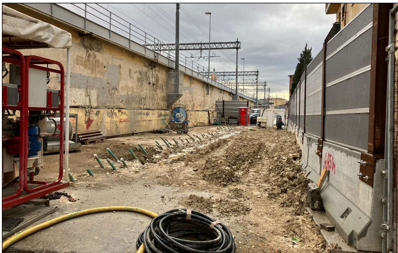
Figura 16 – Via delle Ghiacciaie (Edificio 35)
