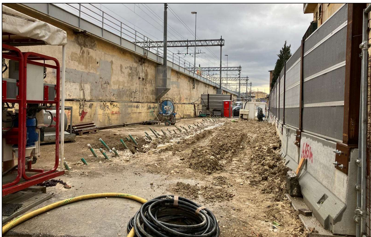
Figura 16 – Via delle Ghiacciaie (Edificio 35)
