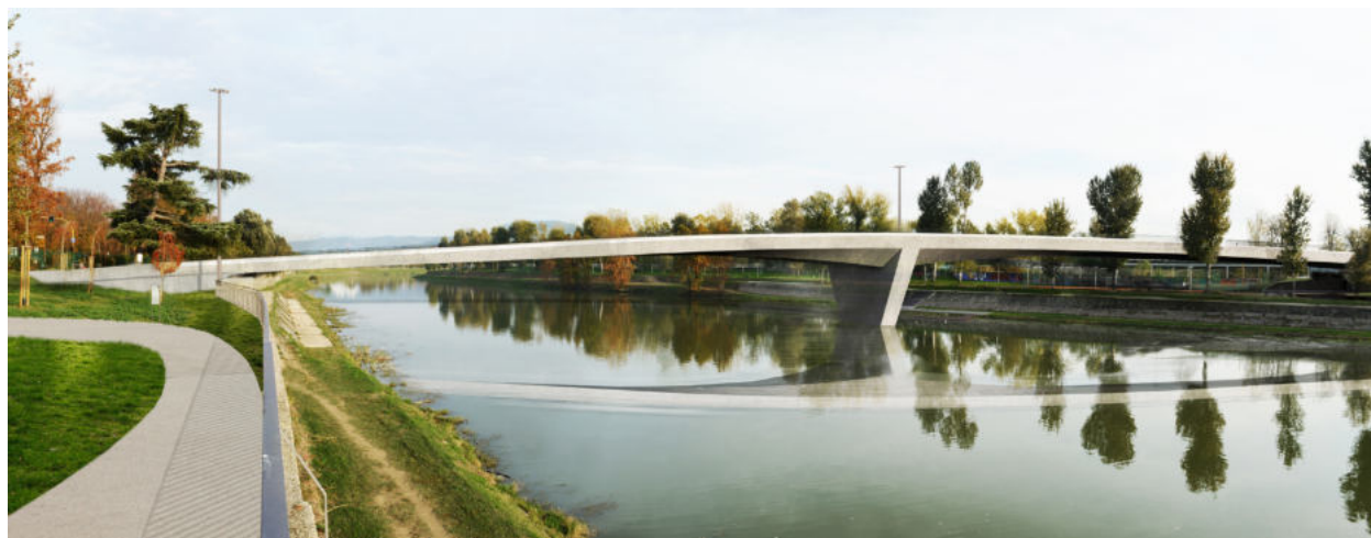
Vista del nuovo ponte stradale sull'Arno
