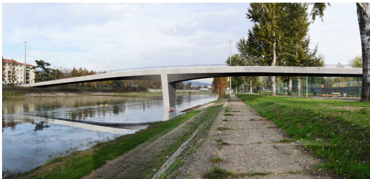
Vista del ponte dal parco dell'Albereta
