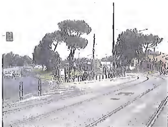
Foto 7. Vista della sede tranviaria a fronte del punto di misura verso la fermata di Via Paolo Uccello
