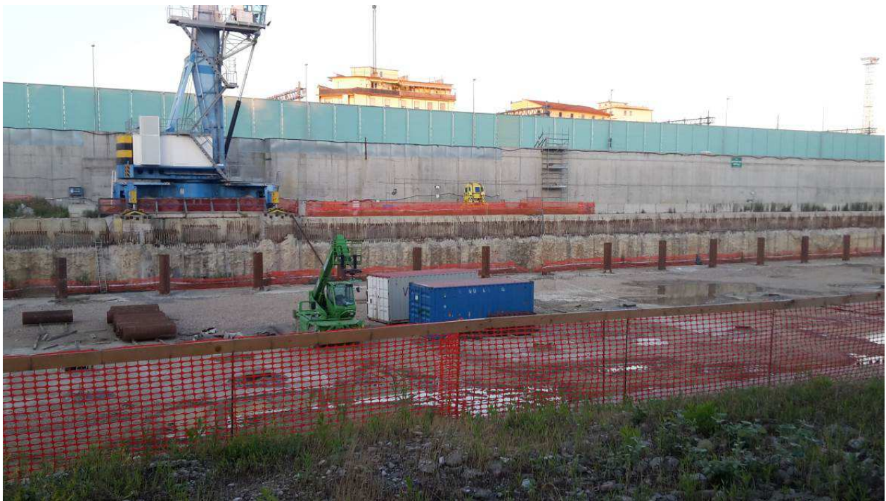
FOTO 4– Prolungamento colonne per Appoggio Solaio Piano Terra
