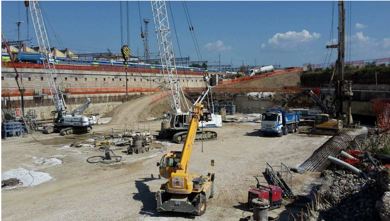
FOTO 2– Realizzazione pali di fondazione camerone Stazione AV
