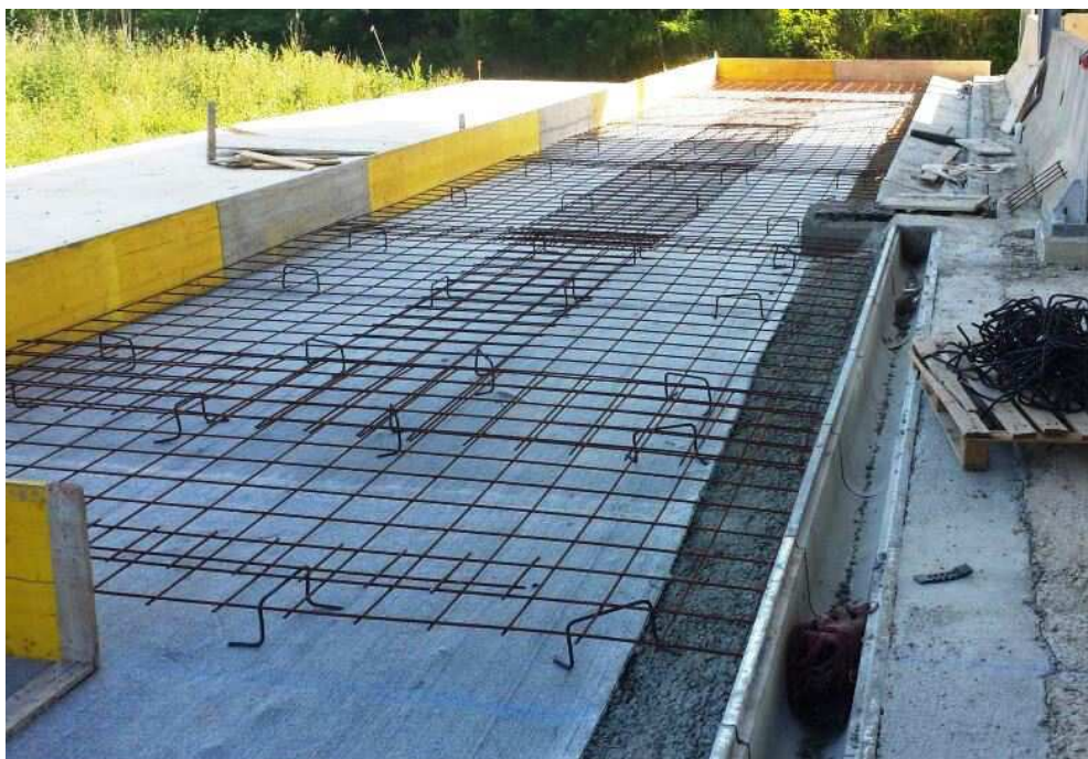
FOTO 1 – Completamento soletta pavimentazione piazzola 8
