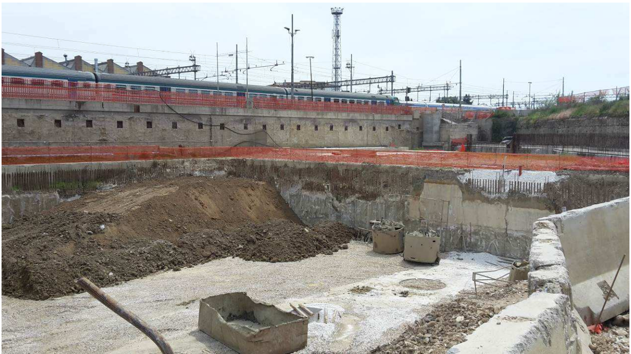
FOTO 1– Sbancamento Terre da q. +46,00 a +41,00
