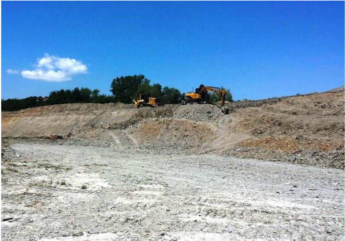
FOTO 2 – Completamento Terminal Bricchette
