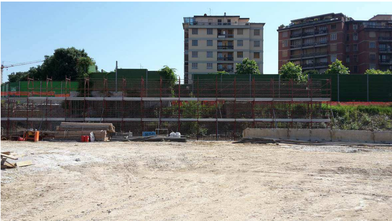
FOTO 3– Realizzazione della prima parete della Rampa Kiss&Ride
