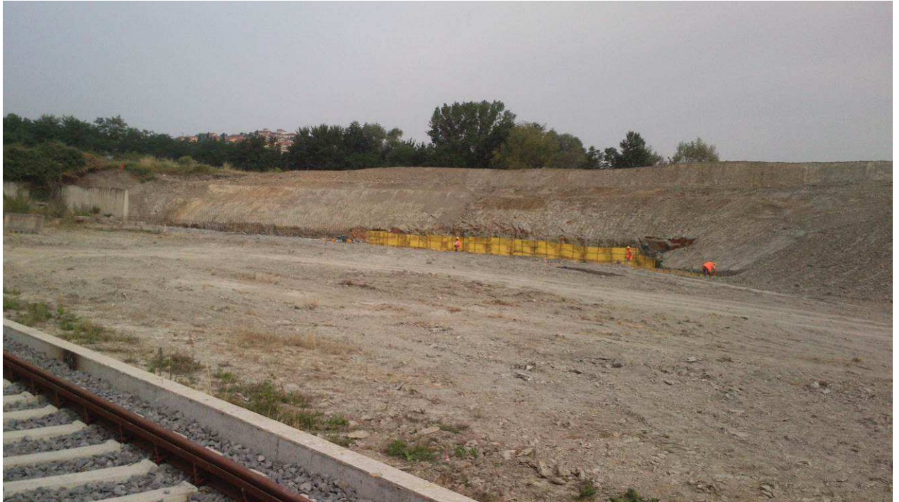
FOTO 3 – Completamento Terminal Bricchette
