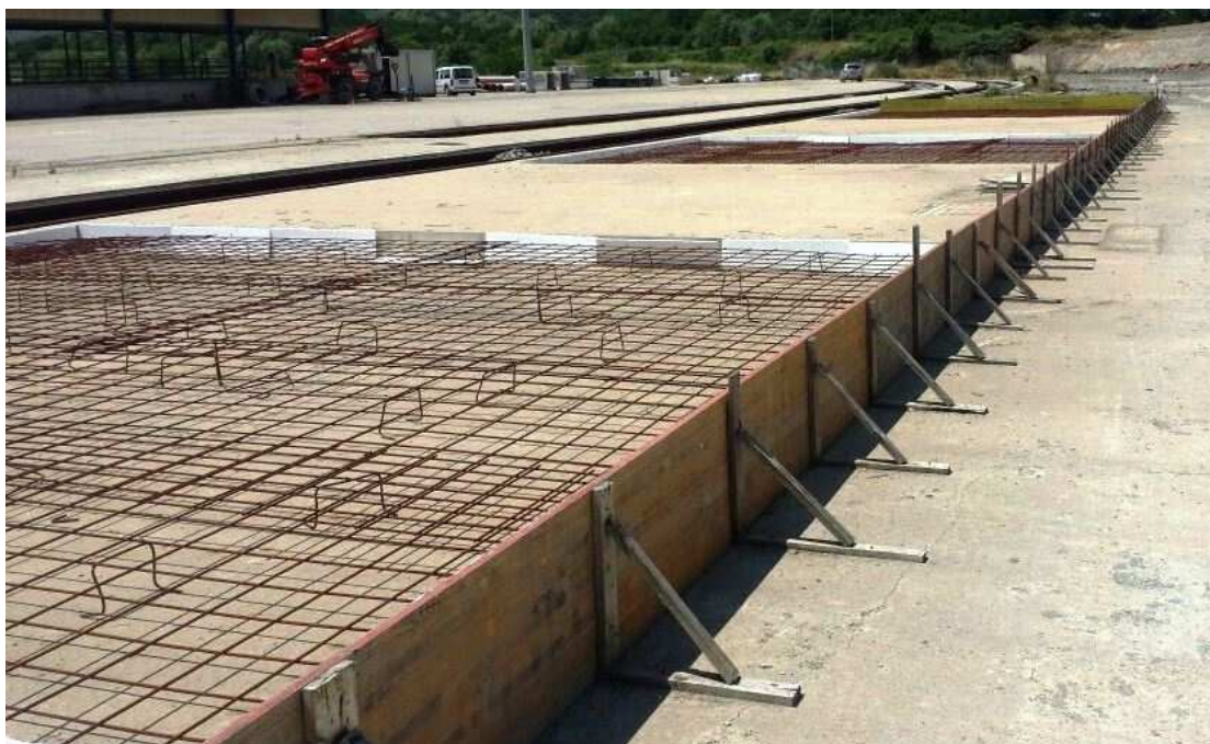
FOTO 2 – Completamento Terminal Bricchette
