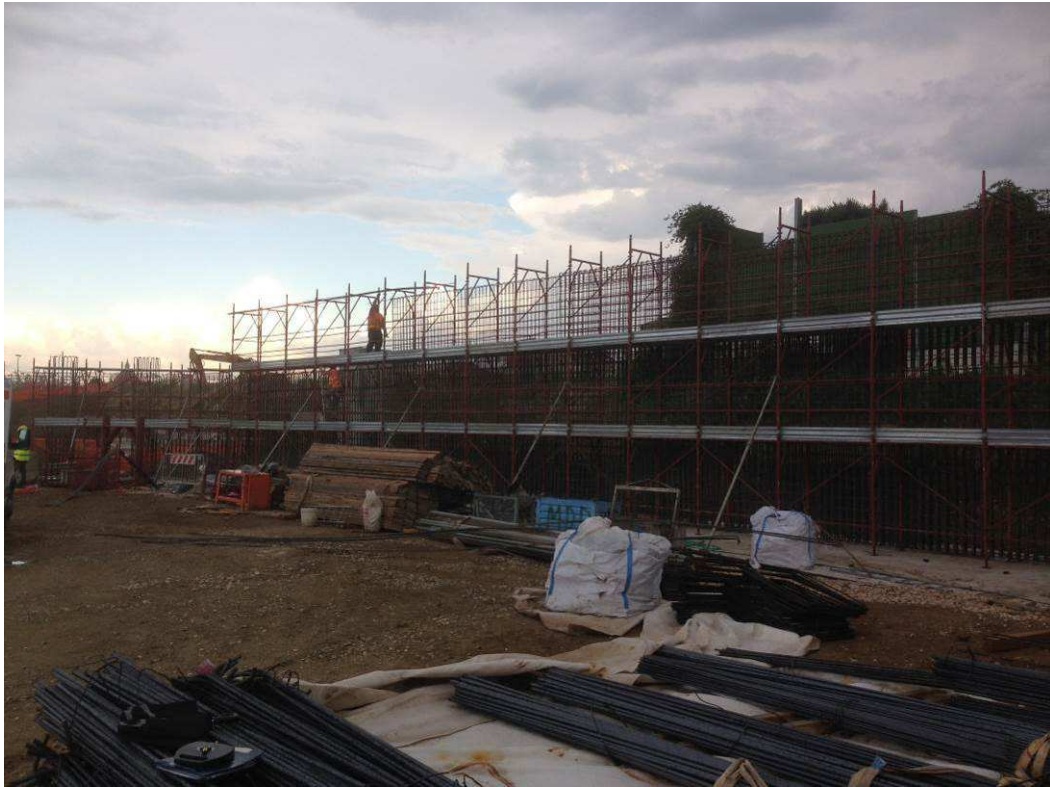
FOTO 2– Realizzazione della prima parete della Rampa Kiss&Ride
