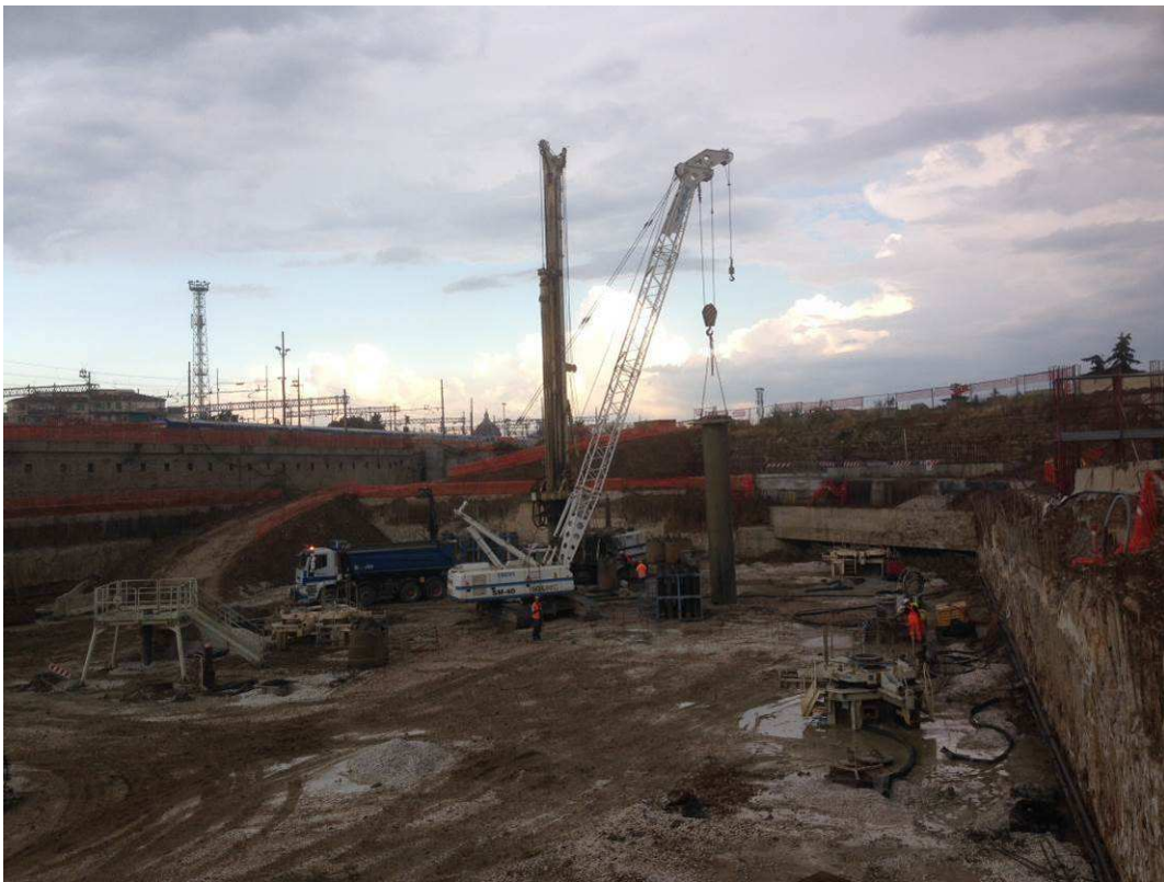
FOTO 1– Realizzazione pali di fondazione camerone Stazione AV
