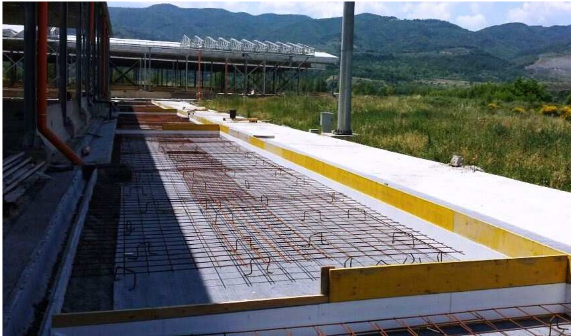
FOTO 1 – Completamento soletta pavimentazione piazzola 8
