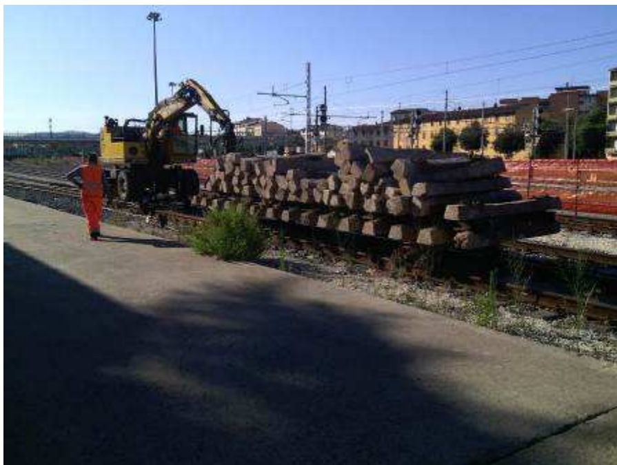
FOTO 4 – Adeguamento Raccordo Ferroviario Campo di Marte
