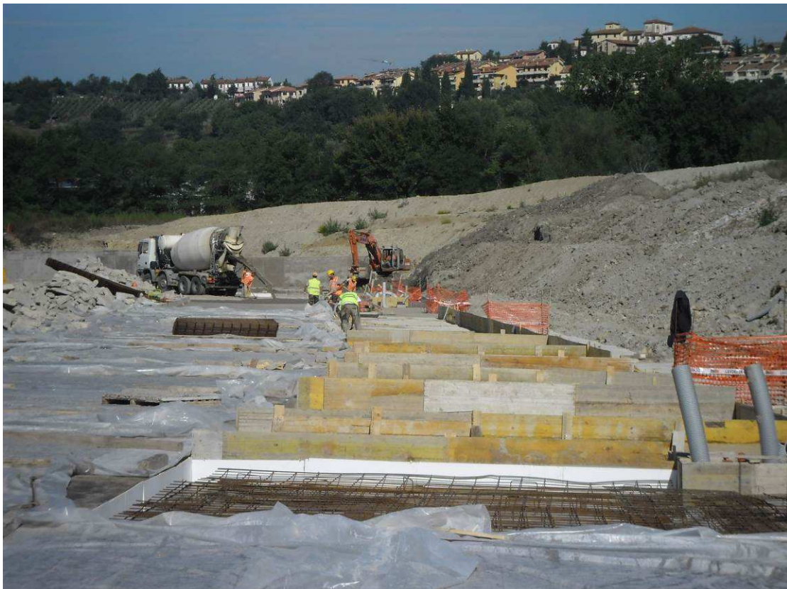
FOTO 6 – Completamento Terminal Bricchette
