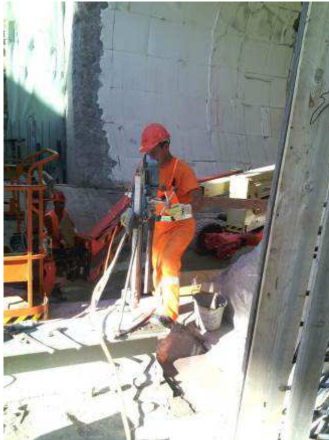
FOTO 3 – Perforazioni per rinforzo struttura di spinta TBM
