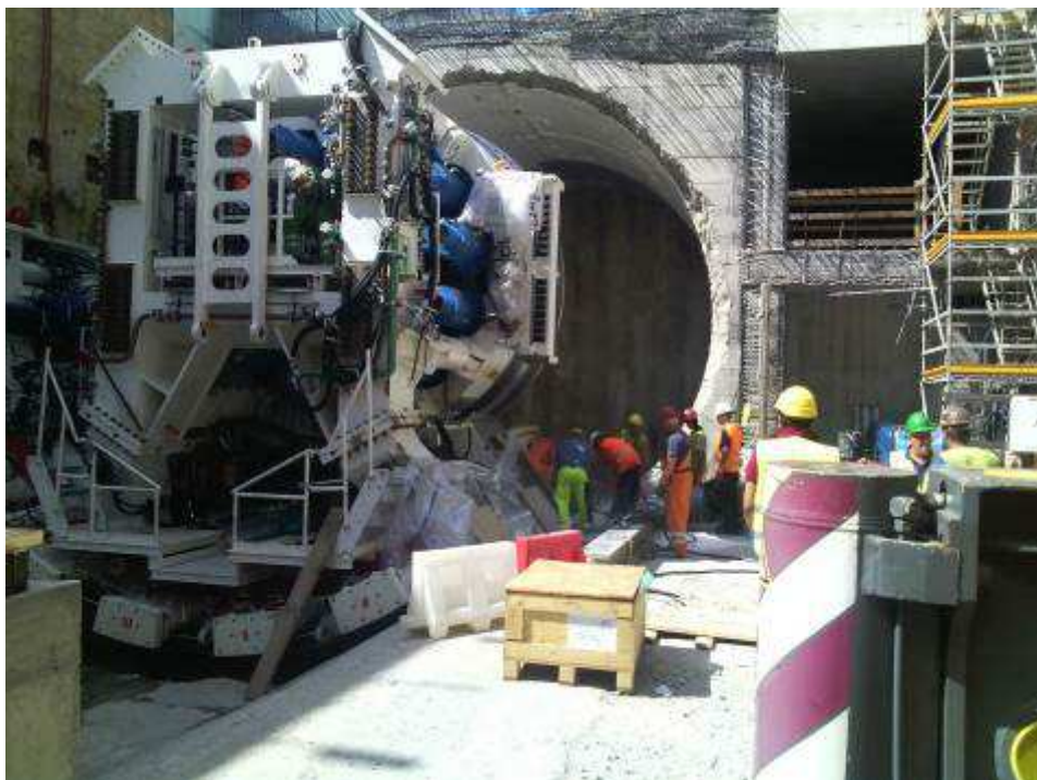
FOTO 2 – Montaggio TBM
