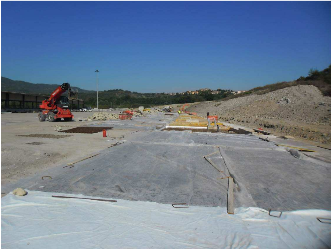
FOTO 5 – Completamento Terminal Bricchette
