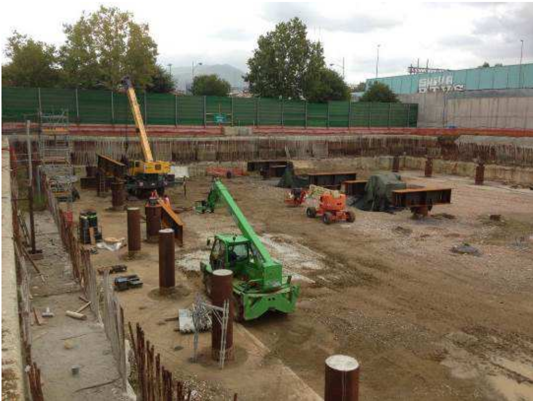
FOTO 1– Posa carpenterie metalliche a sostegno Solaio Piano Terra pressi testata Nord
