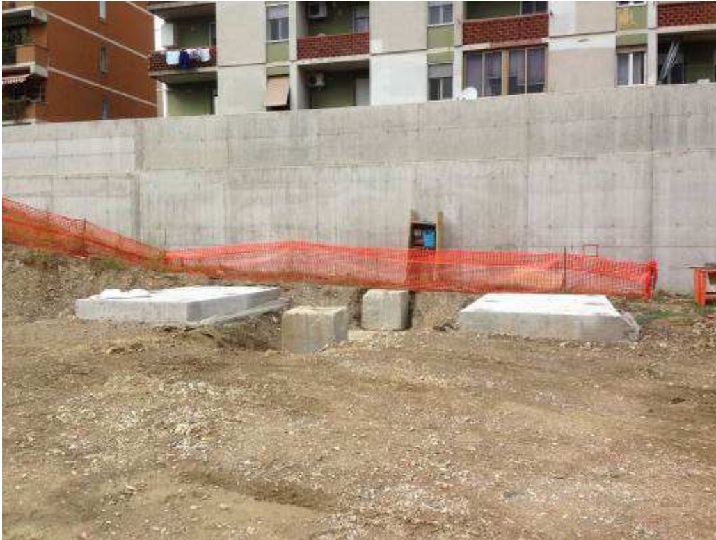
FOTO 2 – Opere propedeutiche alla realizzazione delle prove di carico su pali rampa Kiss&Ride
