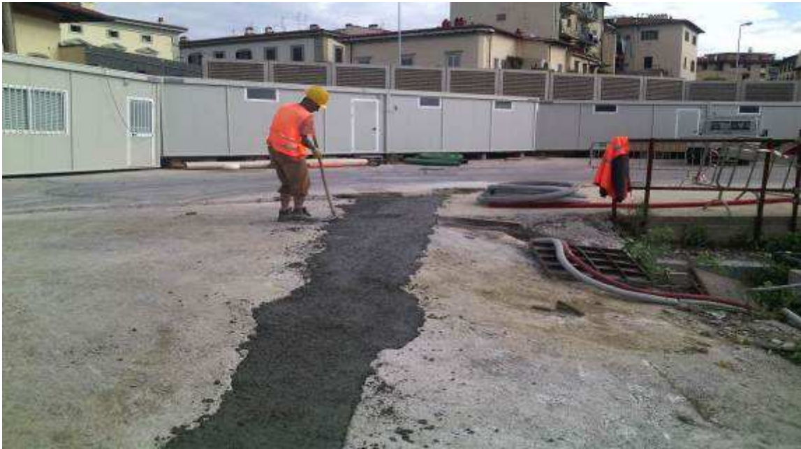
Foto 5 - Regimazione acque al di sopra del pozzo lancio Fresa
