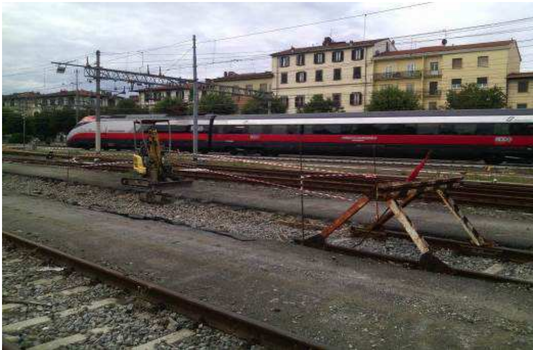
Foto 7 - Adeguamento del Raccordo Ferroviario di Campo di Marte
