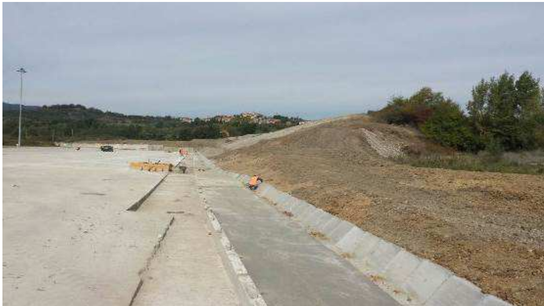
Foto 10 - Completamento Terminal Bricchette
