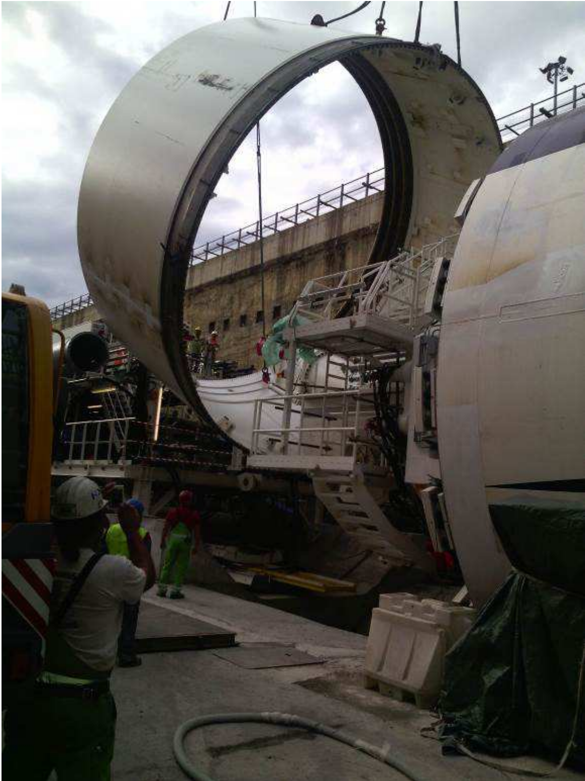
Foto 2 - Montaggio TBM
