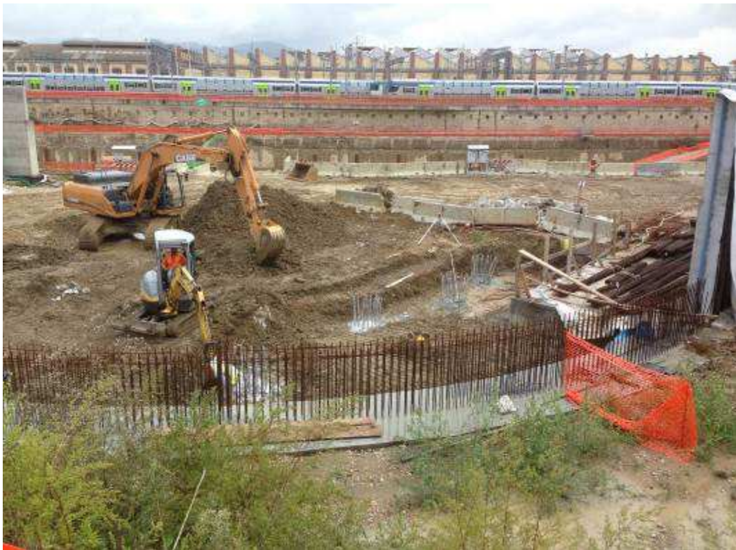
Foto 3 - Pulizia teste pali di fondazione rampa Kiss&Ride
