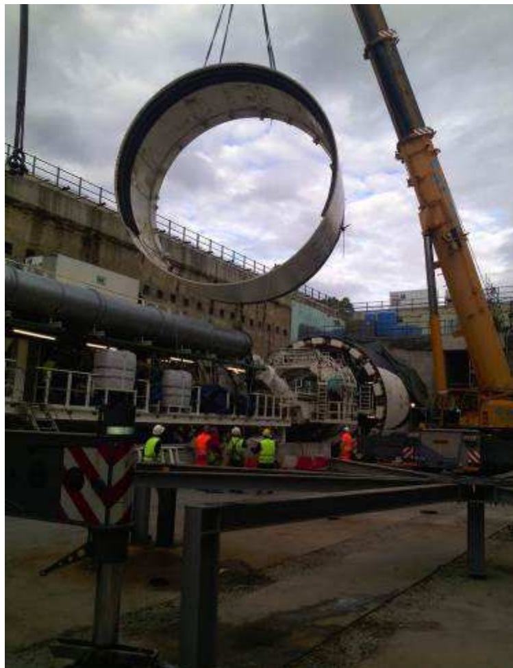
Foto 1 - Montaggio TBM
