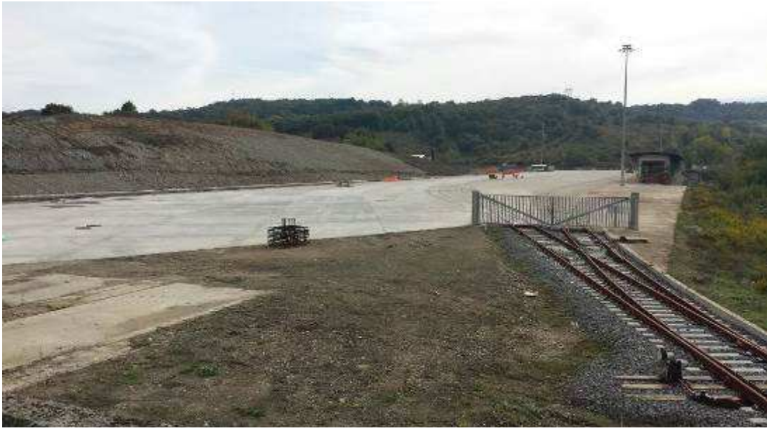
Foto 9 – Completamento Terminal Bricchette
