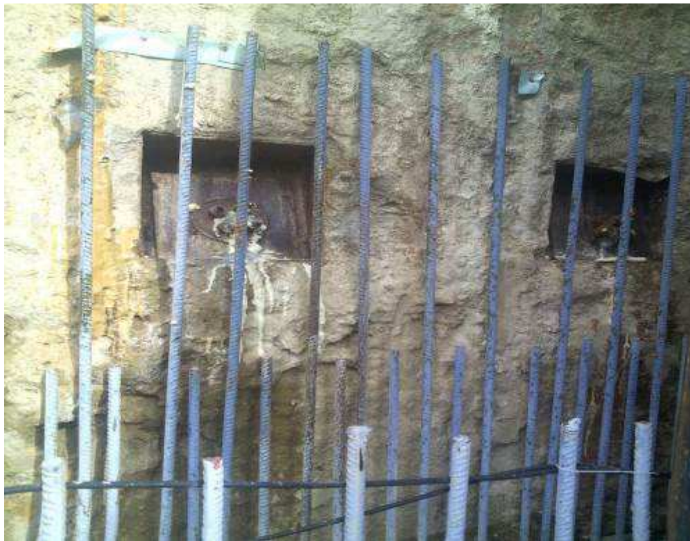
Foto 6 - Interventi per risoluzione nc 122
