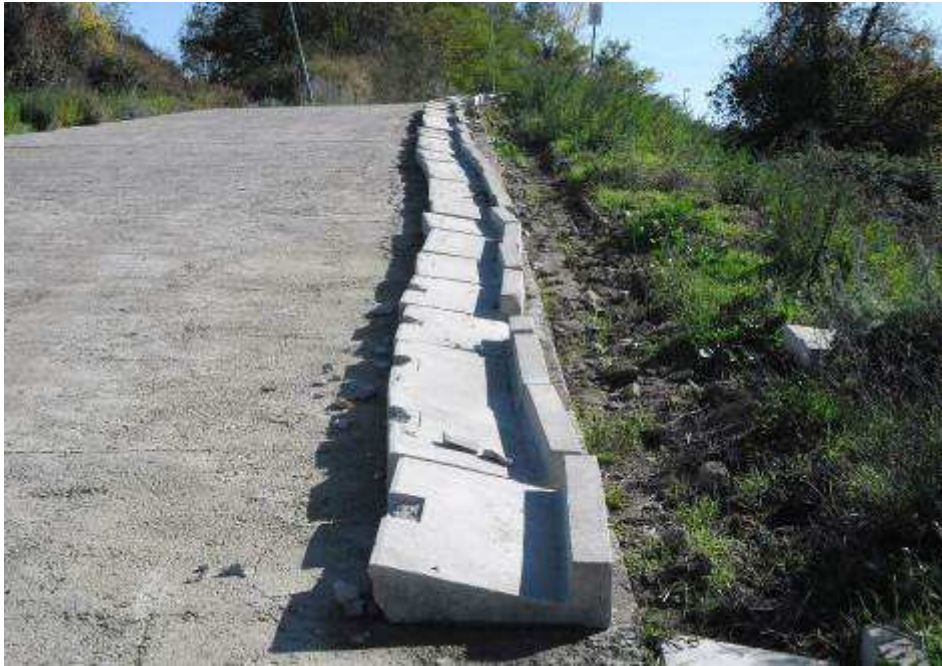
Foto 8 – Ripristino cunette viabilità di servizio
