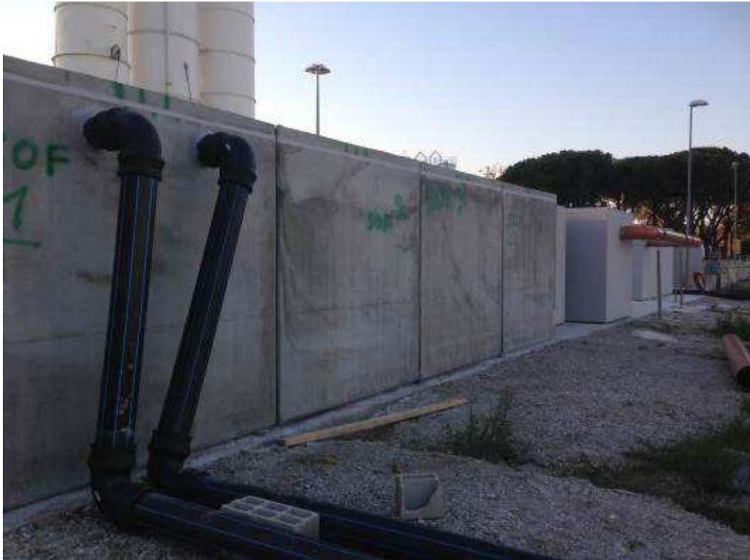
Foto 4 – Vasche impianto di aggettamento acque
