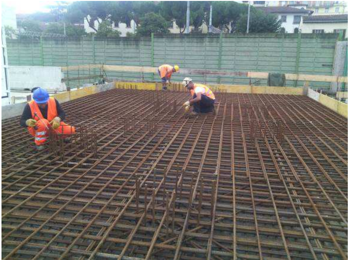
Foto 3 – Armatura basamento silos
