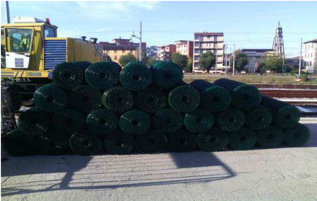
Foto 5 - Adeguamento del Raccordo Ferroviario di Campo di Marte
