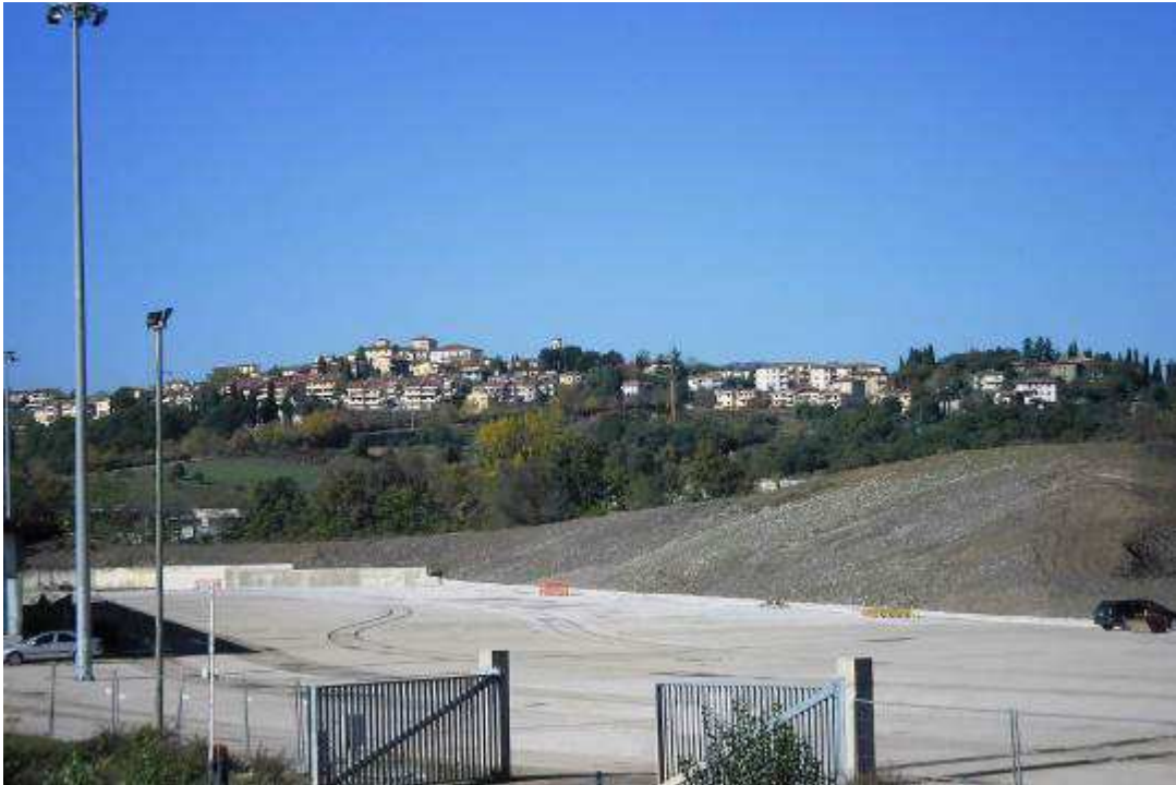
Foto 6 – Completamento Terminal Bricchette - Finiture
