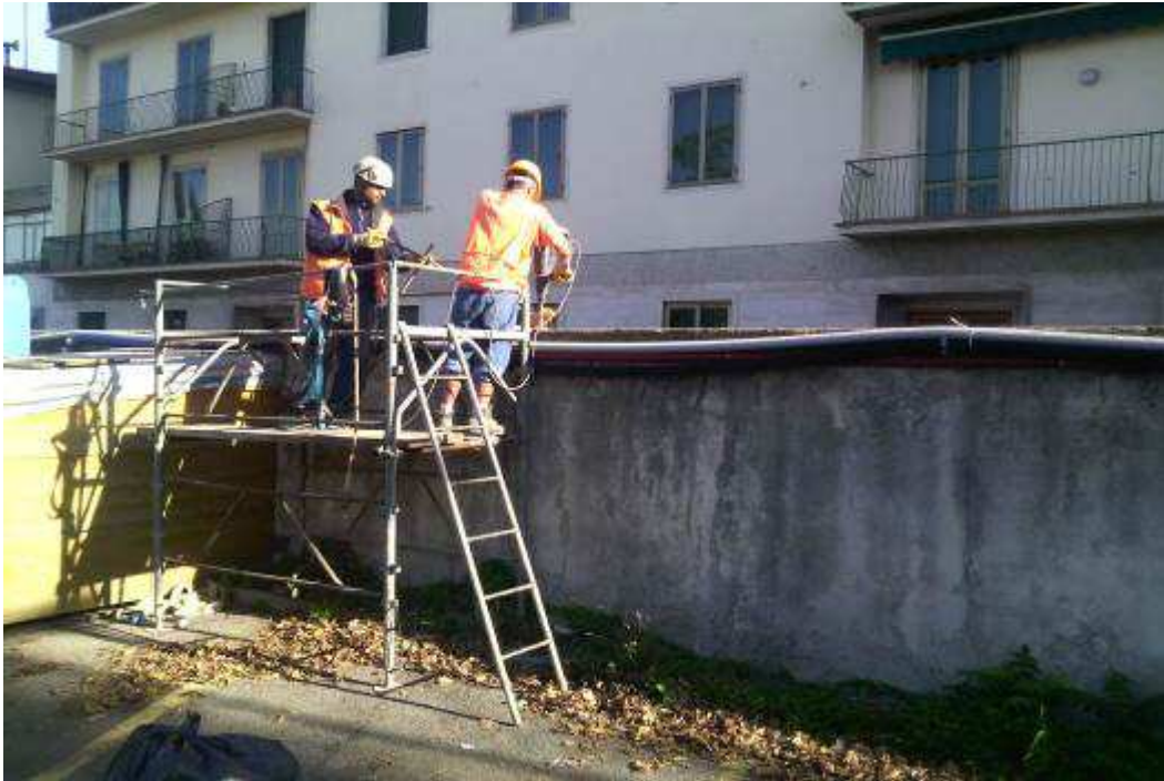
Foto 4 – Rialzo recinzione su muro via Campo d'Arrigo
