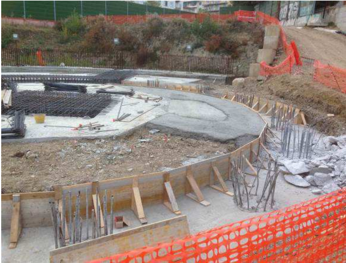
Foto 2 - Sottofondazioni rampa Kiss&Ride
