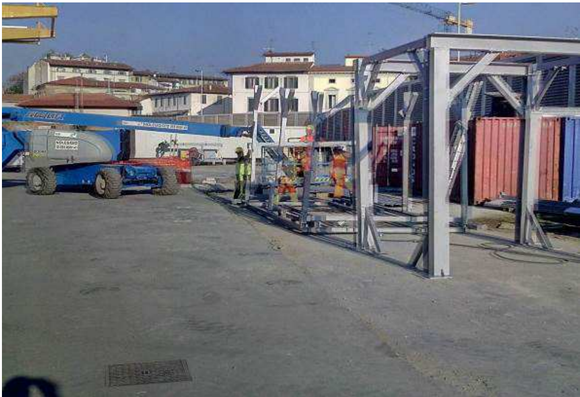
Foto 3 – Montaggio struttura filtropressa
