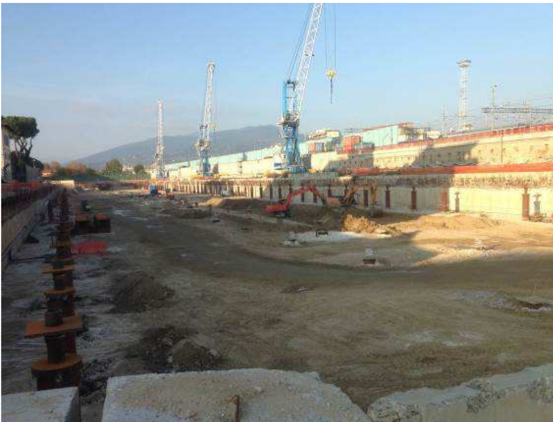
Foto 1 - Scavi approfondimento interni al Camerone di Stazione AV
