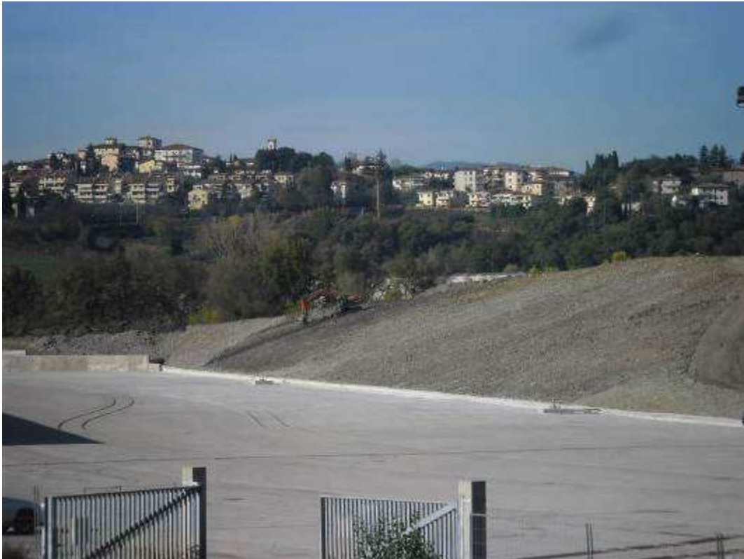
Foto 6 – Profilatura scarpata Terminal Bricchette
