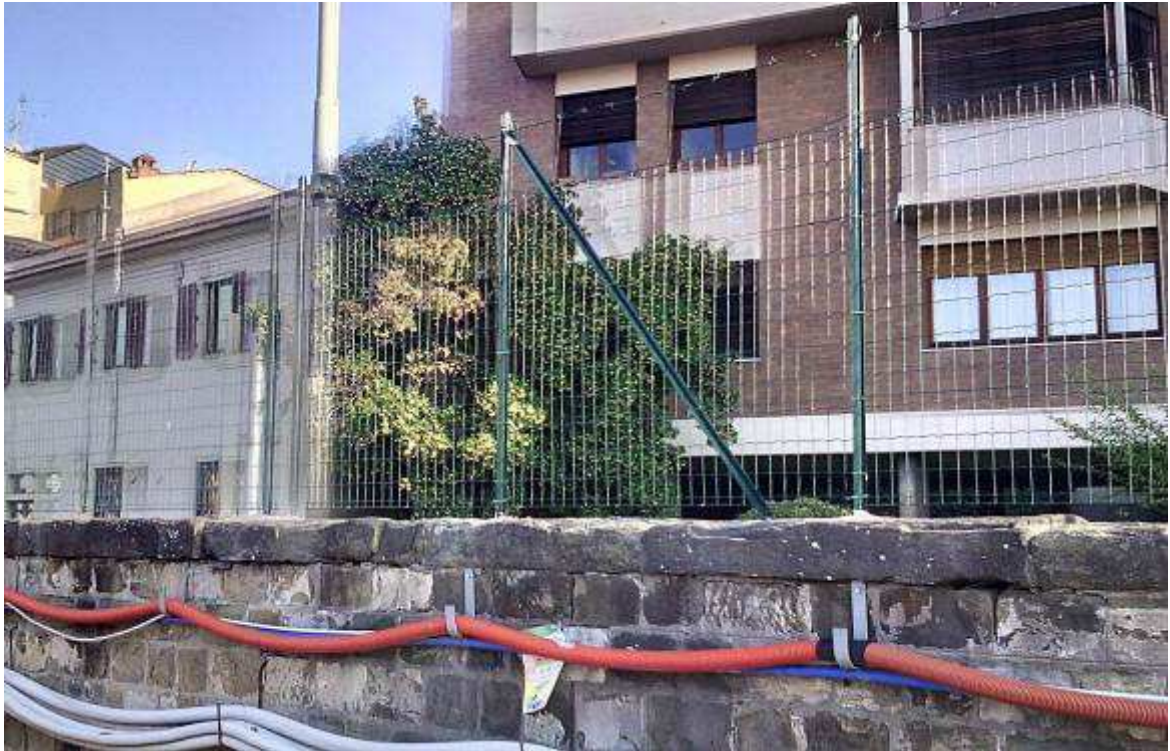
Foto 4 – Rialzo recinzione su muro via Campo d'Arrigo
