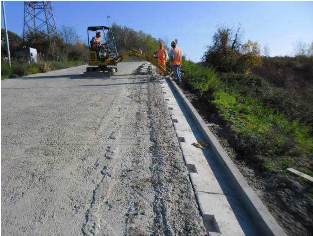
Foto 8 – Ripristino cunette viabilità di servizio
