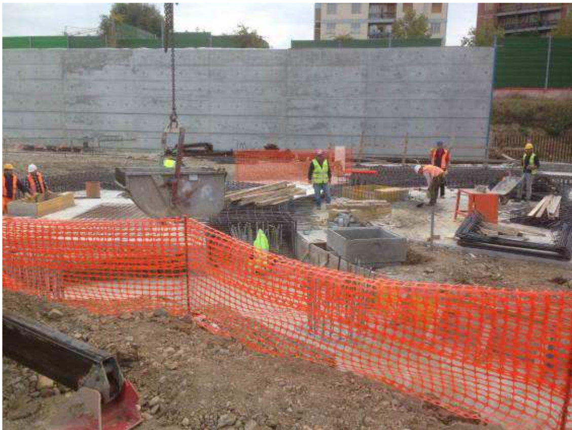
Foto 3 - Posa Armature Fondazione rampa Kiss&Ride
