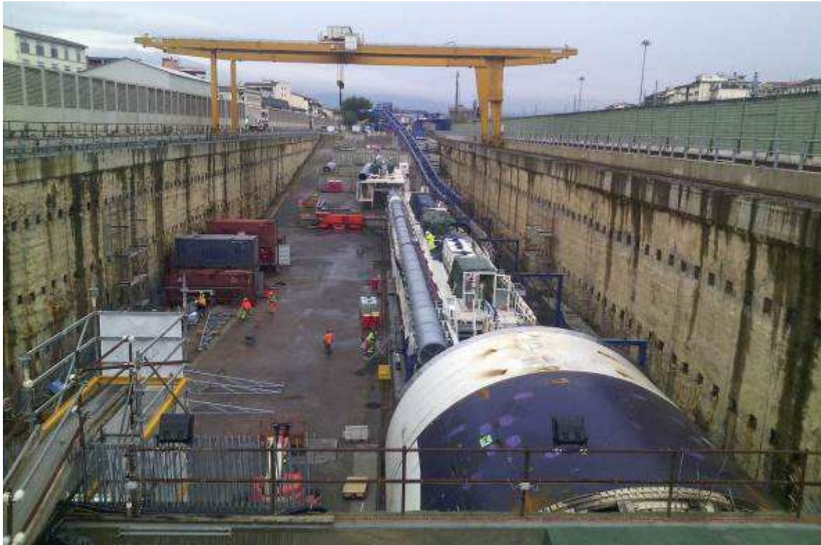
Foto 2 - Montaggio TBM
