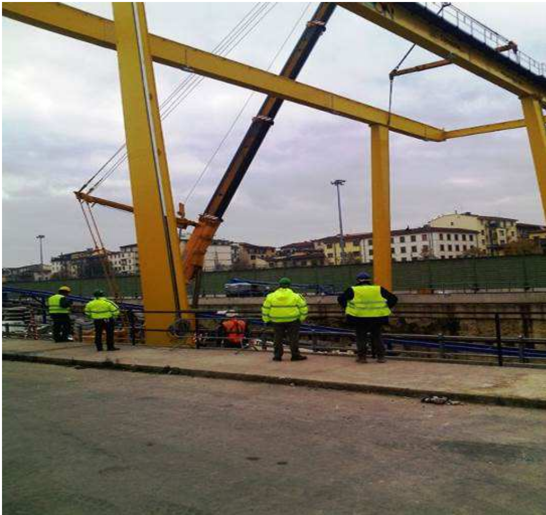
Foto 1 - Montaggio carro ponte
