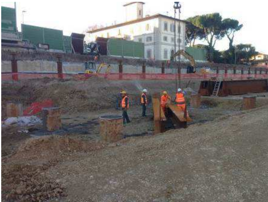
Foto 5 – Montaggio Carpenteria metallica Solaio Piano Terra
