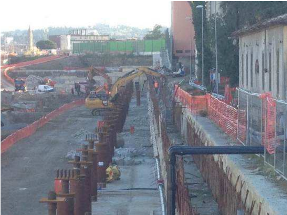
Foto 3 – Demolizione cordolo guida esterno diaframmi Camerone
