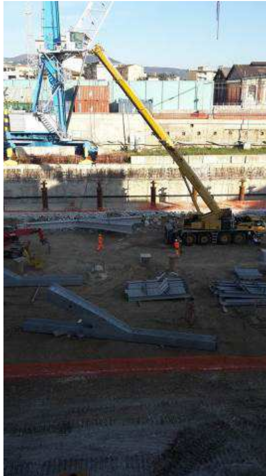
Foto 6 – Montaggio Carpenteria metallica Solaio Piano Terra
