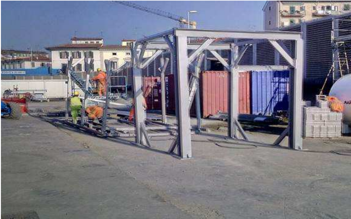
Foto 2 – Montaggio struttura filtropressa
