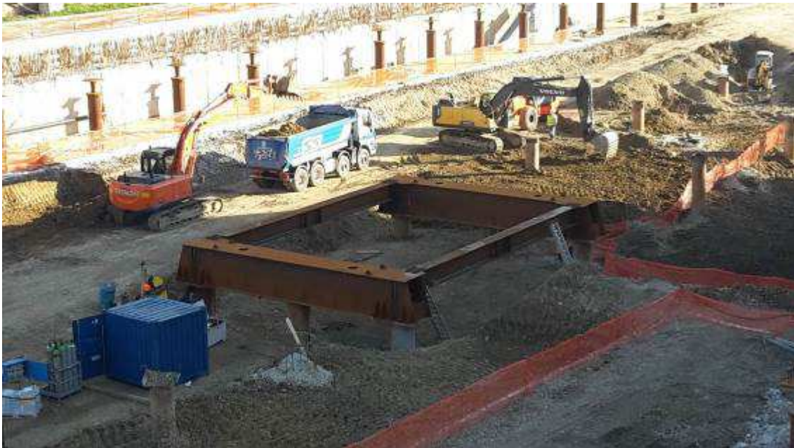
Foto 7 – Montaggio Carpenteria metallica Solaio Piano Terra
