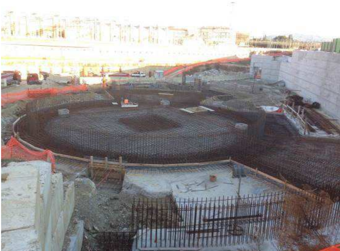
Foto 2 - Armatura fondazioni rampa Kiss&Ride
