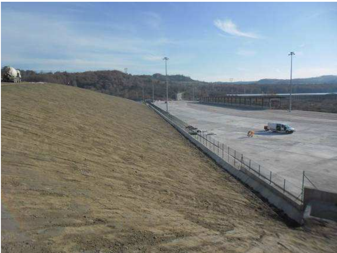
Foto 3 – Profilatura scarpata Terminal Bricchette
