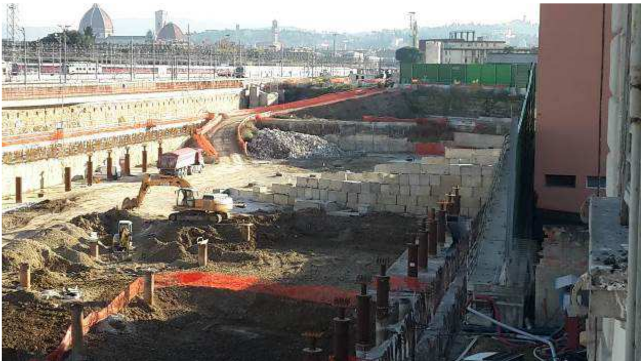
Foto 1 - Scavi di approfondimento interni al Camerone di Stazione AV
