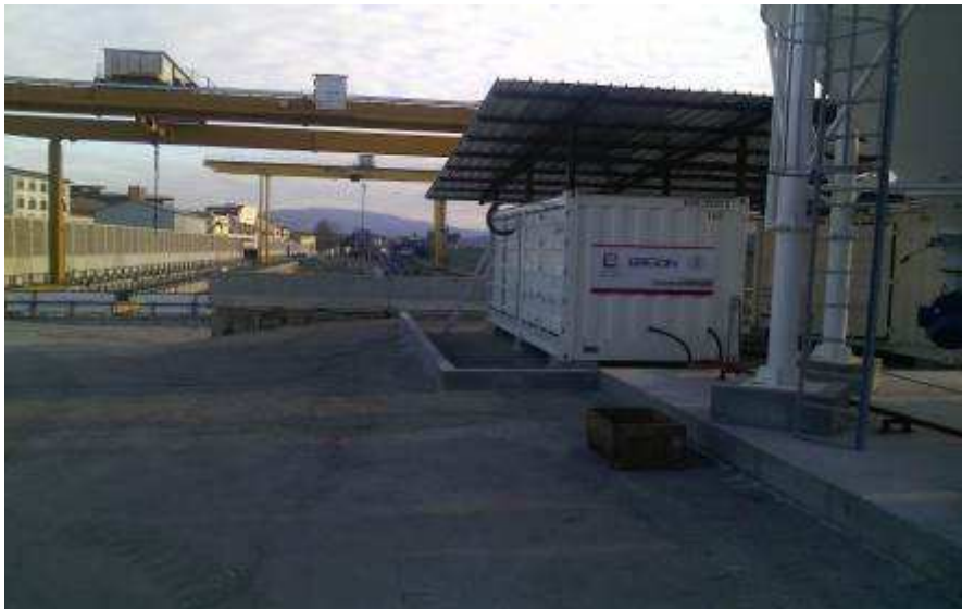
Foto 3 – Installazione impianti di cantiere
