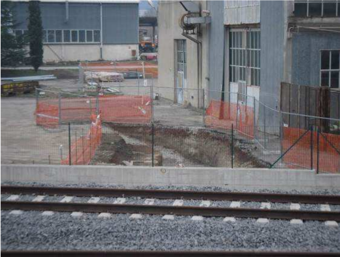
Foto 5 – Risoluzione interferenza antincendio Enel - Spingitubo
