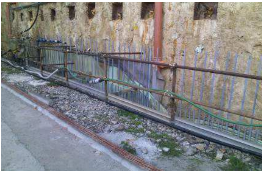
Foto 4 - Messa in sicurezza parapetti e controllo
