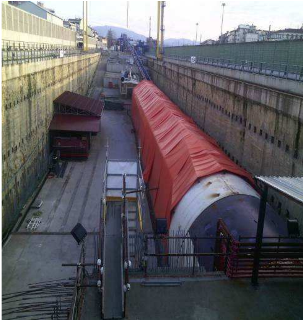
Foto 1 – Mantenimento e controllo TBM
