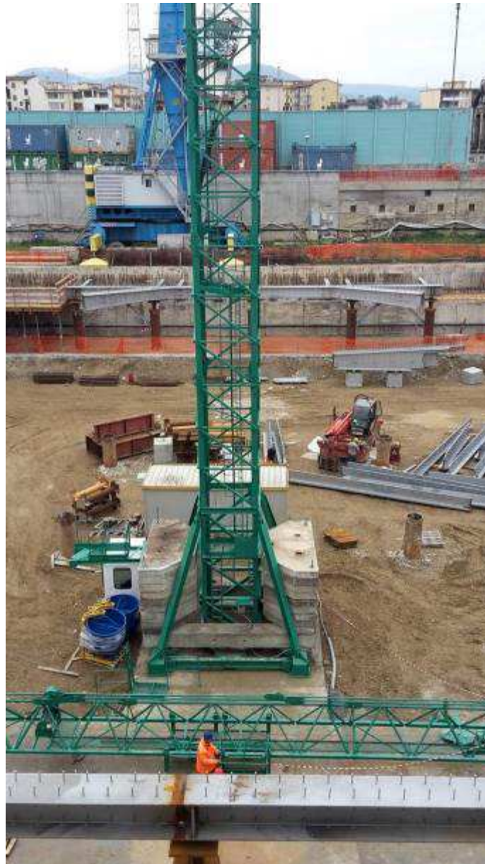
Foto 6 – Montaggio gru a torre
