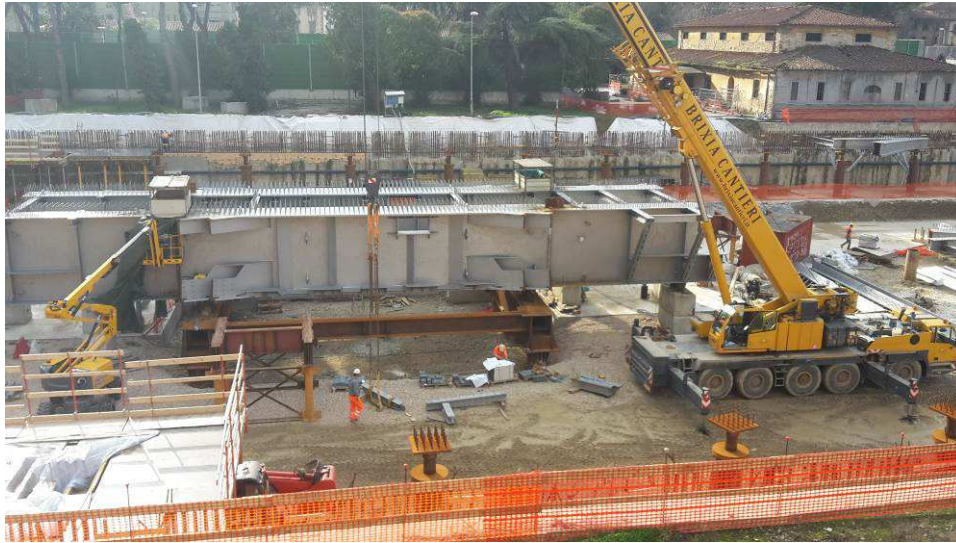
Foto 2 – Montaggio carpenterie metalliche Solaio Piano Terra – Cassone asse 17
