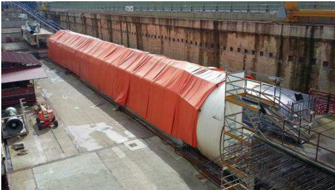
Foto 1 – Mantenimento e controllo TBM
