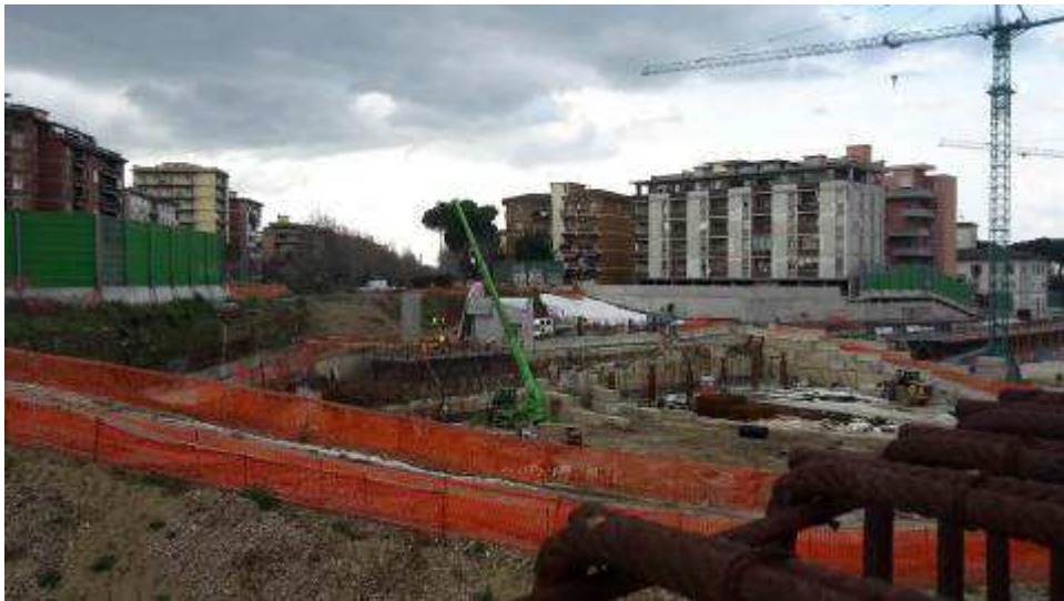
Foto 6 – Realizzazione vasca di accumulo acque meteoriche presso la Rampa K&R
