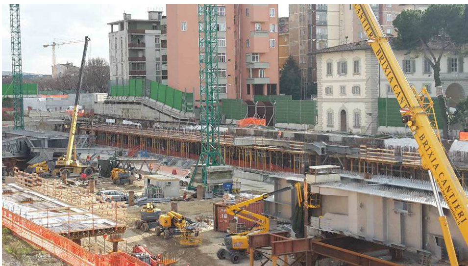
Foto 2 – Montaggio banchinaggi per getto trave cuscino
