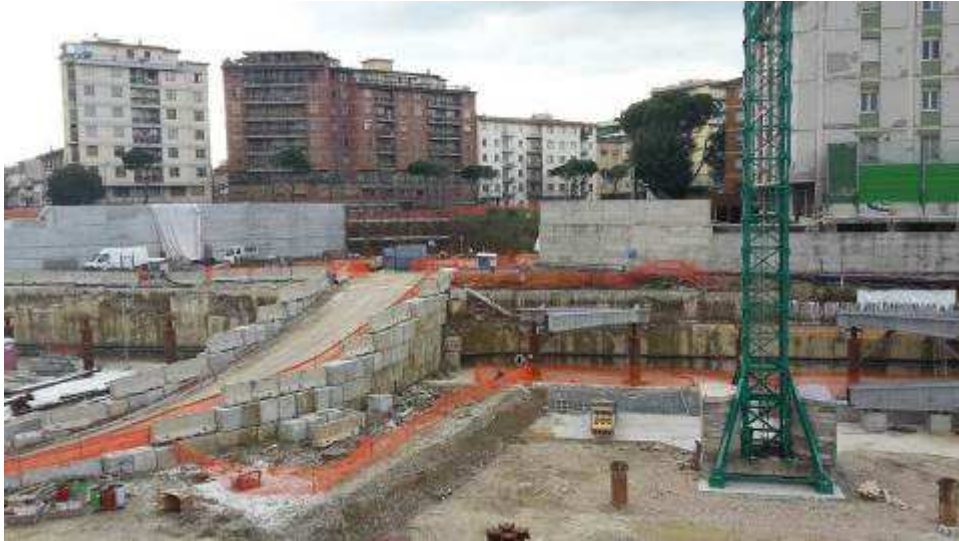
Foto 5 – Realizzazione elevazione Rampa K&R
