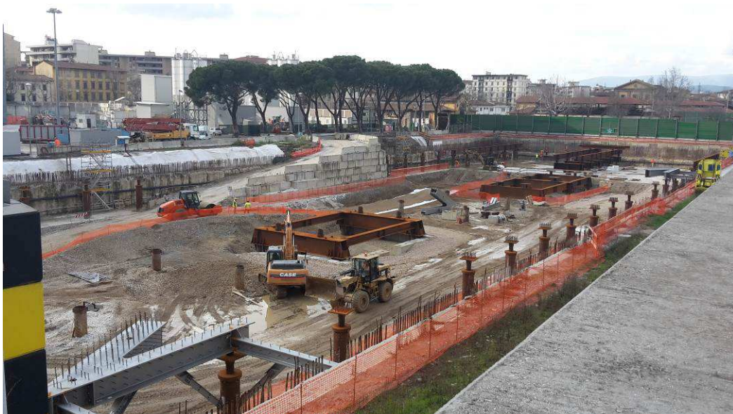
Foto 1 – Lavorazioni Testata Nord
