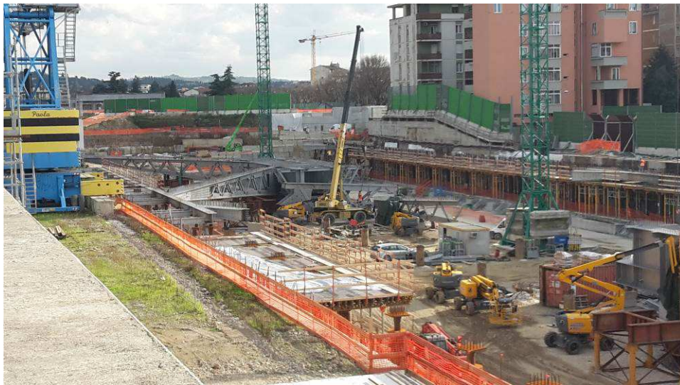
Foto 3 – Montaggio carpenterie metalliche Solaio Piano Terra – Cassone asse 25
