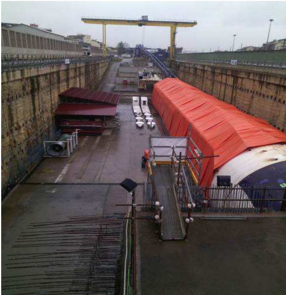
Foto 1 – Manutenzione e controllo TBM
