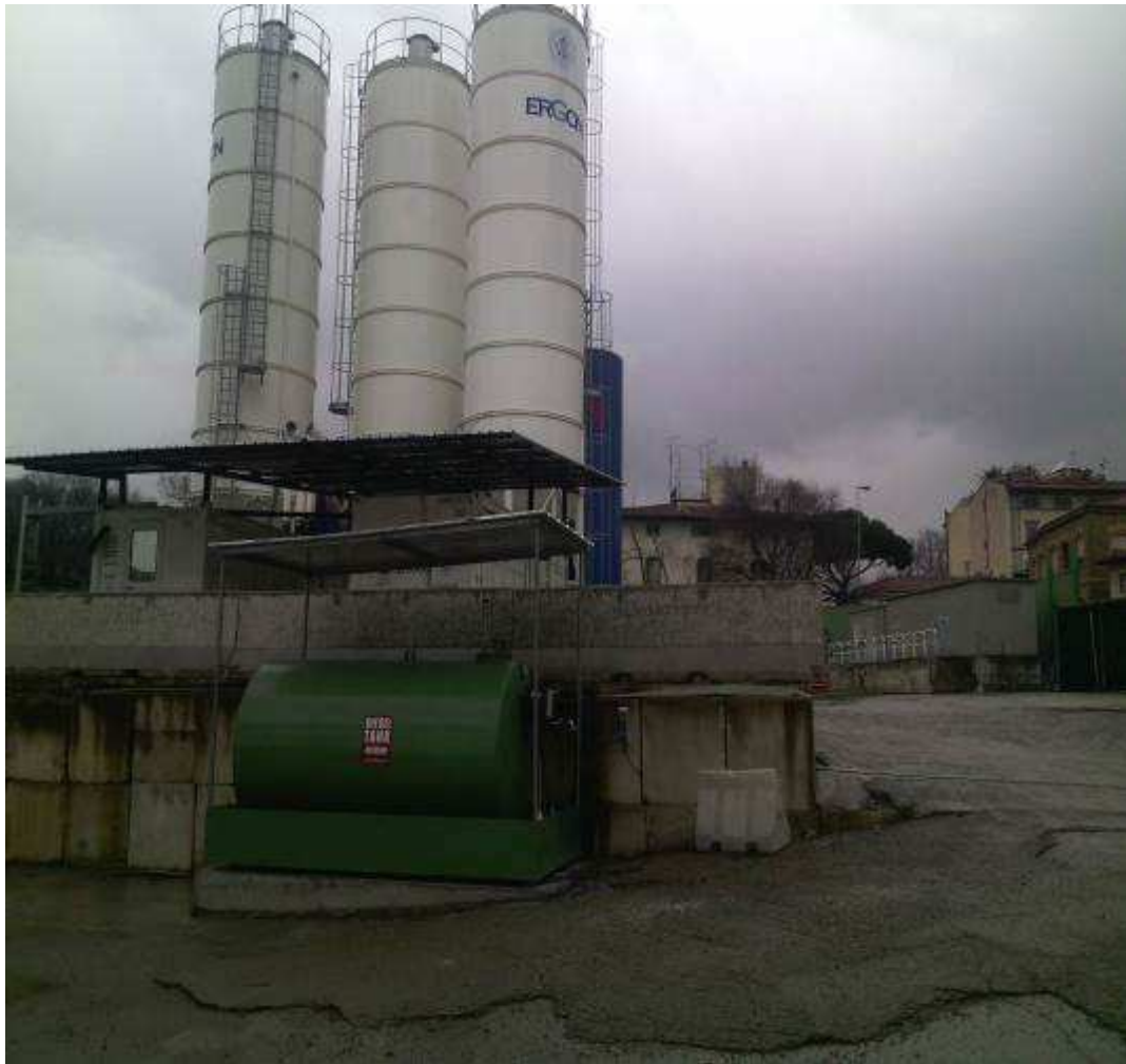
Foto 2 – Manutenzione e controllo TBM
