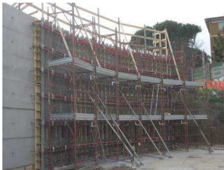
Foto 7 – Realizzazione elevazione Rampa K&R
