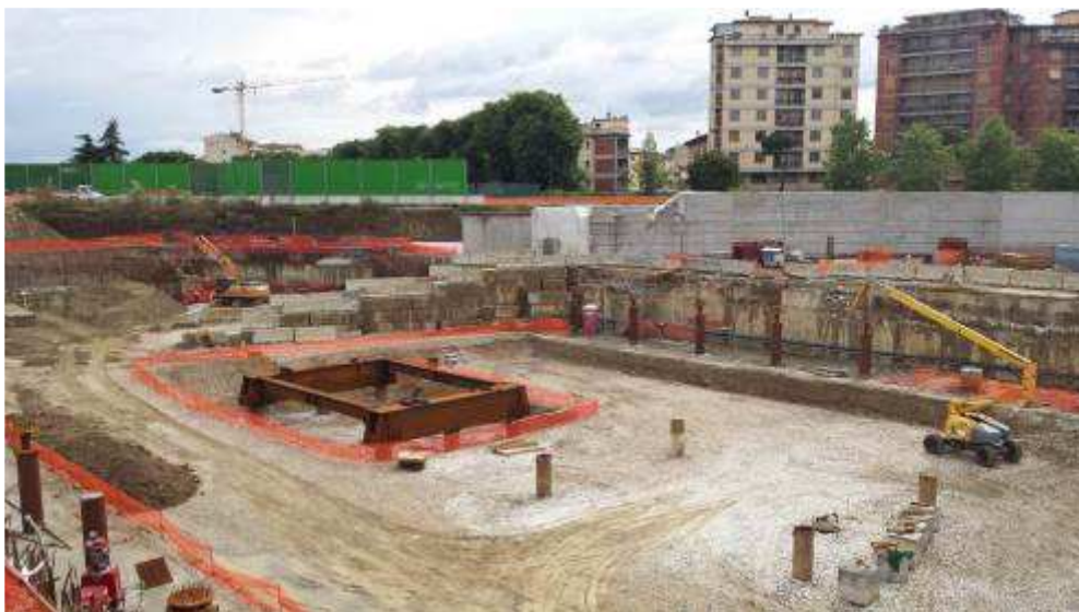
Foto 8 – Montaggio Travoni TP per appoggio Cassone Asse 33
