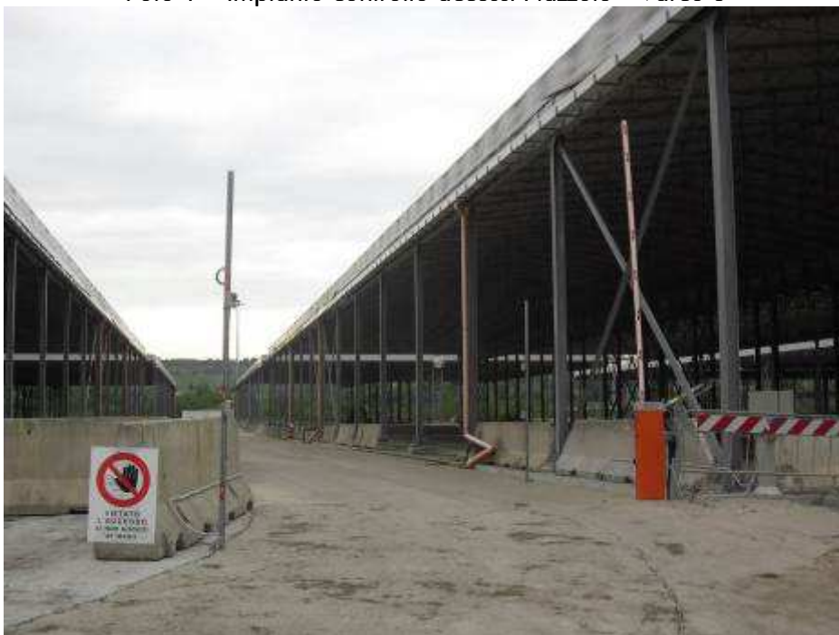
Foto 2 – Impianto controllo accessi Piazzole – Varco 6
