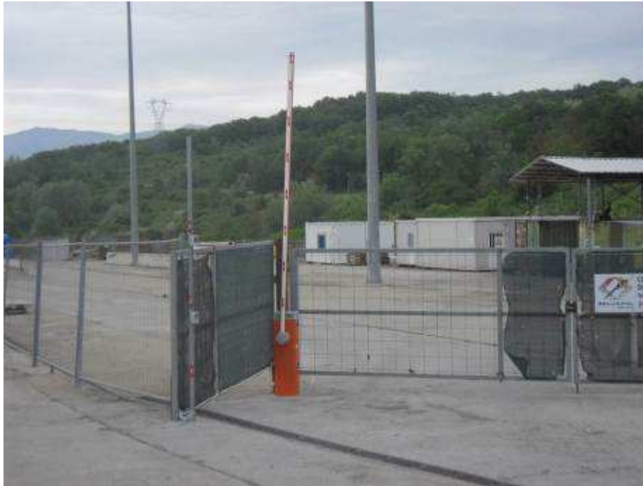
Foto 1 – Impianto controllo accessi Piazzole – Varco 5
