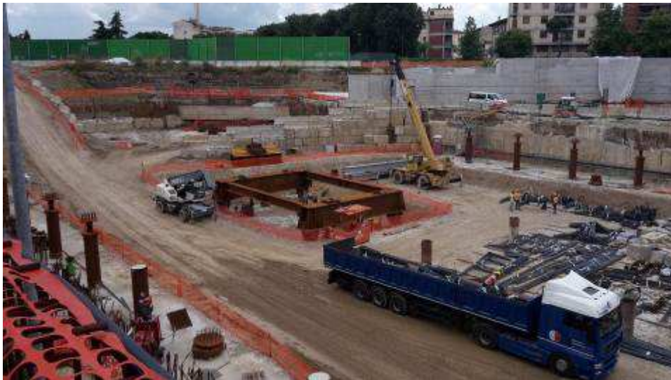
Foto 8 – Montaggio Travoni TP per appoggio Cassone Asse 33
