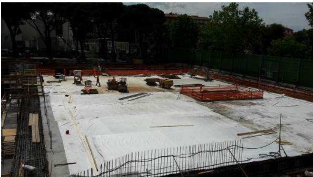
Foto 1 – Lavorazioni Testata Nord – Filo 1-3
