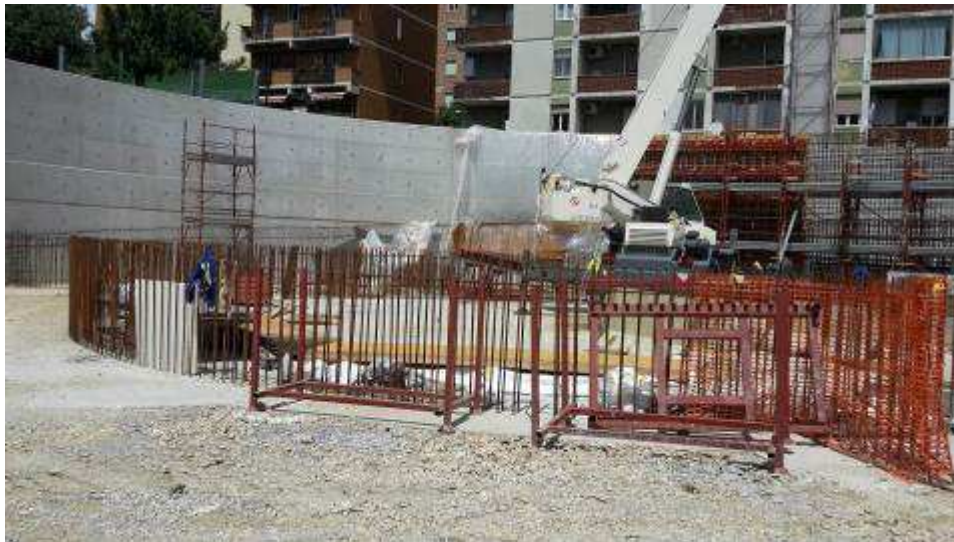
Foto 9 – Montaggio Armatura e Getto Rampa Kiss & Ride
