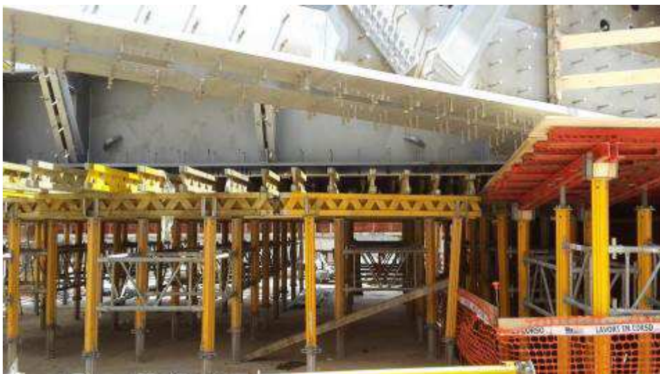
Foto 7 – Banchinaggio e montaggio armatura fondo cassone asse 25
