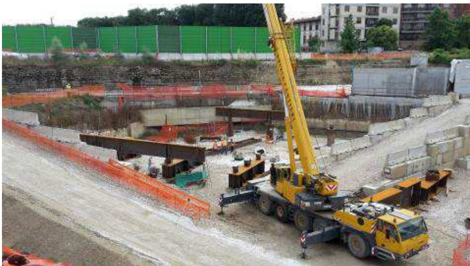
Foto 9 – Montaggio Strutture provvisorie Testata Sud
