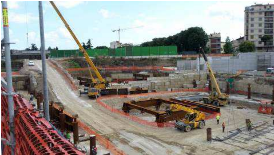
Foto 8 – Montaggio Travoni TP per appoggio Cassone Asse 33
