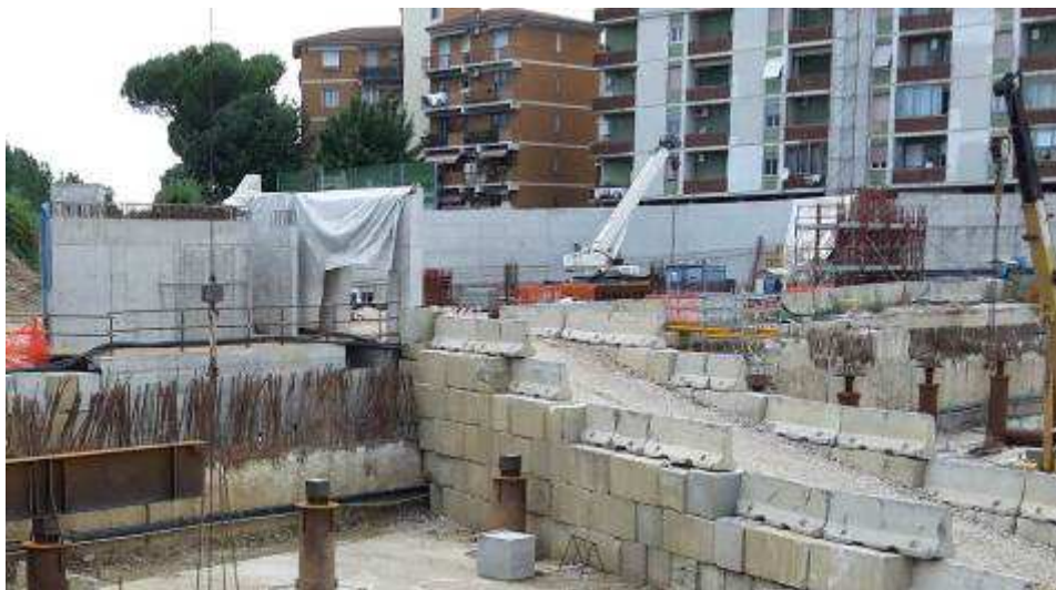
Foto 13 – Montaggio Armatura e Getto Rampa Kiss & Ride
