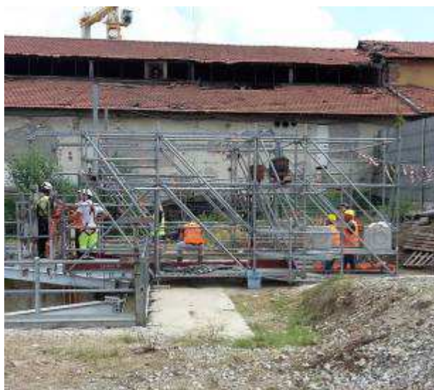
Foto 16 – Pozzo Nord - Montaggio Navicella e corso di formazione
