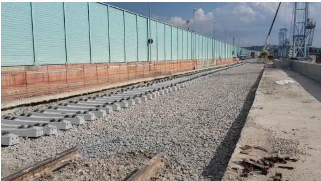
Foto 1 – Interventi per la chiusura della NC 63
