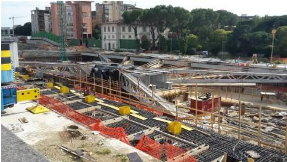
Foto 6 – Posa armatura e getto Trave cuscino Fili 13-21 lato Est
