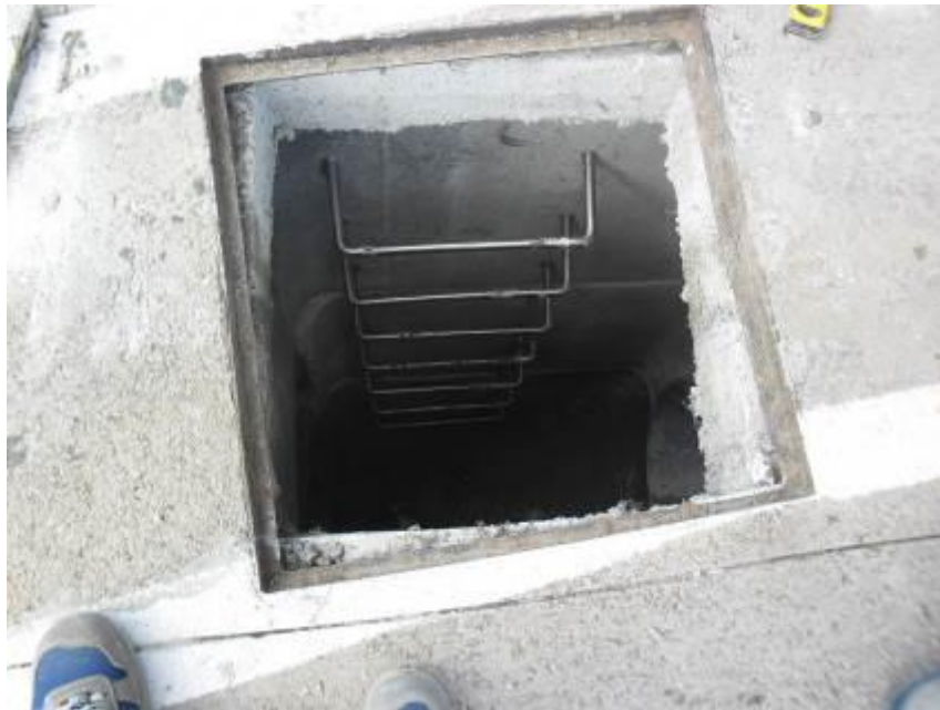
Foto 4 – Posa gradini nei pozzetti dell'idraulica del Terminal
