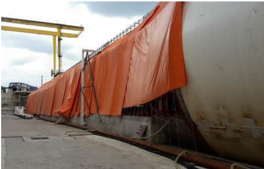
Foto 1 – Manutenzione e controllo della TBM
