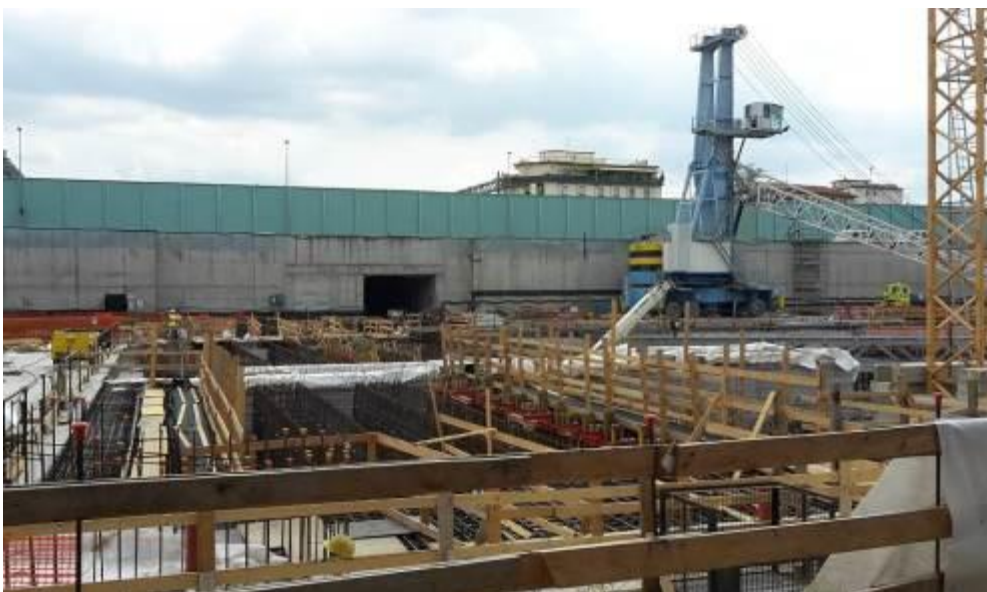
Foto 4 – Solaio Fili 3-5 - Getto Trave 1 e 4 lato Ovest
