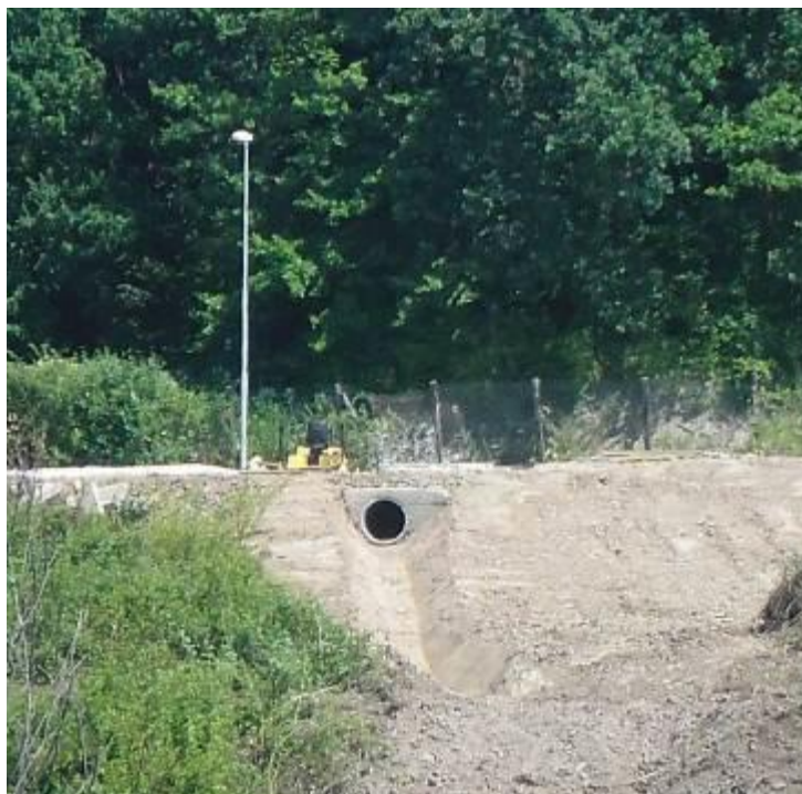
Foto 2 – Interventi per la Risoluzione della NC171 – Attraversamento idraulico
