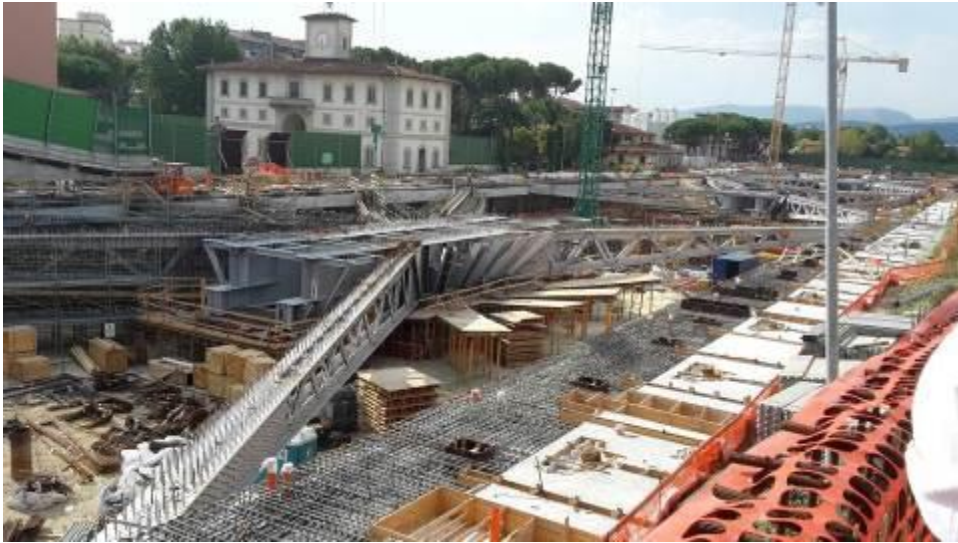
Foto 8 – Banchinaggio Travi intermedie, corte e lunghe-lato Est, Ventaglio Asse 25
