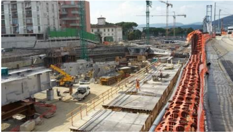
Foto 11 – Banchinaggio Trave cuscino Fili 29-34 lato Est
