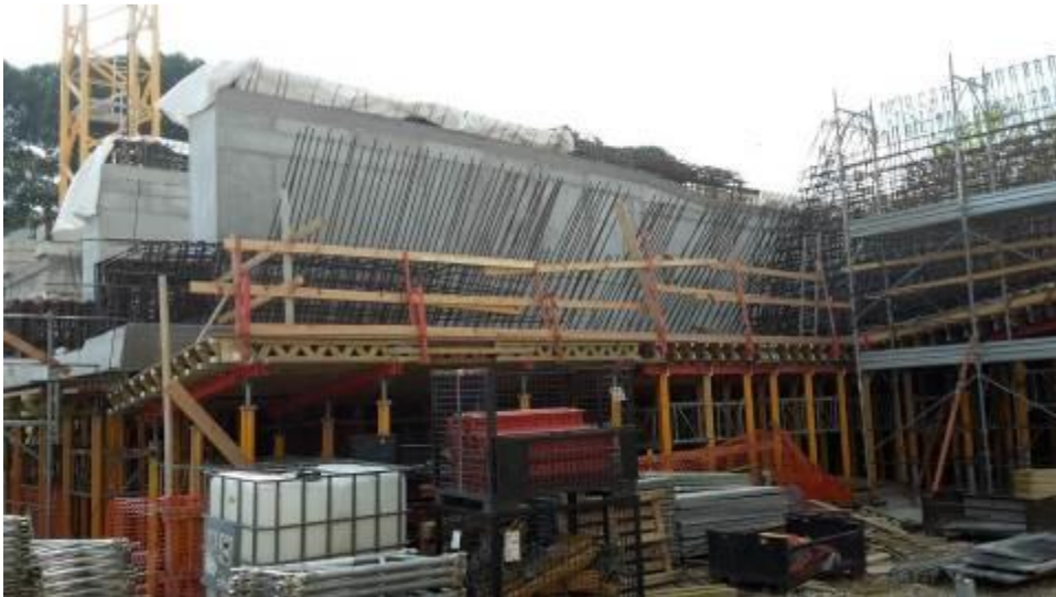
Foto 3 – Smontaggio Casseri pareti Cassone Centrale Fili 4-5
