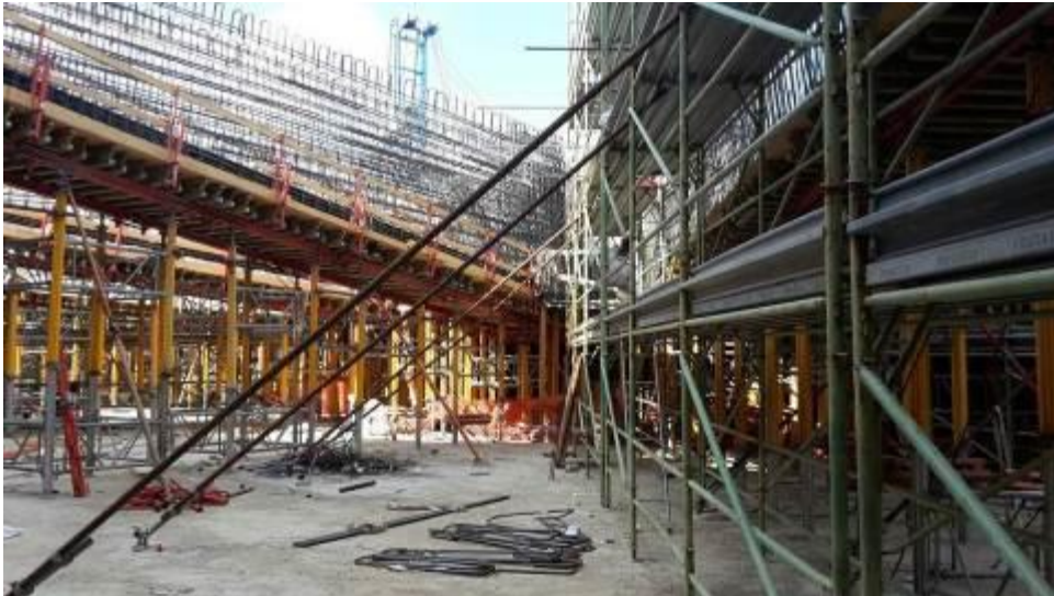
Foto 9 – Montaggio armatura Travi intermedie, corte e lunghe lato Ovest, Ventaglio Asse 25
