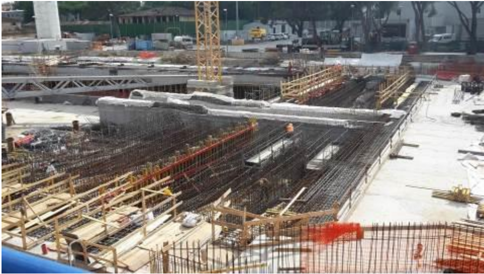
Foto 2 – Banchinaggio e montaggio armatura Travi Fili 4-5
