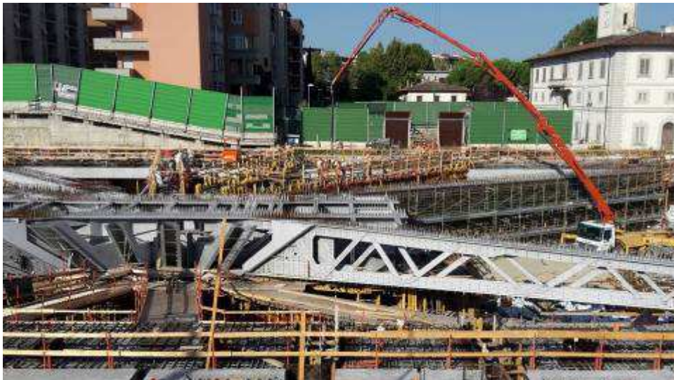
Foto 6 – Getto Travi intermedie e corte lato Ovest, Ventaglio Asse 25
