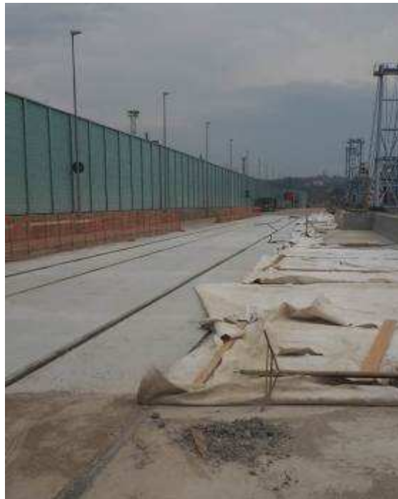
Foto 1 – Interventi per la chiusura della NC 63
