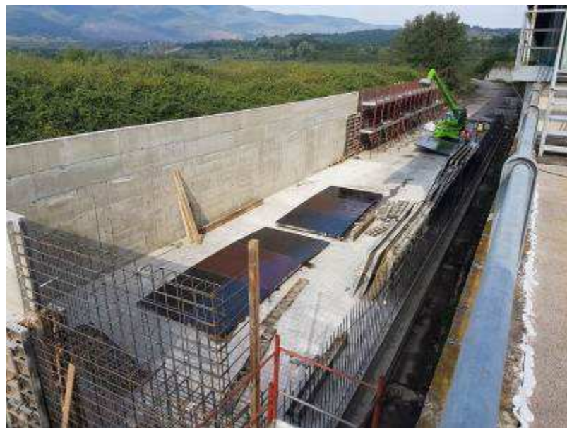
Foto 2 – Realizzazione Vasca di accumulo acque Collina Schermo
