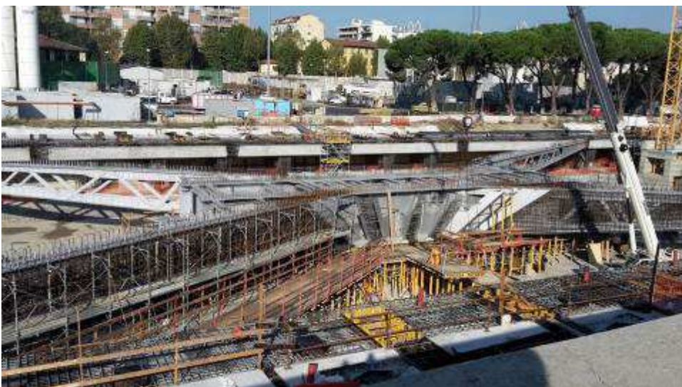
Foto 4 – Banchinaggio Travi intermedie e corte lato Est Ventaglio Asse 9
