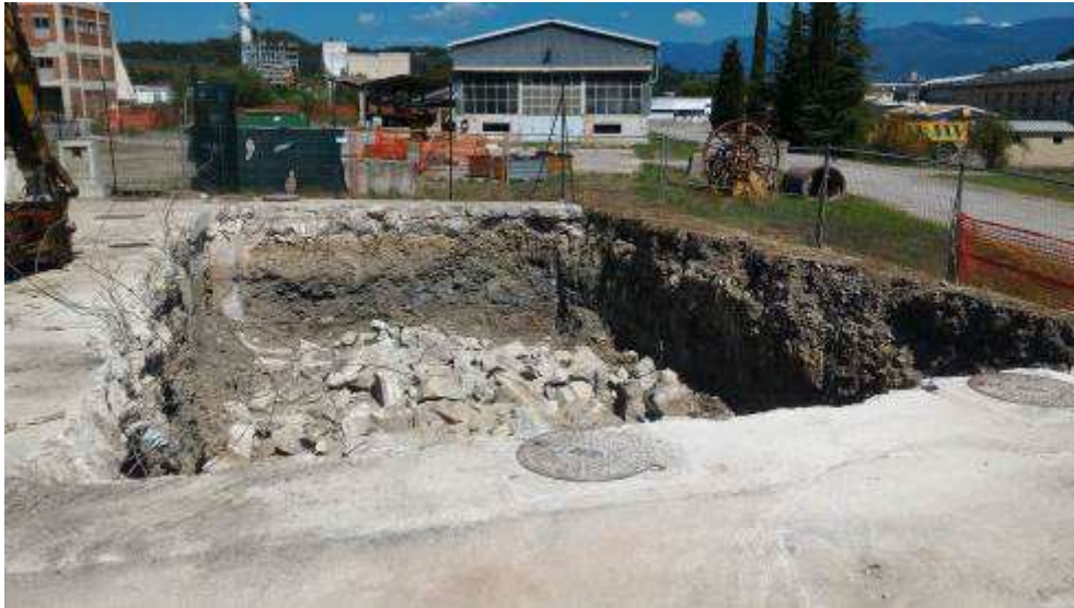
Foto 3 – Demolizione pavimentazione e scavo per Risoluzione NC177
