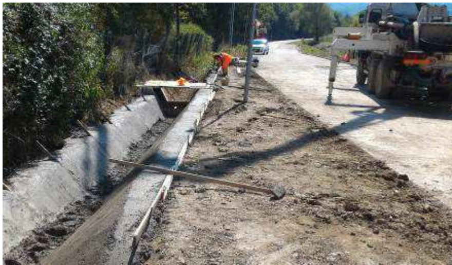
Foto 1 – Interventi per la Risoluzione della NC171 – Ripristino viabilità
