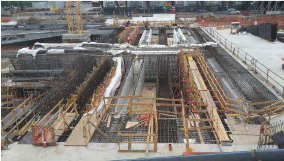
Foto 2 – Getto Travi solaio Fili 4-5
