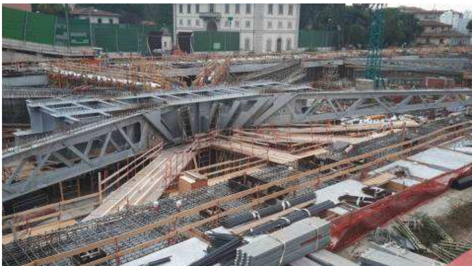
Foto 7 – Banchinaggio Travi intermedie e corte lato Est, Ventaglio Asse 25
