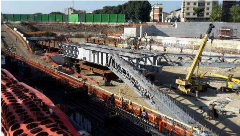
Foto 8 – Montaggio carpenterie metalliche Ventaglio Asse 33
