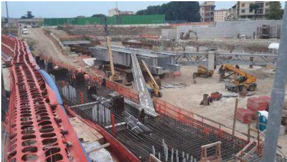
Foto 9 – Montaggio armatura Trave cuscino Fili 29-34 lato Est
