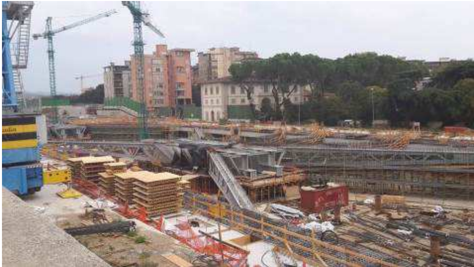
Foto 5 – Montaggio armatura Travi lato Ovest e banchinaggio Travi lato Est, Ventaglio Asse 17
