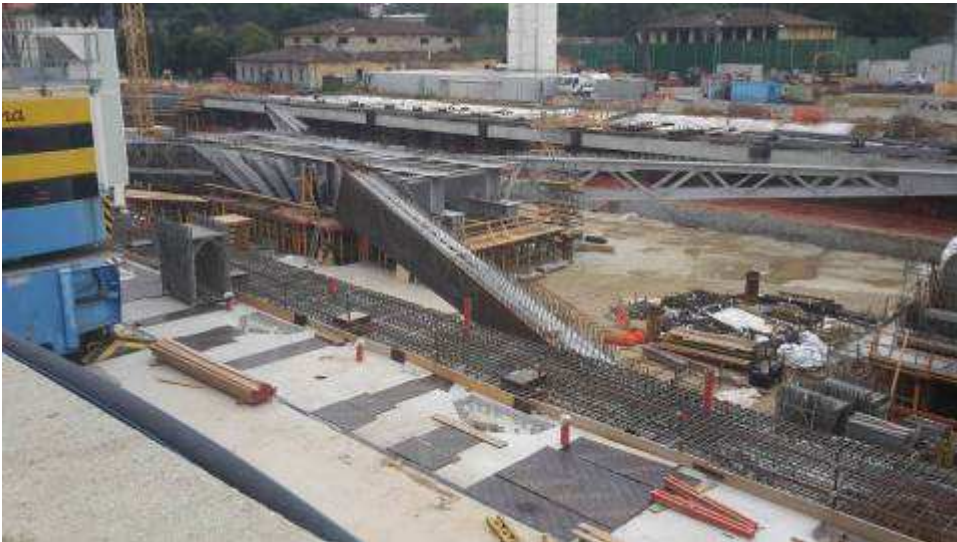
Foto 3 – Montaggio armatura Travi lunghe lato Est Ventaglio Asse 9
