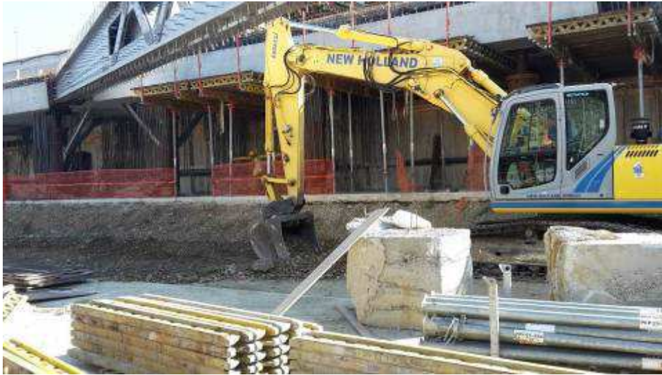
Foto 11 – Scavo per realizzazione del “Tunnel” di passaggio dei mezzi sotto i banchinaggi
