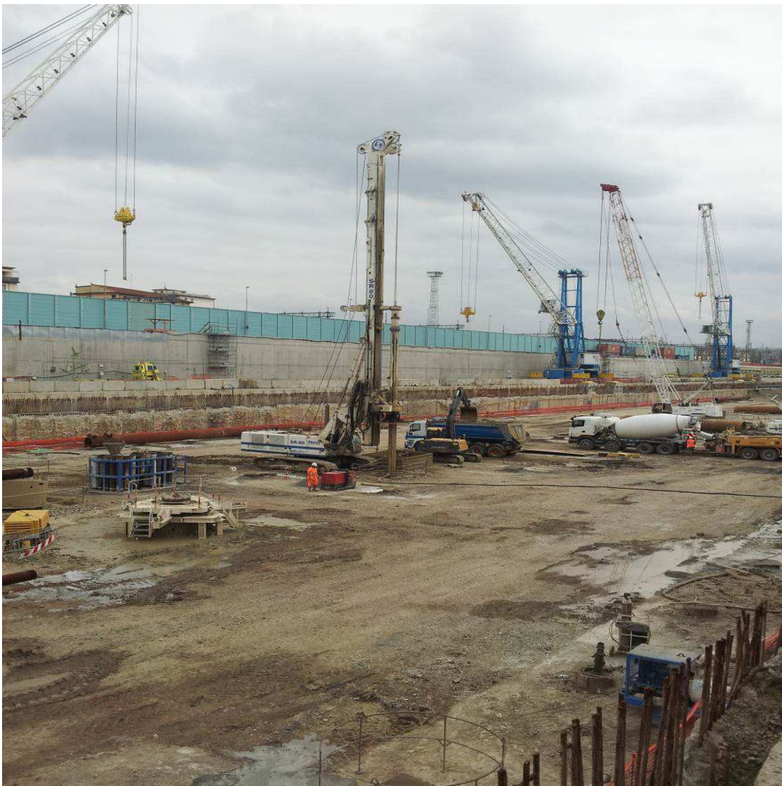
FOTO 1 – Realizzazione pali fondazione
