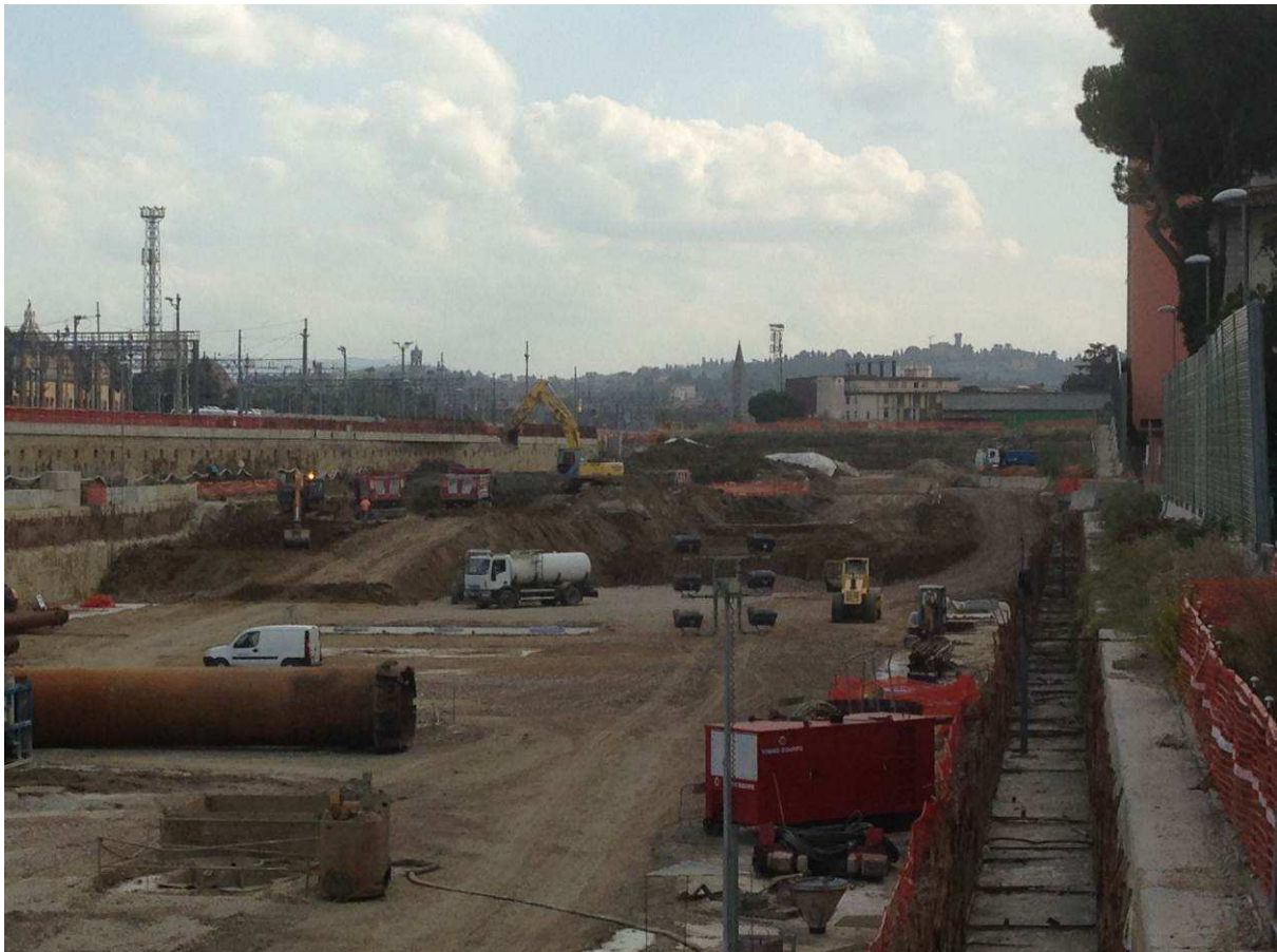
FOTO 2 – Scavo e allontanamento terre interne al camerone
