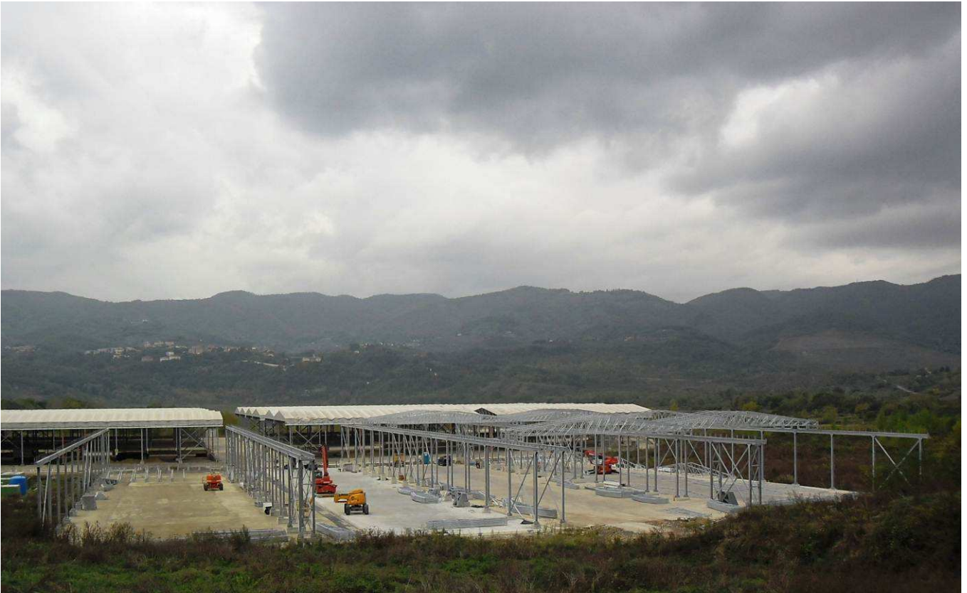
FOTO 1 – Montaggio coperture Piazzola 7 e 8
