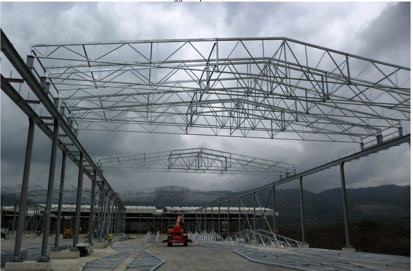
FOTO 2 – Montaggio coperture Piazzola 7 e 8
