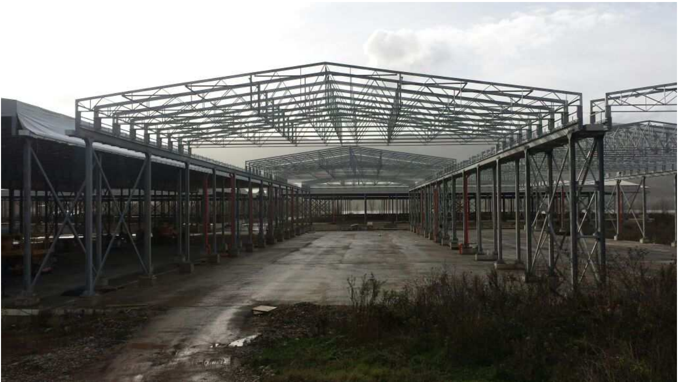
FOTO 2 – Montaggio coperture Piazzole 7 e 8
