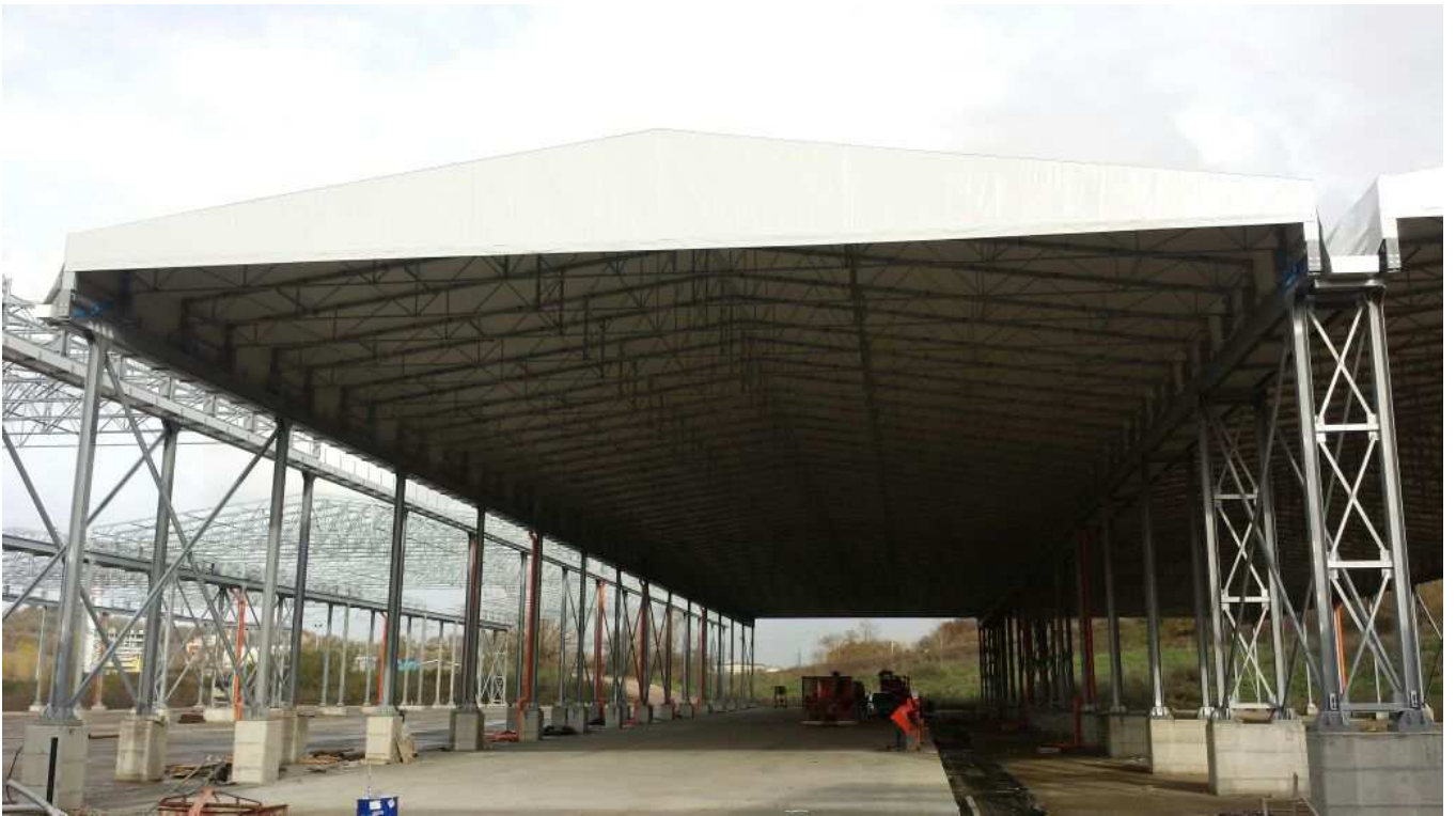
FOTO 1 – Montaggio coperture Piazzole 7 e 8
