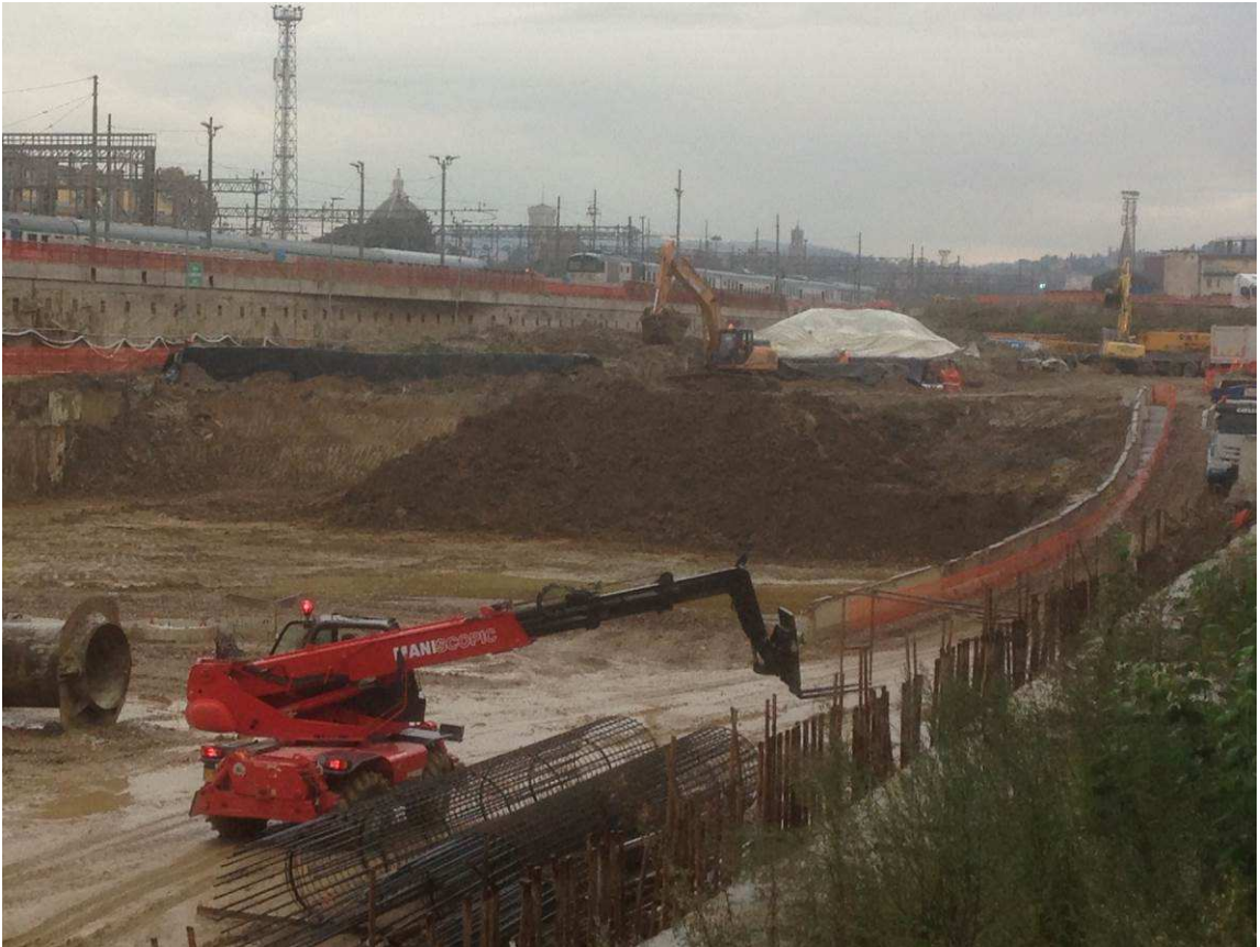
FOTO 2 – Scavo e allontanamento terre interne al camerone
