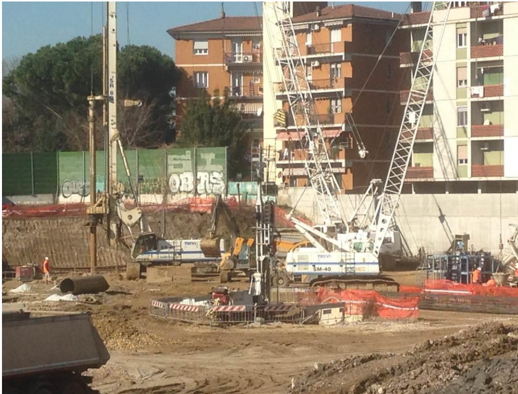
FOTO 1– Realizzazione pali Rampa kiss&ride
