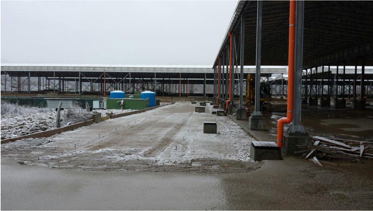
FOTO 1 – Completamento viabilità Piazzole 7 e 8
