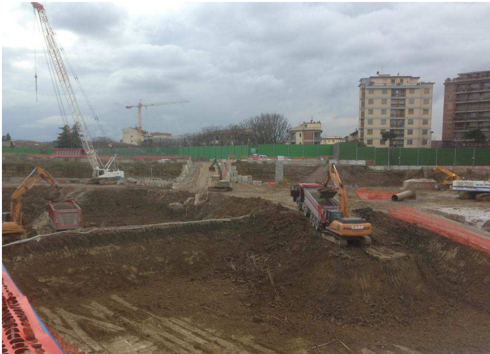
FOTO 1– Scavo di sbancamento all'interno del camerone
