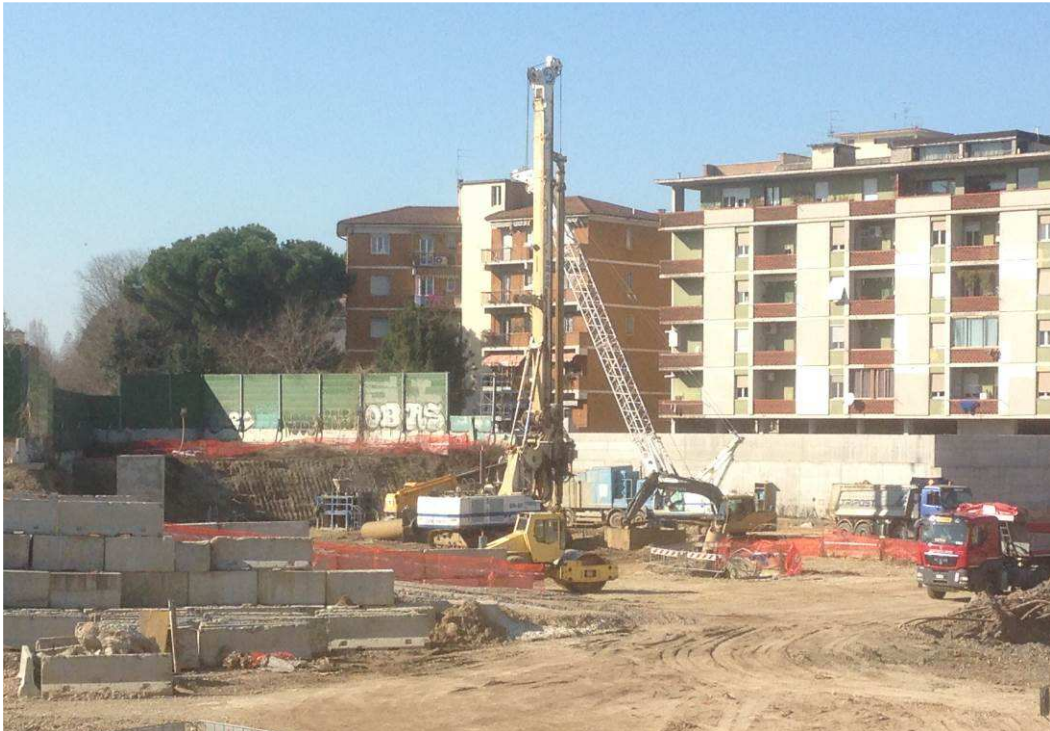
FOTO 2– Realizzazione pali Rampa kiss&ride
