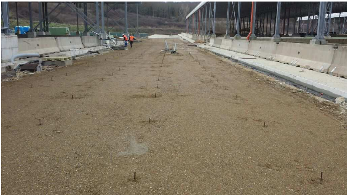
FOTO 1 – Completamento viabilità Piazzole 7 e 8
