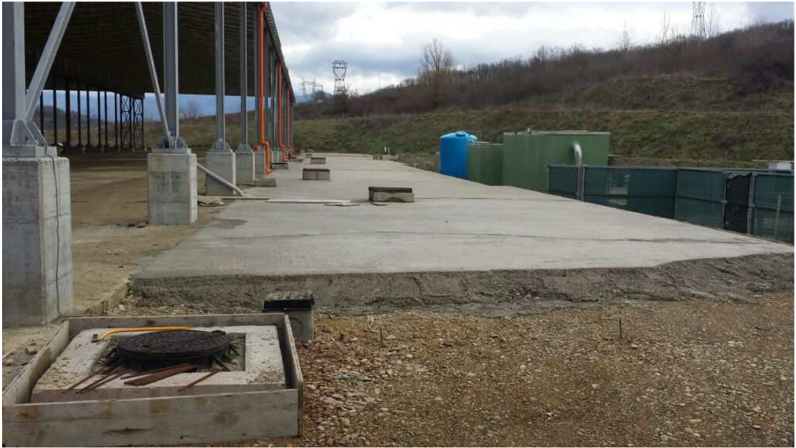
FOTO 2 – Completamento viabilità Piazzole 7 e 8
