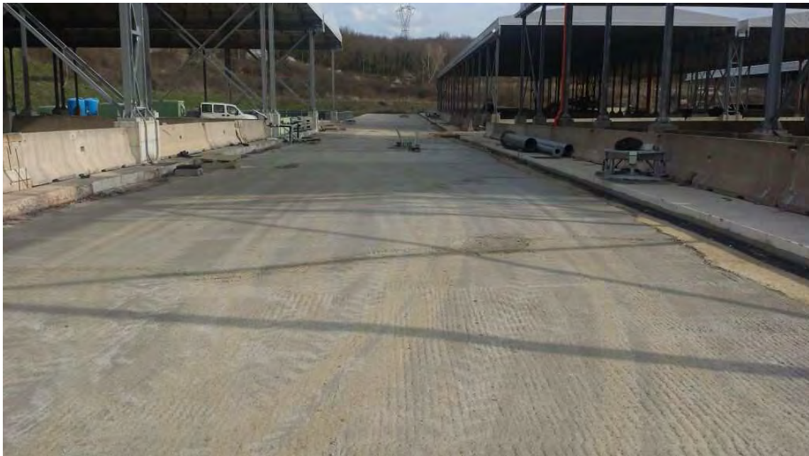
FOTO 2 – Completamento viabilità Piazzole 7 e 8
