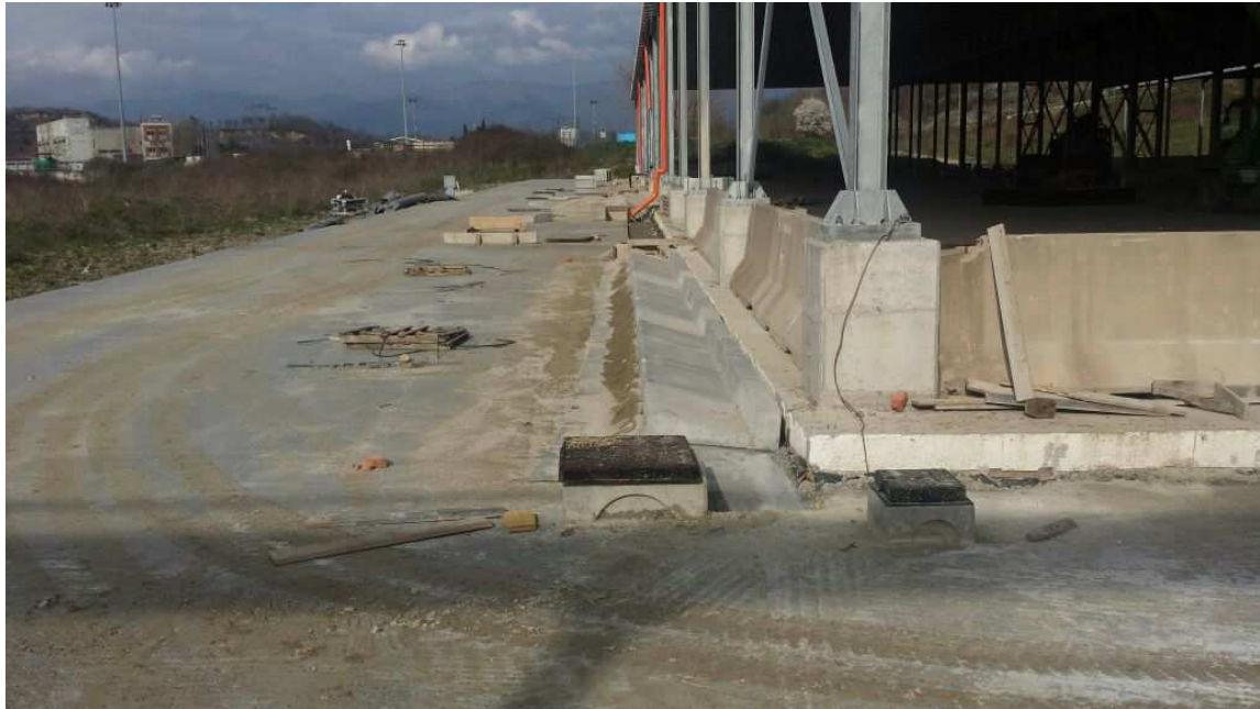
FOTO 1 – Completamento viabilità Piazzole 7 e 8
