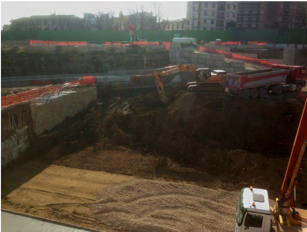
FOTO 1– Scavo all'interno del camerone di stazione
