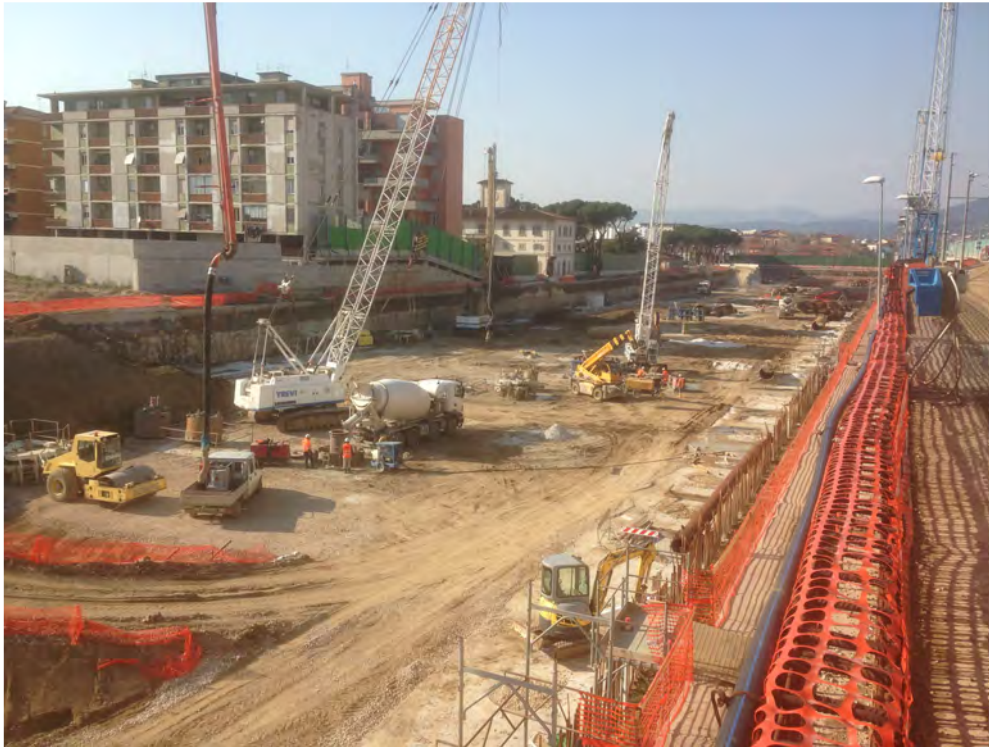
FOTO 2– Realizzazione pali camerone di stazione
