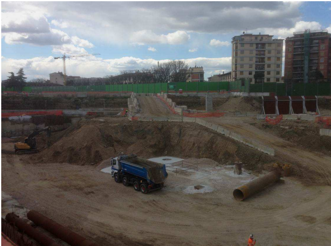
FOTO 1– Scavo all'interno del camerone di stazione
