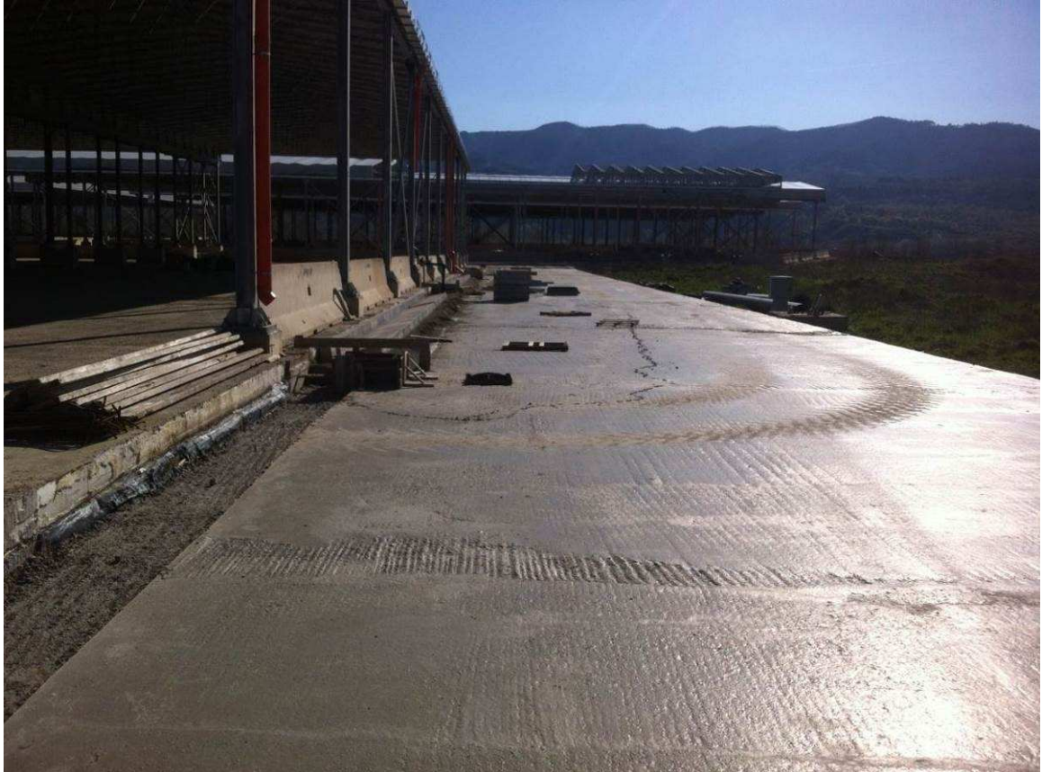
FOTO 1 – Completamento viabilità Piazzole 7 e 8
