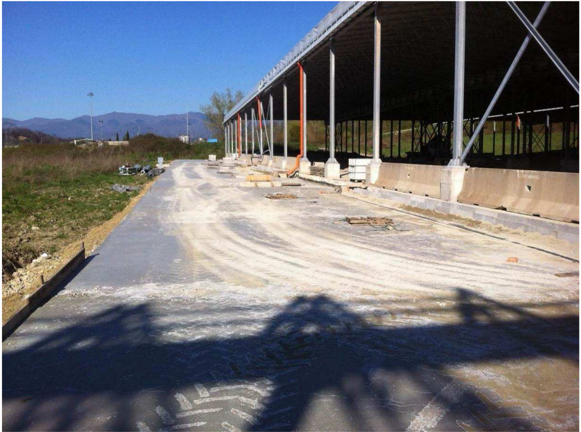
FOTO 2 – Completamento viabilità Piazzole 7 e 8
