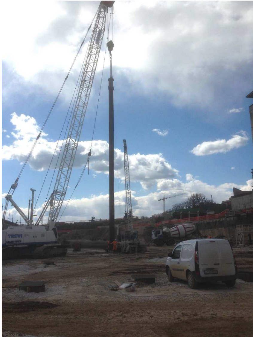
FOTO 2– Realizzazione pali camerone di stazione
