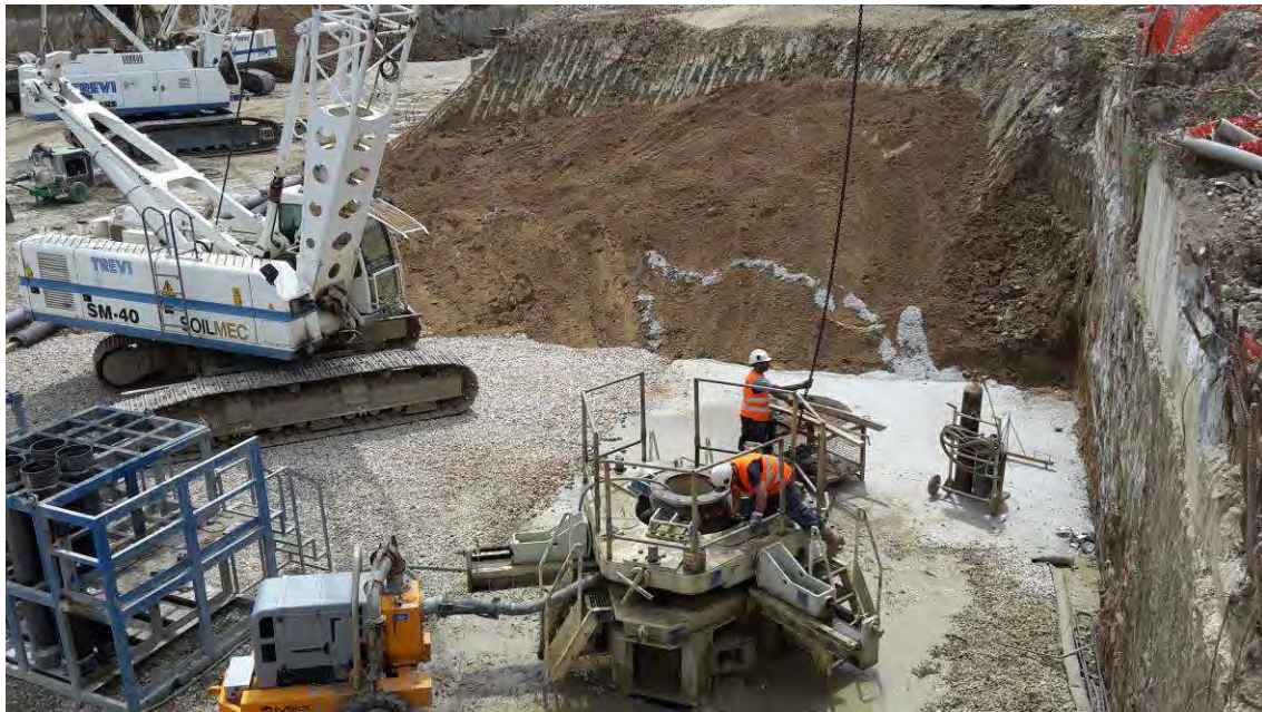
FOTO 2– Realizzazione pali di fondazione camerone Stazione AV
