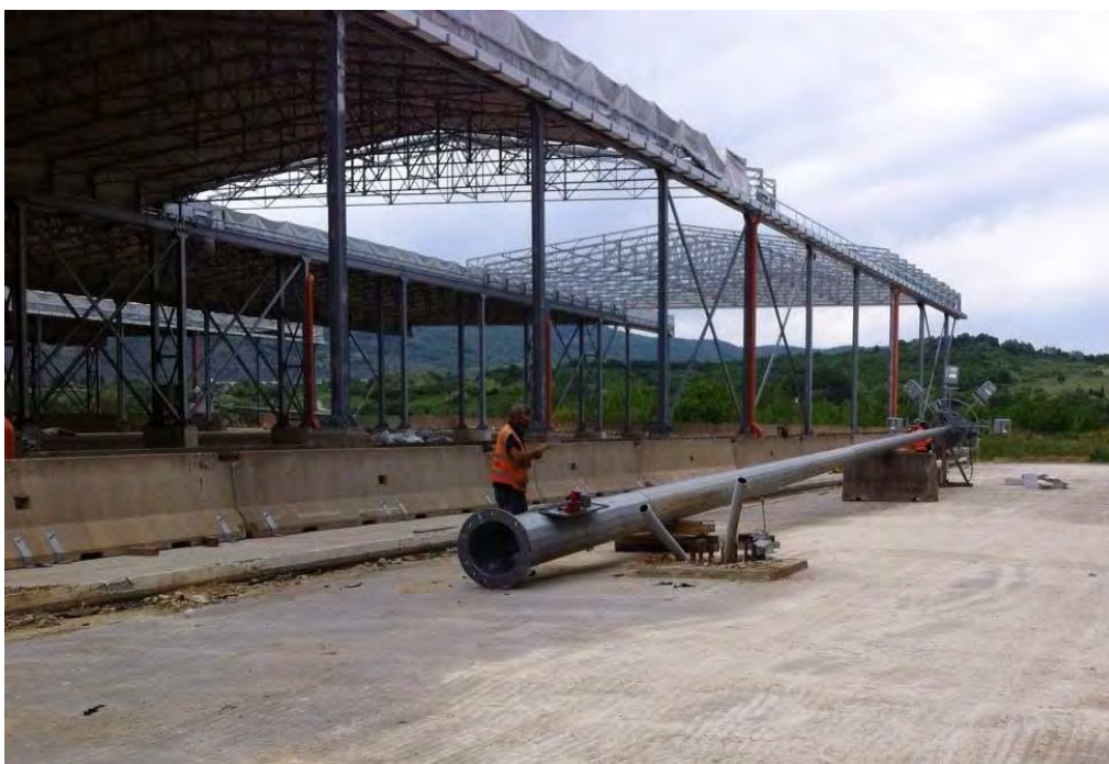
FOTO 2 – Assemblaggio Torri Faro
