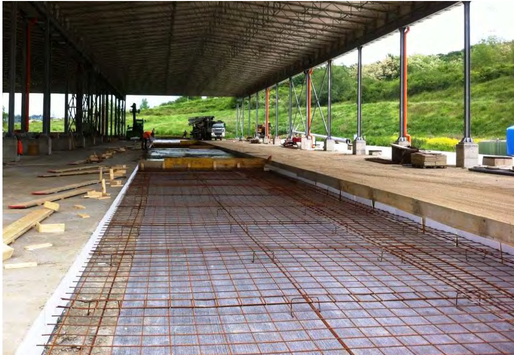
FOTO 1 – Completamento soletta pavimentazione piazzola 8
