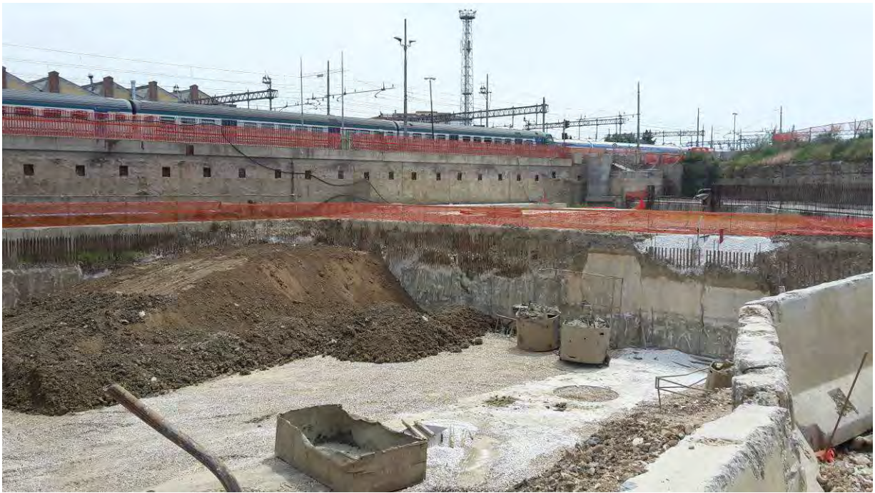
FOTO 1– Sbancamento Terre da q. +46,00 a +41,00
