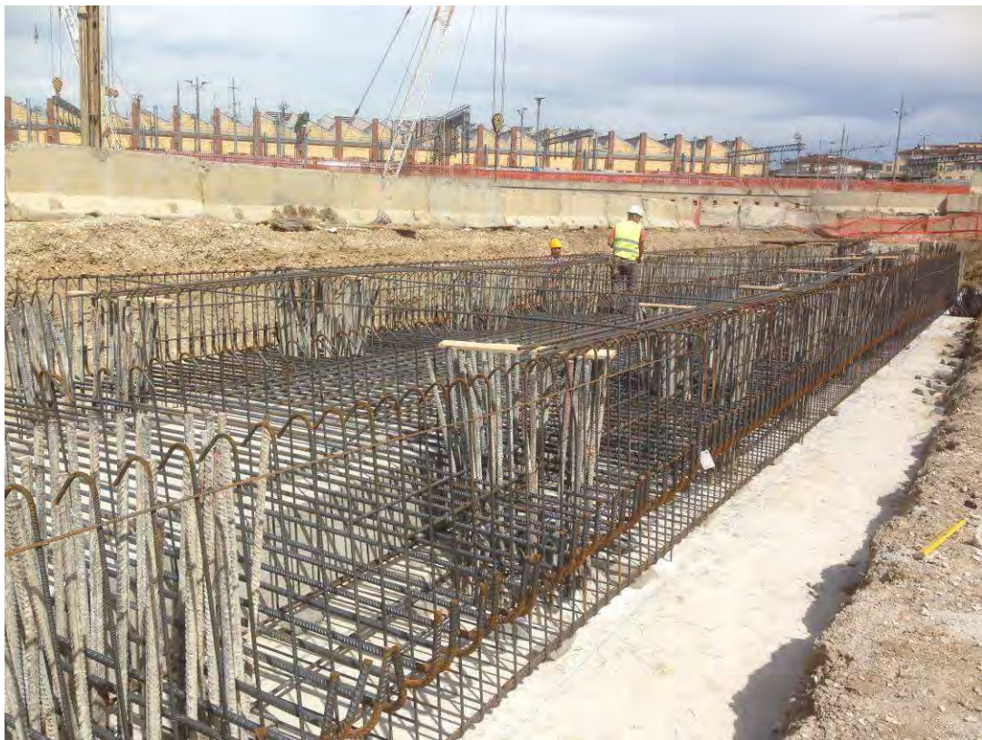
FOTO 1– Realizzazione della fondazione della Rampa Kiss&Ride
