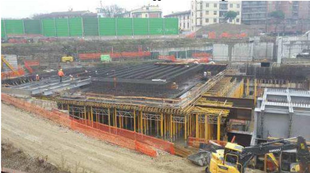
**Foto 6 – Banchinaggio e Montaggio armatura Testata Sud - lato Ovest**
