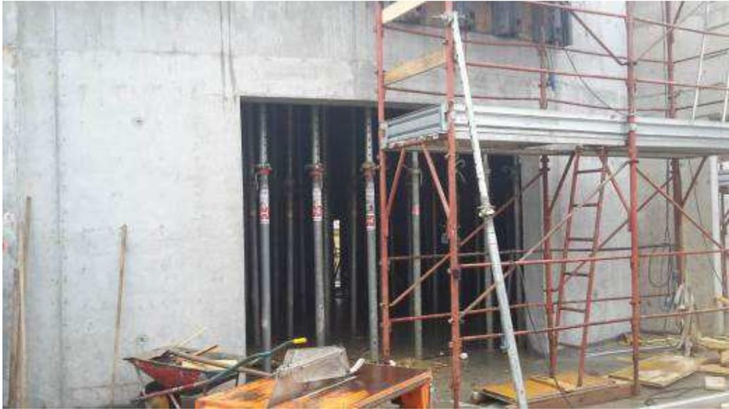
**Foto 8 – Montaggio Casseri Solaio, Rampa Kiss&Ride**
