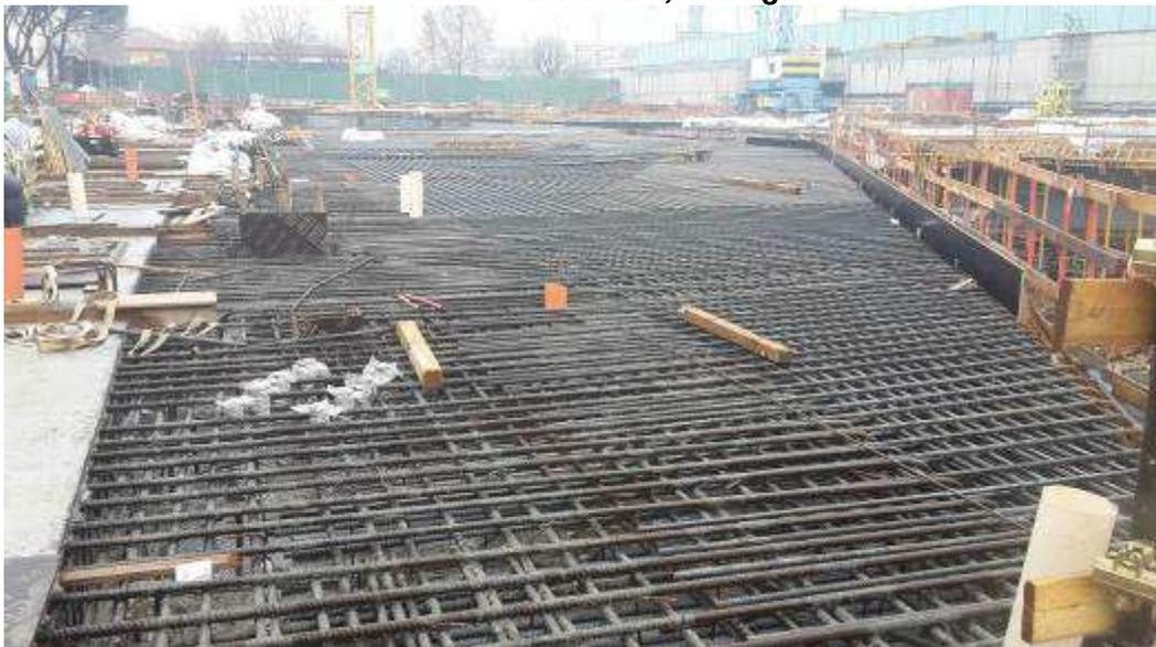
**Foto 3 – Montaggio armatura lato Ovest, Ventaglio Asse 9**
