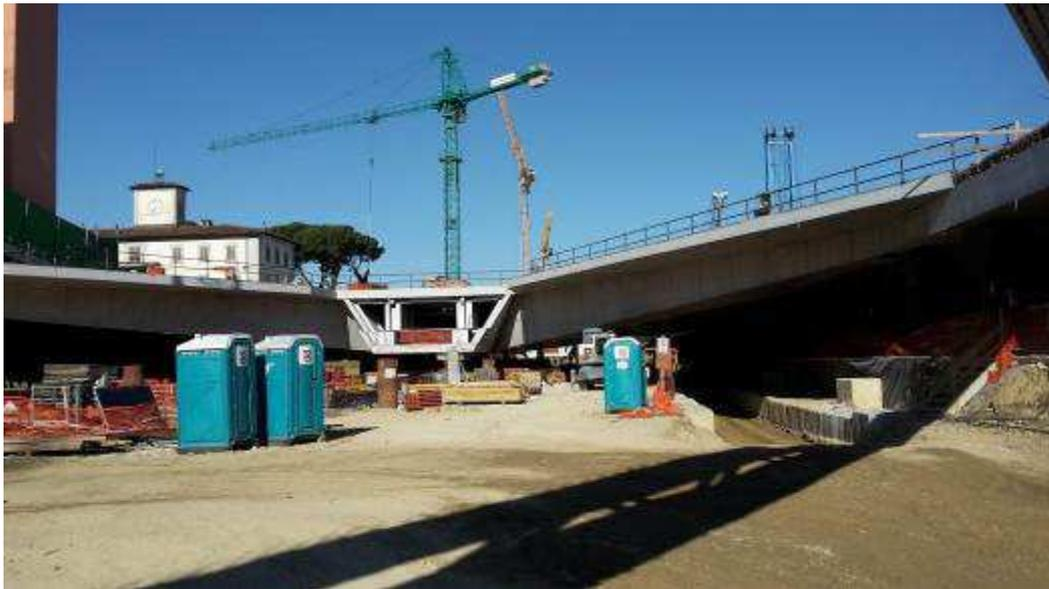
**Foto 5 – Rimozione banchinaggio Solaio, Ventaglio Asse 25**
