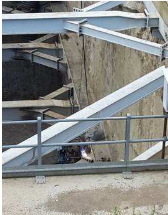
Foto 14 – Pozzo Nord - Interventi per la risoluzione della NC265
