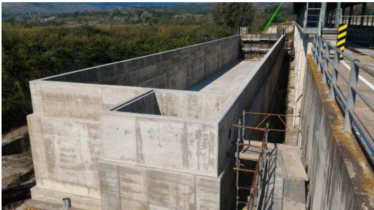
Foto 4 – Realizzazione Vasca di accumulo acque Collina Schermo
