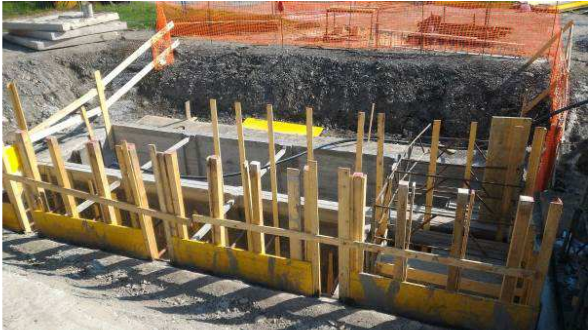
Foto 5 – Interventi per la Risoluzione della NC177
