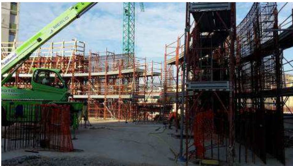
Foto 10 – Montaggio casseri Muro Rampa Kiss&Ride
