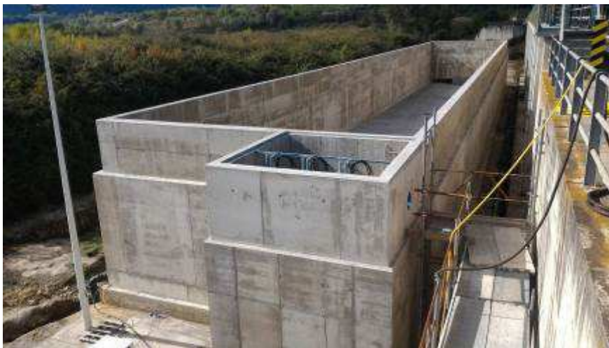
Foto 3 – Realizzazione Vasca di accumulo acque Collina Schermo
