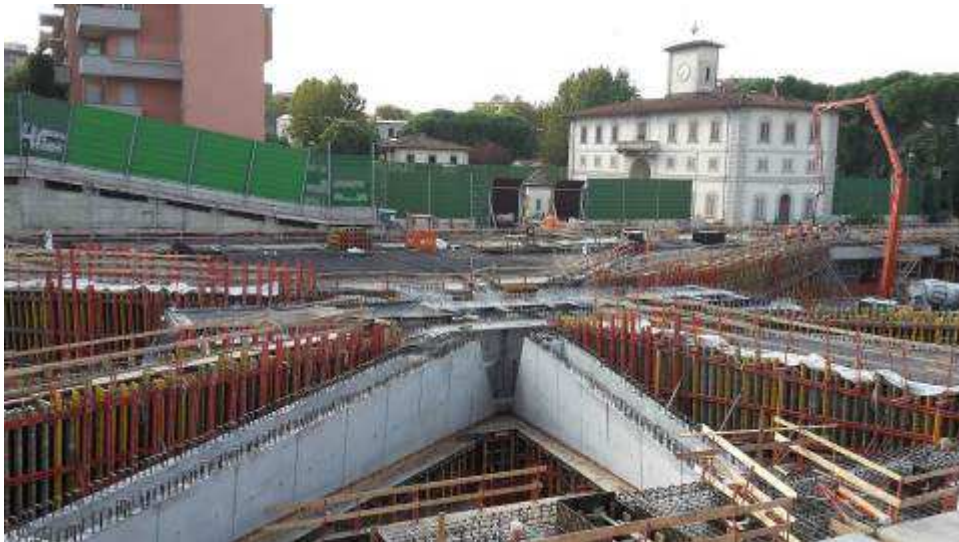
Foto 6 – Montaggio armatura solaio lato Ovest, Ventaglio Asse 25
