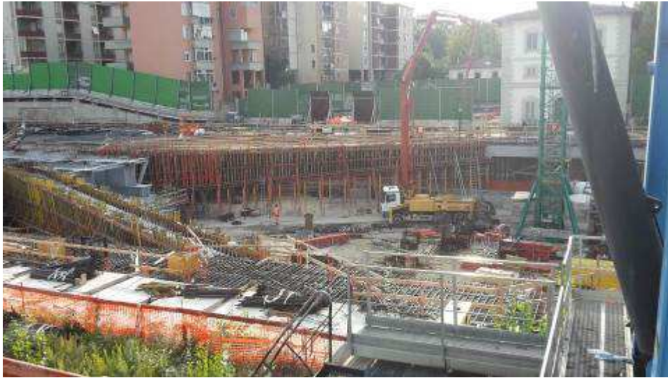
Foto 5 – Getto Travi lunghe lato Ovest, Ventaglio Asse 25
