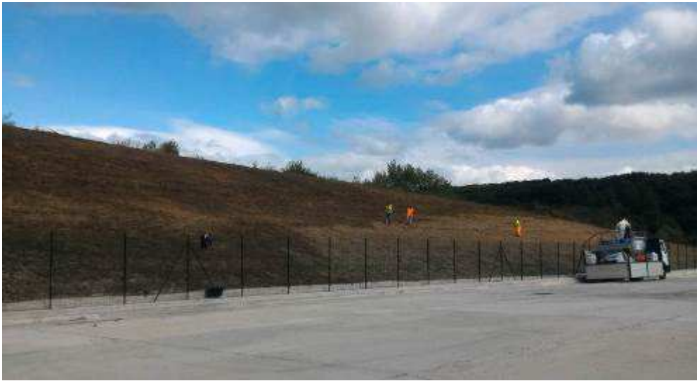
Foto 5 – Inerbimento Terminal Bricchette
