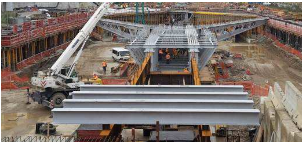
Foto 7 – Montaggio armatura Fondo Cassone, Ventaglio Asse 33
