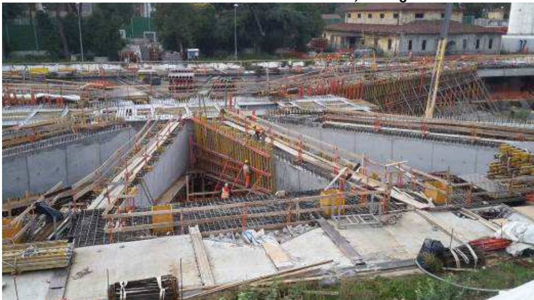
Foto 3–Getto Travi intermedie e corte lato Est, Ventaglio Asse 17
