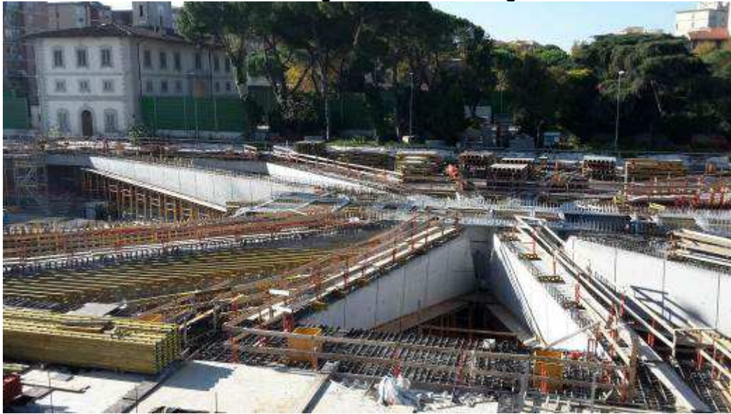
Foto 5– Banchinaggio solaio, Ventaglio Asse 17
