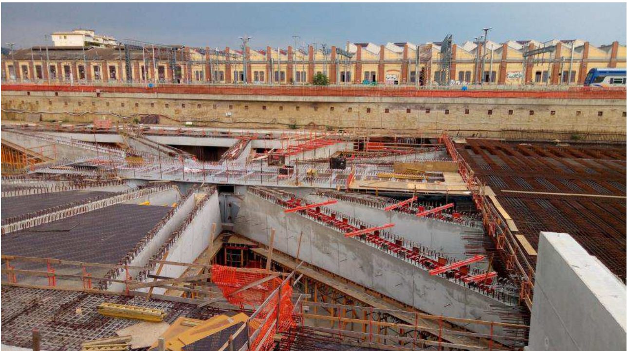
Foto 1 – Pannello F lato ovest, Ventaglio Asse 33
