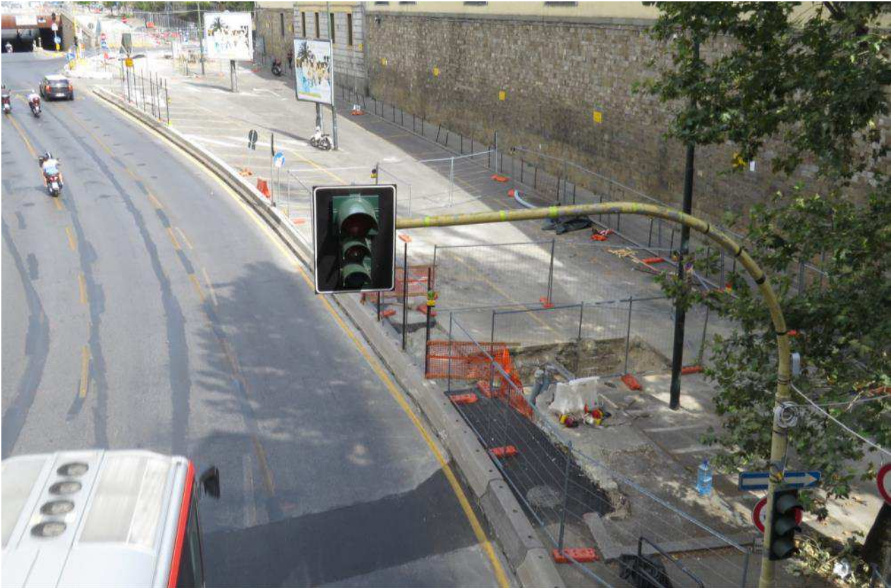
Foto 3 – B.O.E. viale Strozzi e posa polifora tra Trincea 3 e Trincea 4 ultimata – Fortezza da Basso
