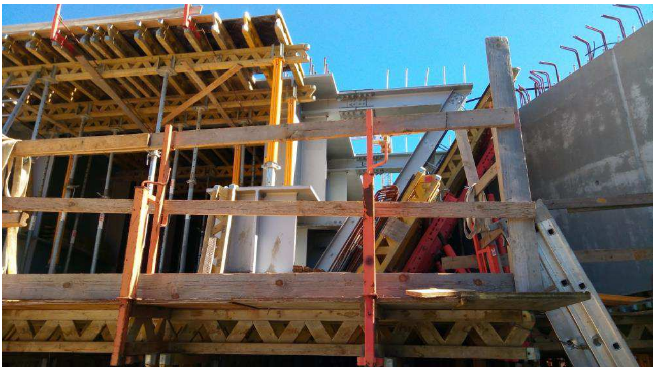
Foto 3 – Casseratura pannello D lato ovest , Ventaglio Asse 33
