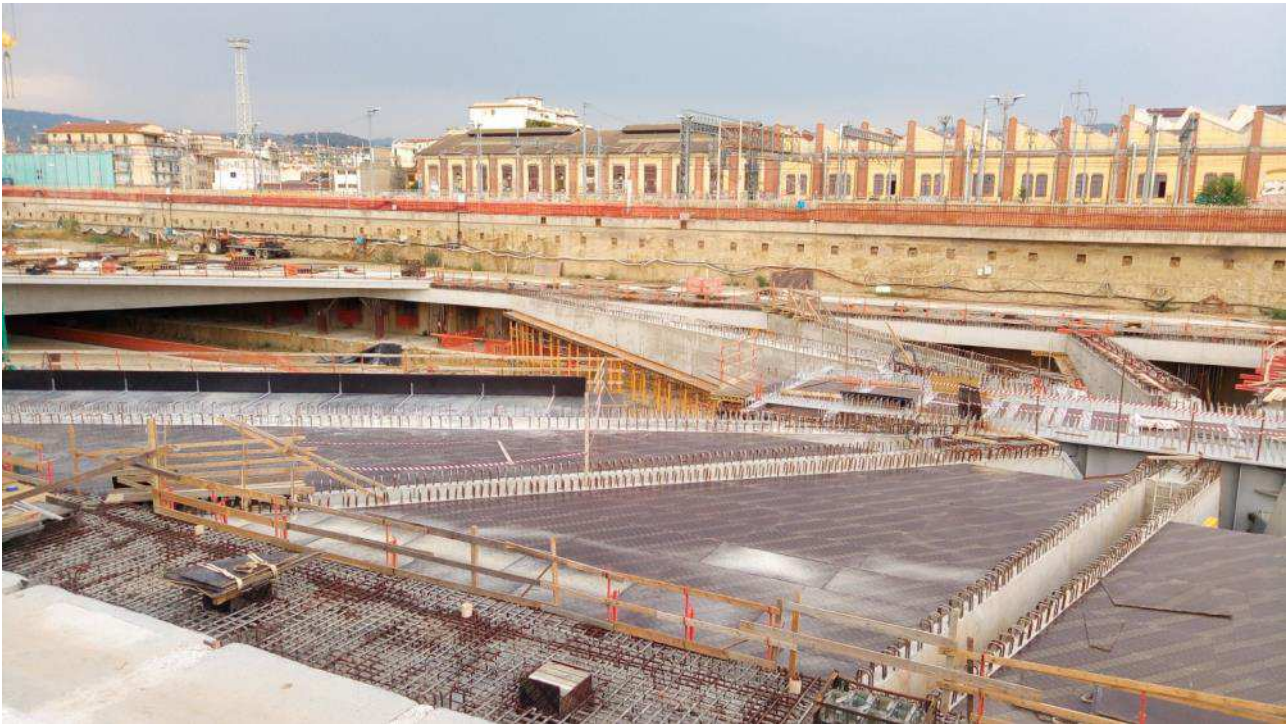
Foto 4 – Banchinaggio solaio quadrante nord/ovest, Ventaglio Asse 33
