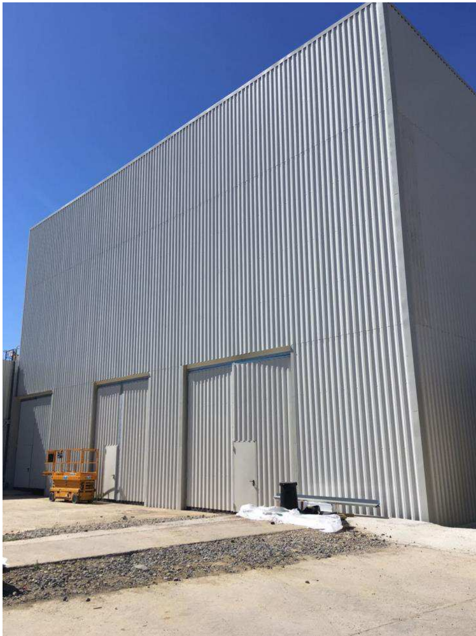
Foto 1 – Montaggio barriere antirumore per schermatura nastro – Area Campo di Marte
