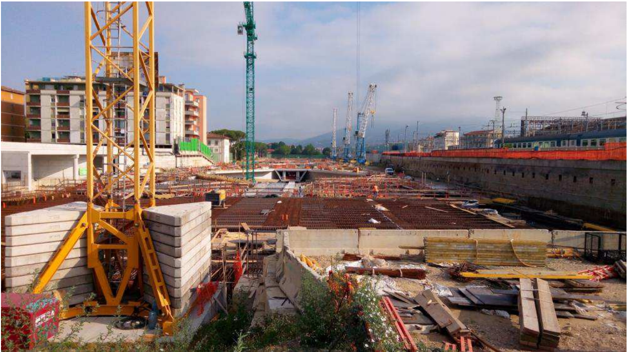
Foto 6– Panoramica da Sud
