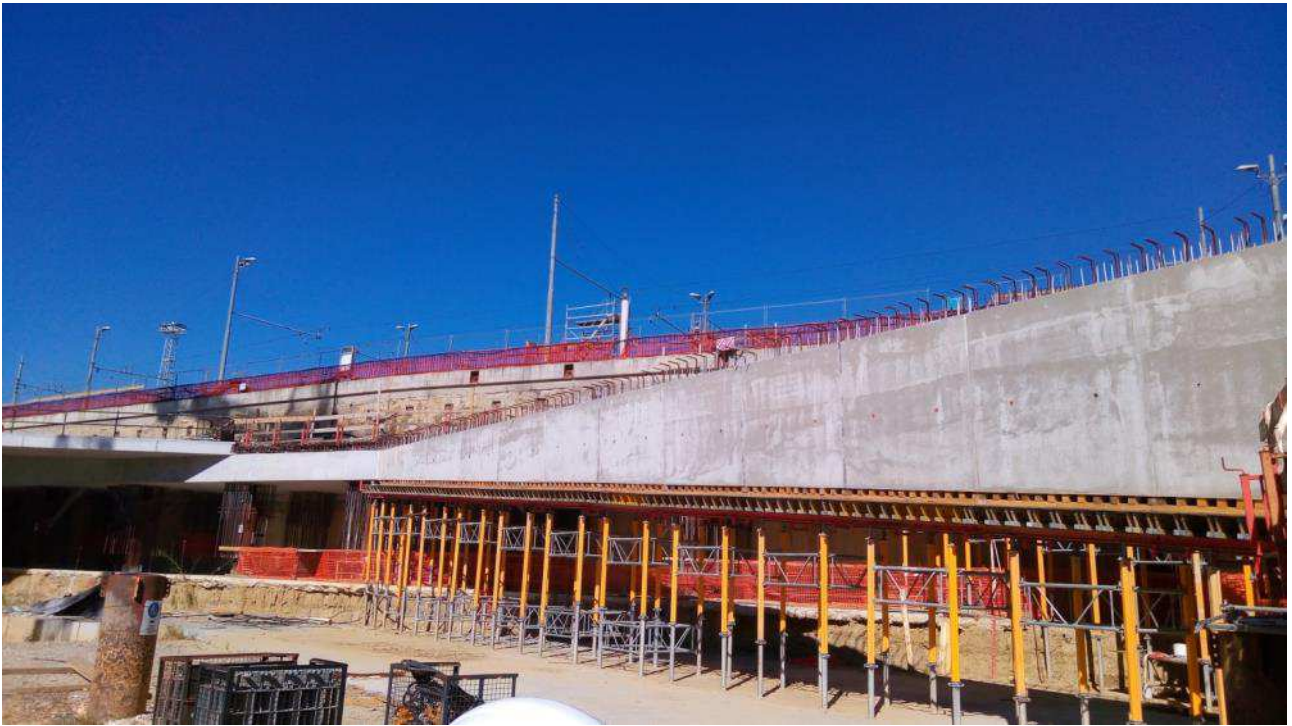
Foto 2 – Trave T1 lato est con finitura faccia vista, ventaglio 33
