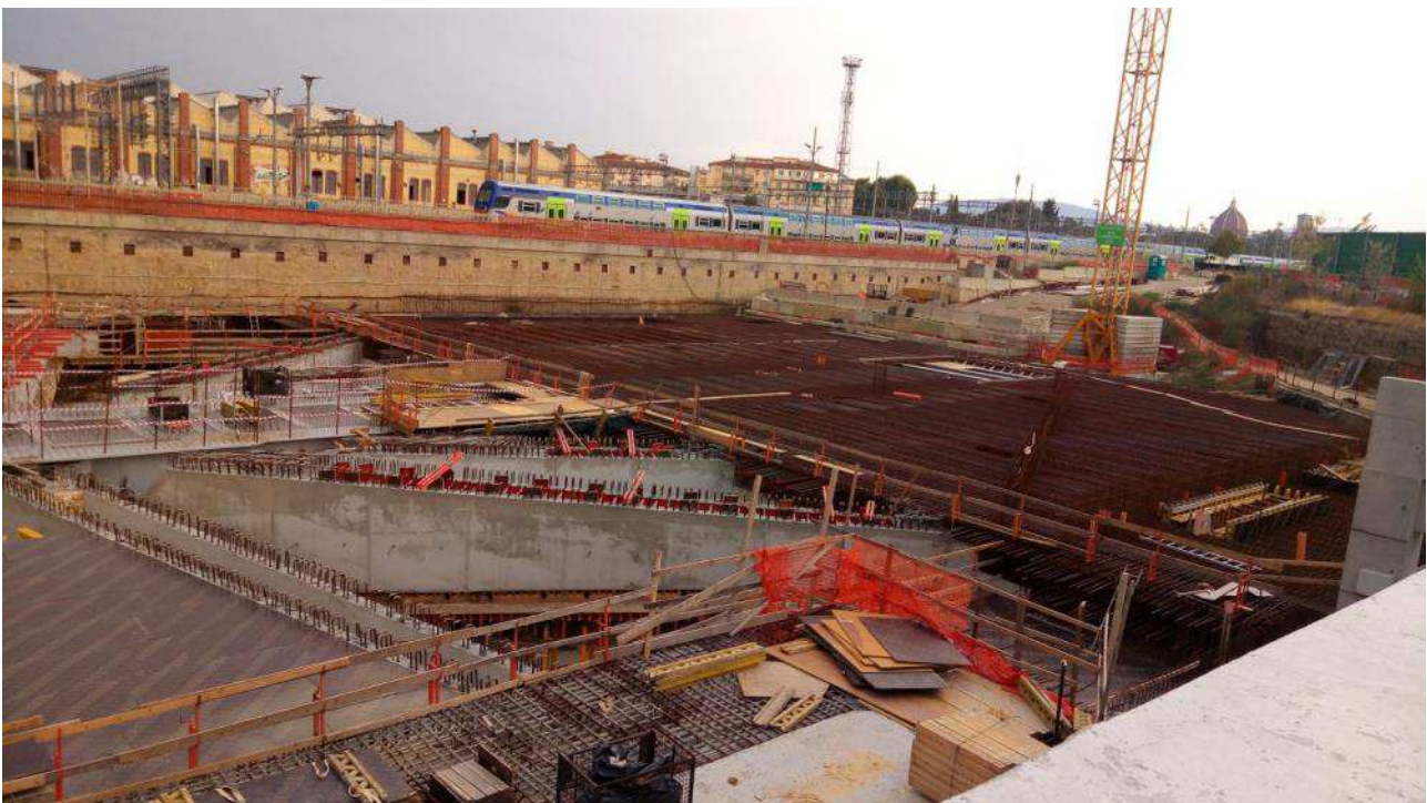
Foto 5 – Posa armatura Solaio liv. 00 Testata Sud
