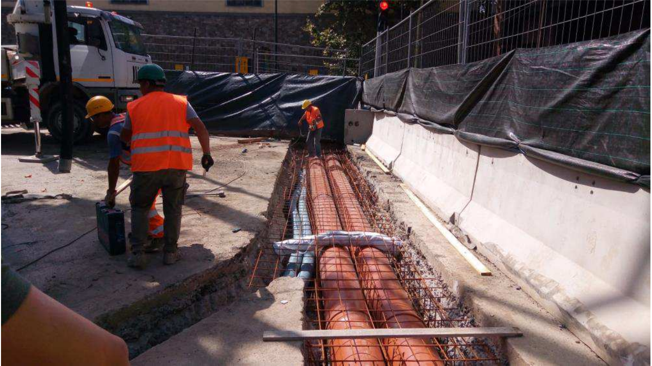
Foto 1– Posa polifora tra Trincea 3 e Trincea 4 – Fortezza da Basso
