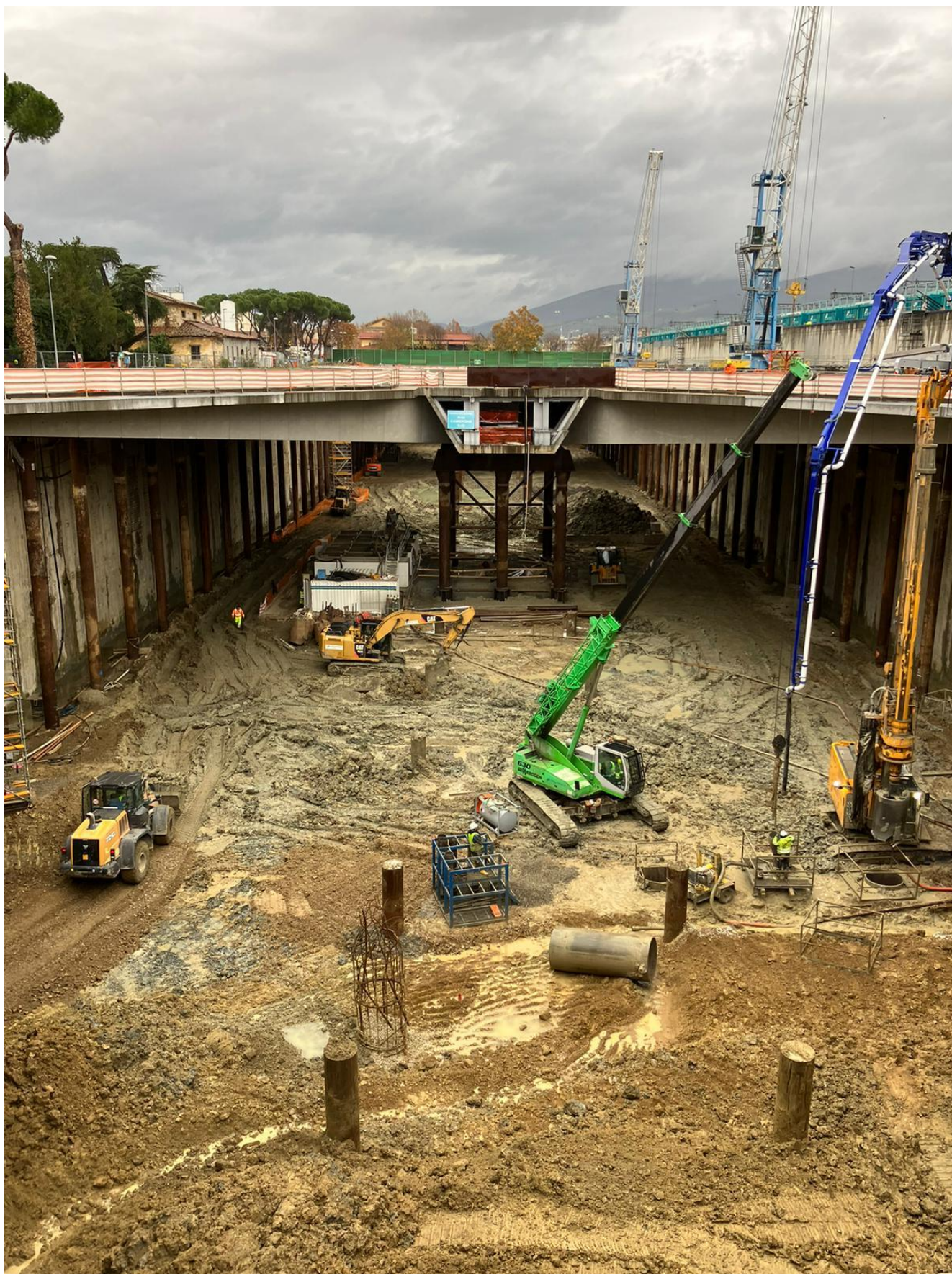
Figura 1 Stazione AV – Esecuzione pali integrativi
