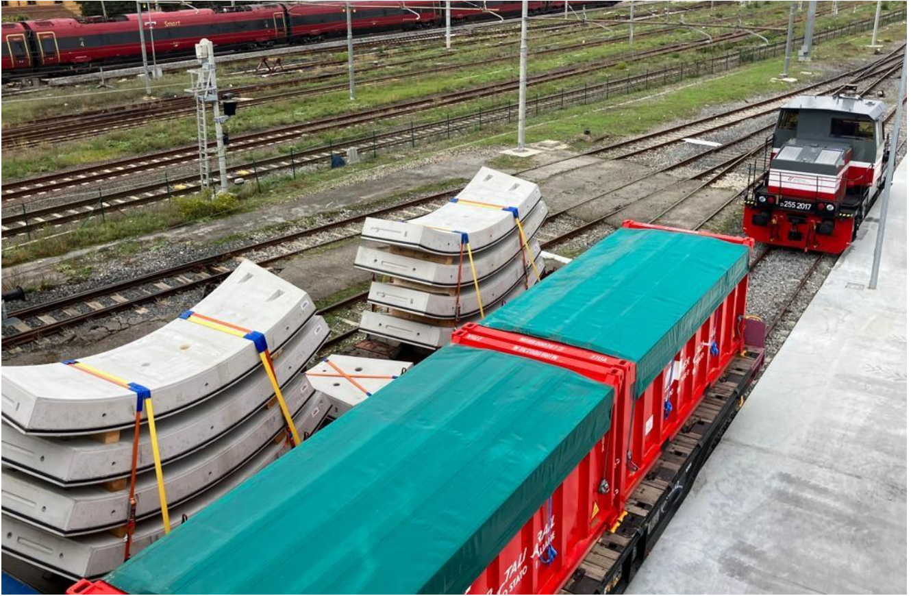
Figura 5 – Scarico Conci (Campo di Marte)
