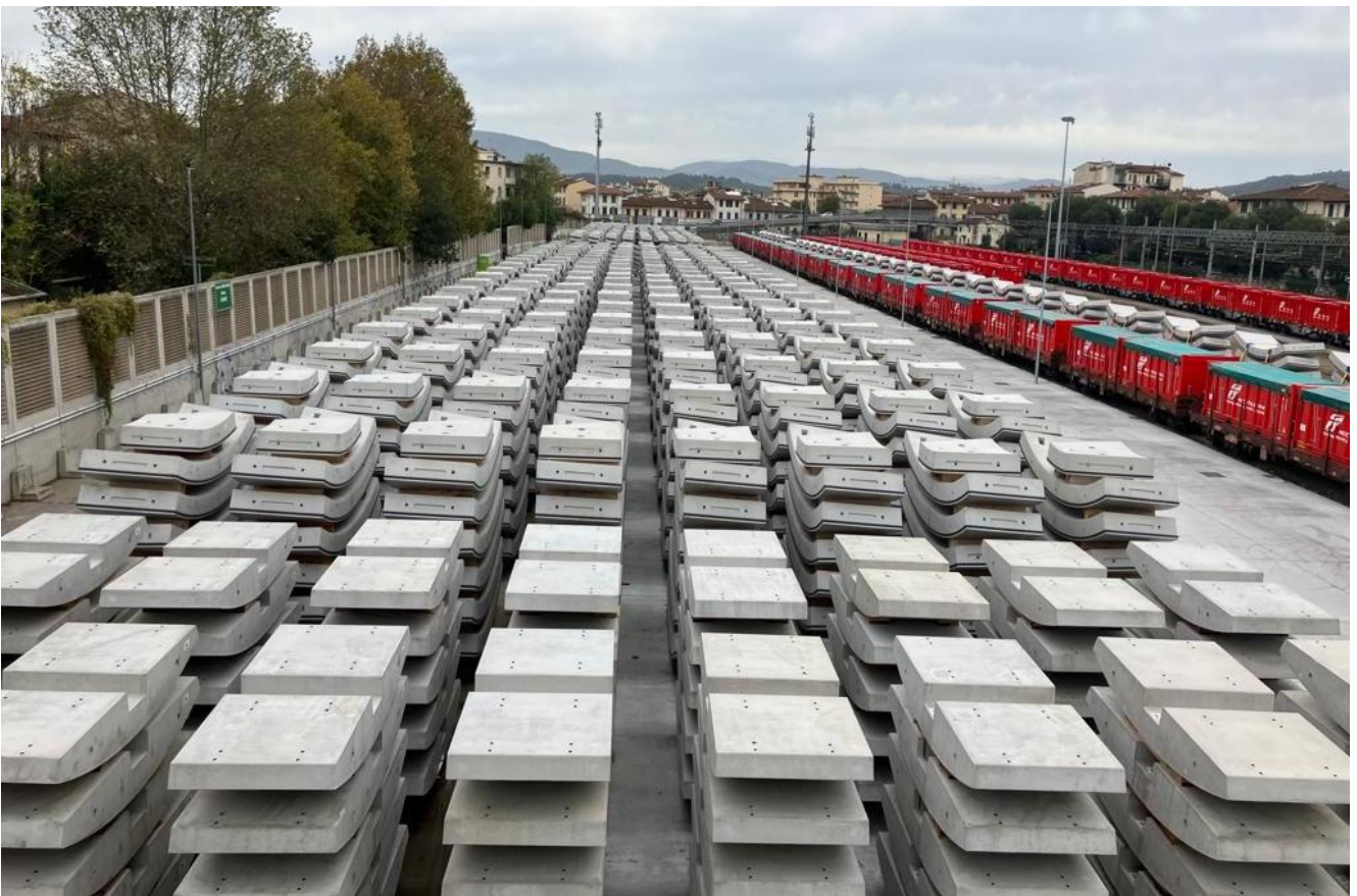
Figura 6 – Stoccaggio Conci (Campo di Marte)
