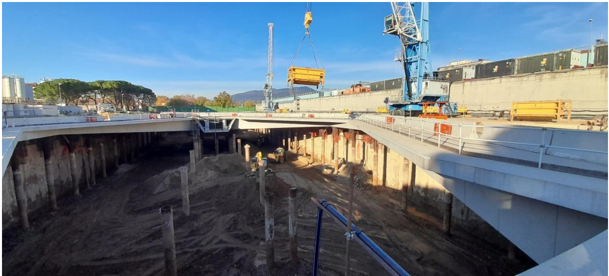
Foto 04 – Attività di carico delle terre sul cassone
