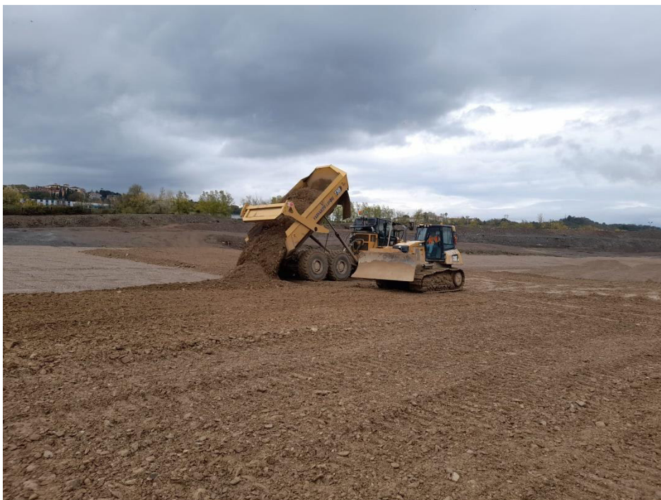
Foto 09 – Attività di messa a dimora delle terre in collina
