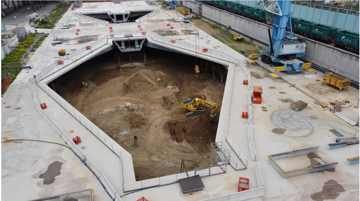
Foto 05 – Attività di scavo delle terre
