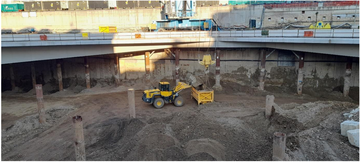
Foto 03 – Attività di carico delle terre sul cassone
