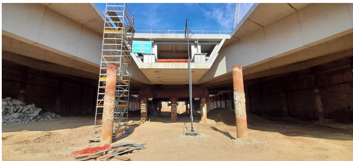
Foto 02 - Sistema pompe per aggotamento dell'acqua
