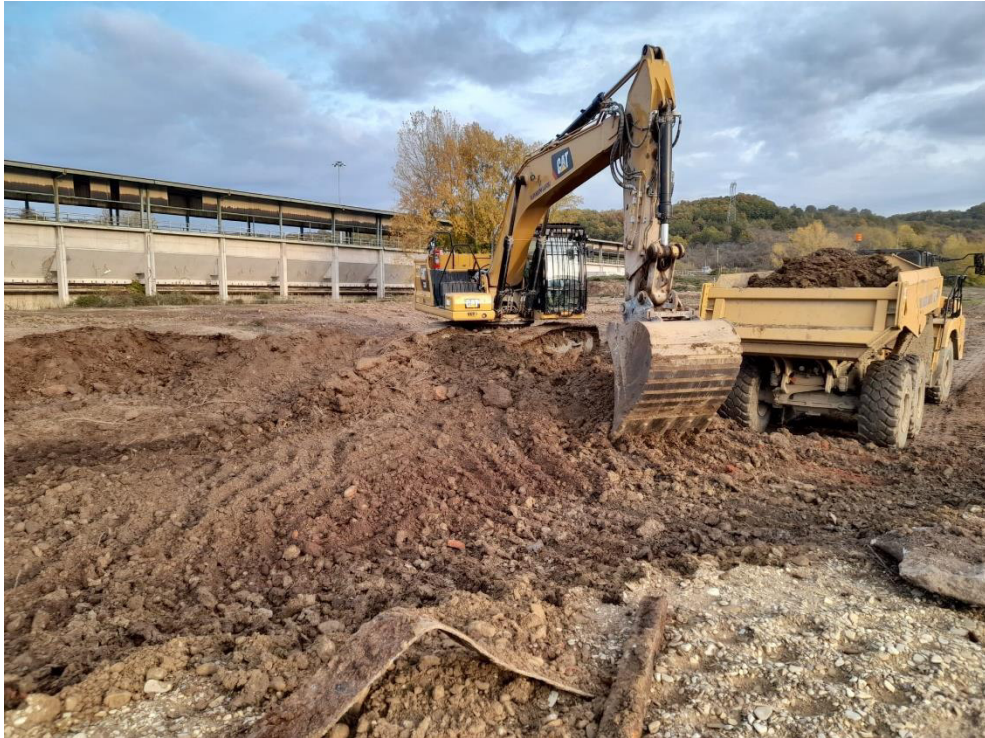
Foto 06 – Attività di scarifica area A3
