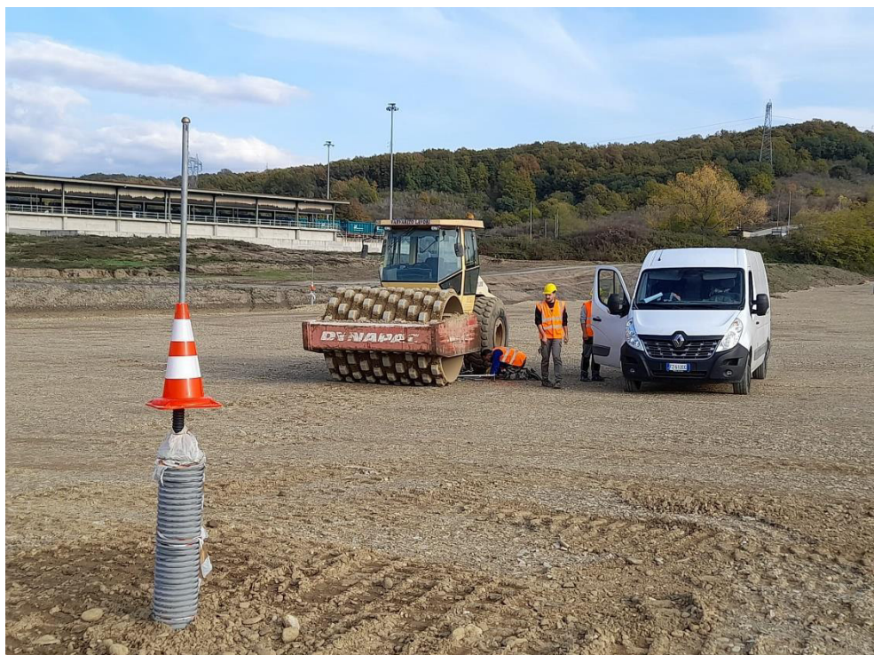
Foto 07 – Prove di compattazione
