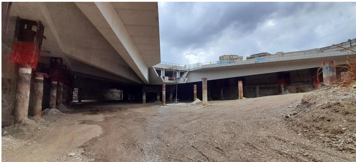
Foto 01 – abbassamento fondo scavo
