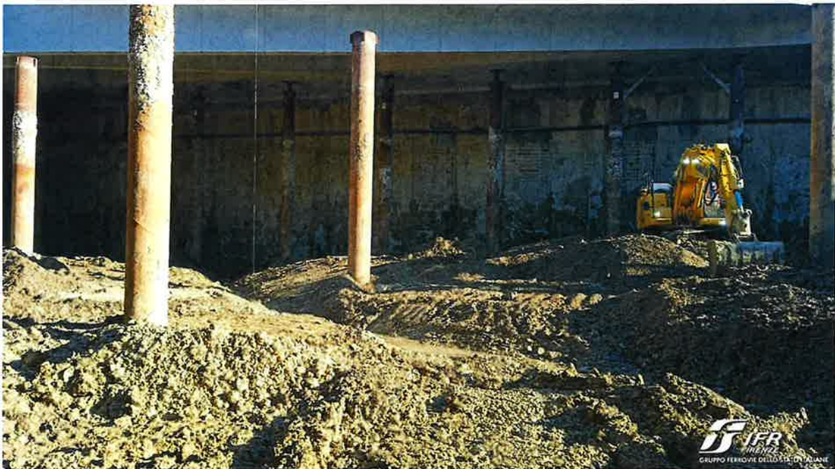
Foto 04 – attività di scavo
