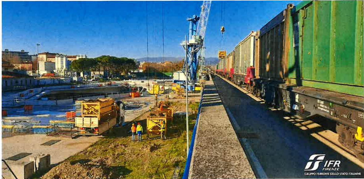
Foto 05 – attività di riempimento containers ferroviari
