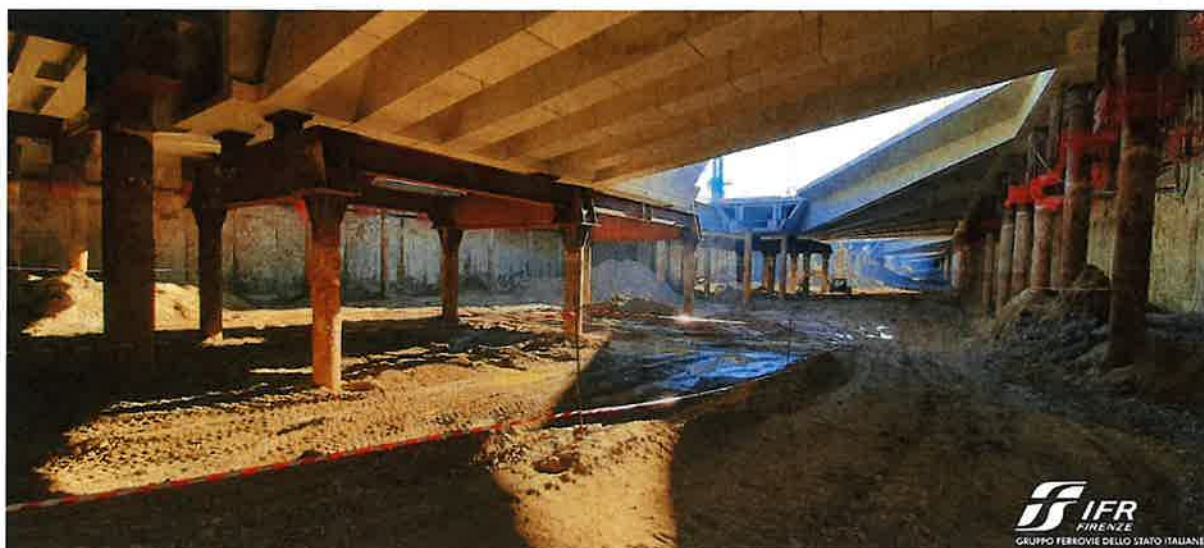
Foto 09 – abbassamento fondo scavo testata sud camerone stazione
