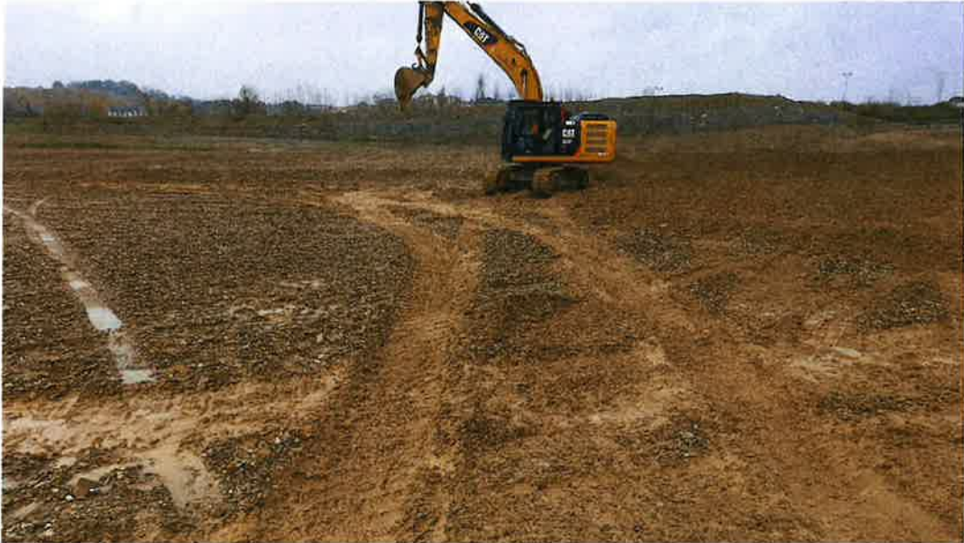
Foto 13 – Attività di scarifica collina schermo
