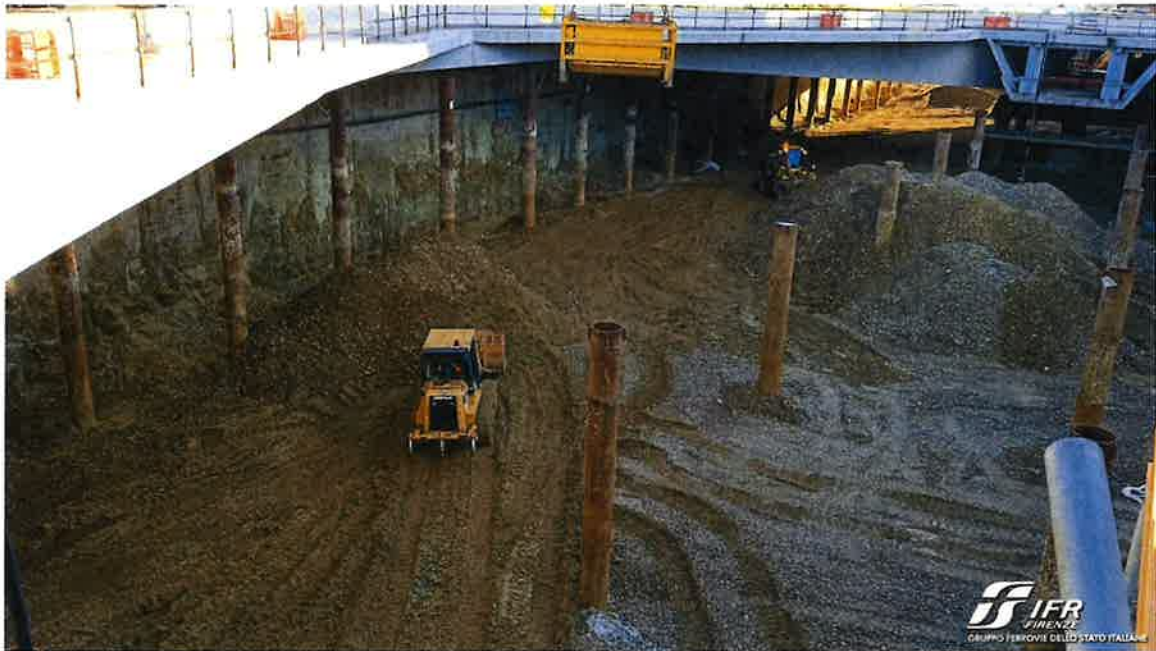
Foto 07 – attività di scavo e realizzazione cumuli
