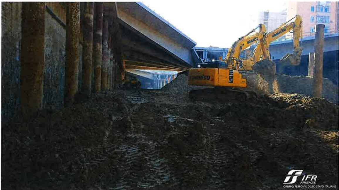
Foto 08 – attività di scavo e realizzazione cumuli
