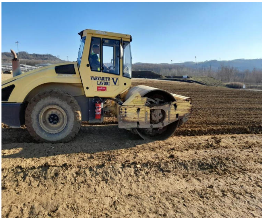
Foto 10 – attività di compattazione presso la collina schermo
