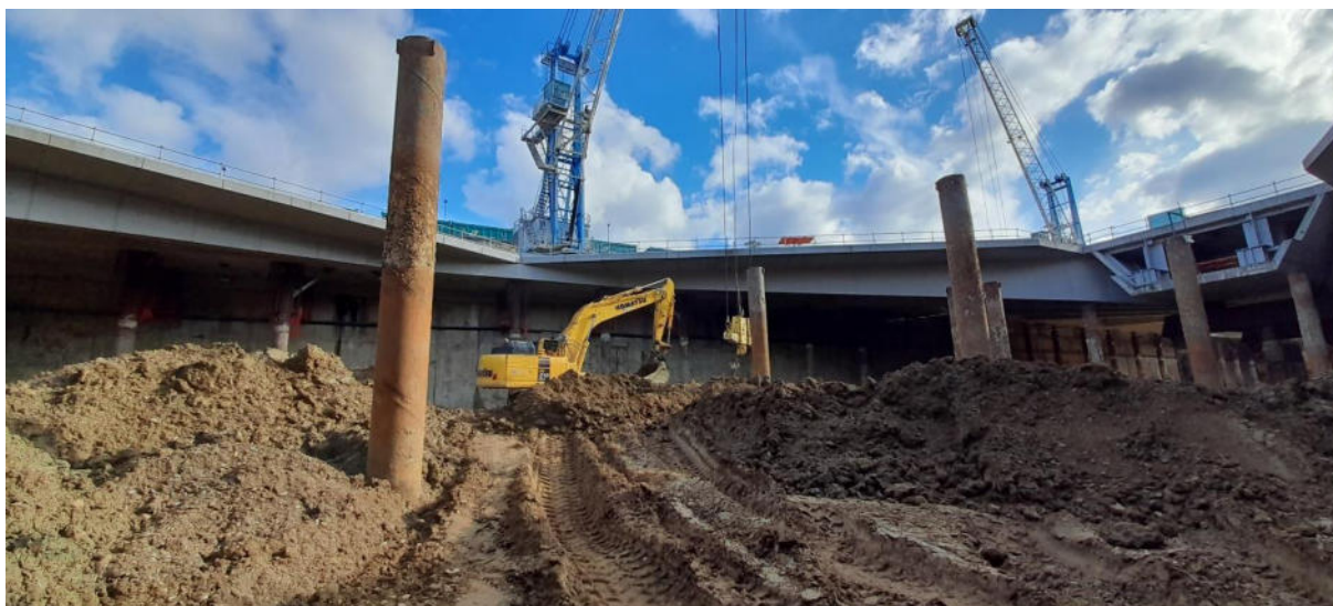
Foto 02 – attività di caricamento tramite la Gru portuale
