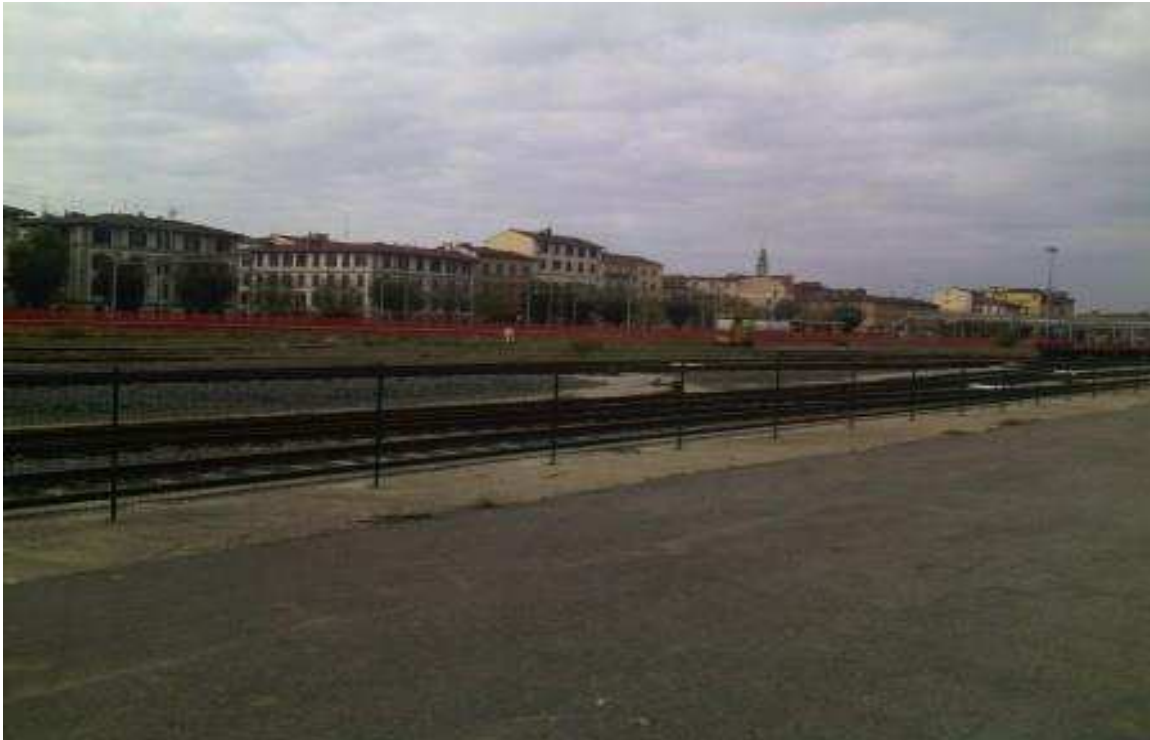
Foto 4 - Adeguamento del Raccordo Ferroviario di Campo di Marte
