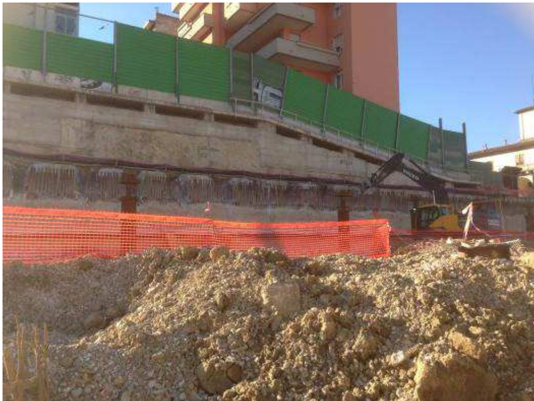
Foto 3 - Demolizione cordolo guida esterno diaframmi Camerone
