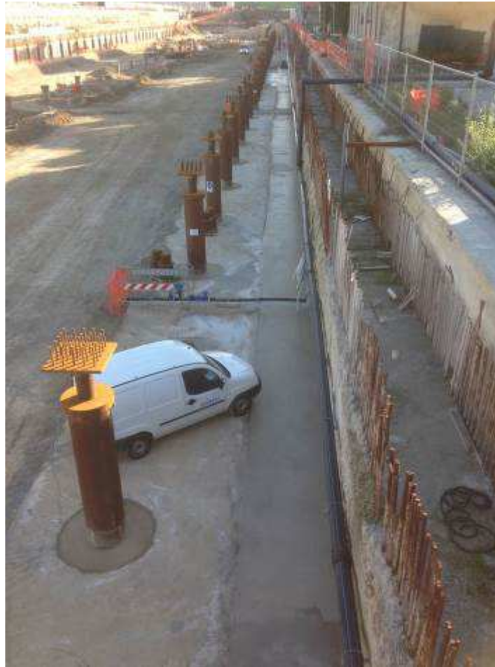
Foto 4 – Ripristini localizzati piani di lavoro interni al Camerone
