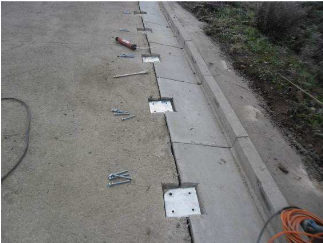
Foto 7 – Ripristino cunette viabilità di servizio
