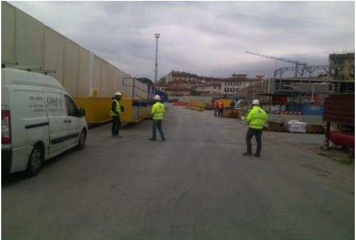
Foto 1 - Montaggio carro ponte
