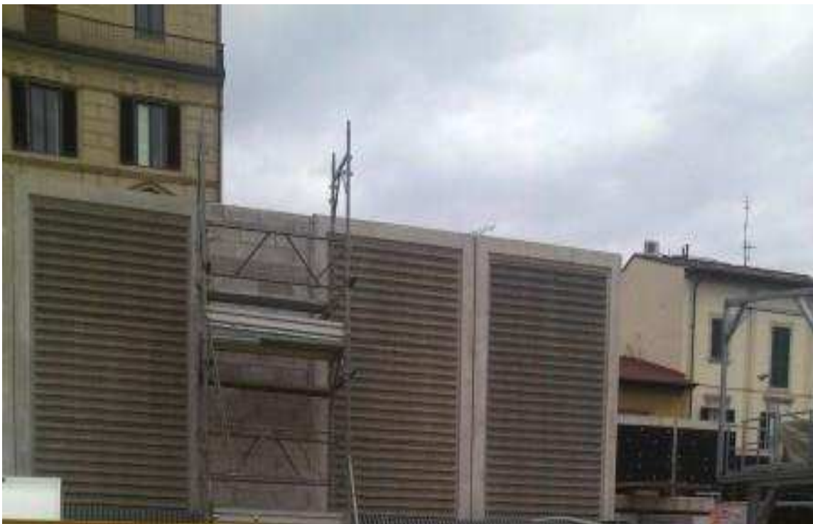
Foto 3 – Rialzo recinzione su muro via Campo d'Arrigo
