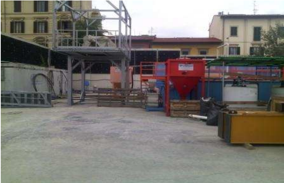
Foto 2 – Montaggio struttura filtropressa
