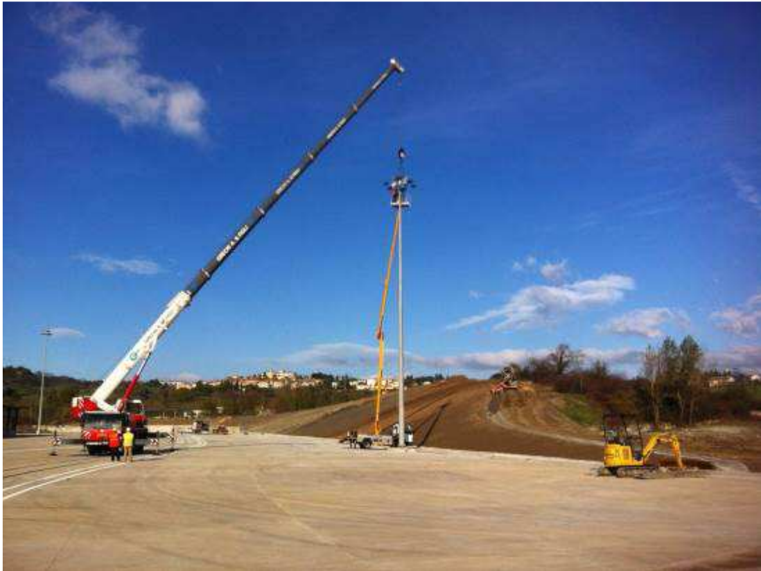
Foto 6 – Posa Torri Faro Terminal
