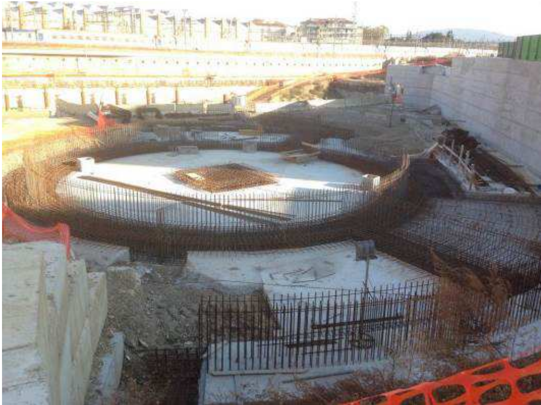
Foto 2 - Armatura fondazioni rampa Kiss&Ride
