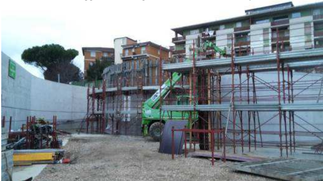
Foto 9 – Montaggio casseri Pilastri, Rampa Kiss&Ride
