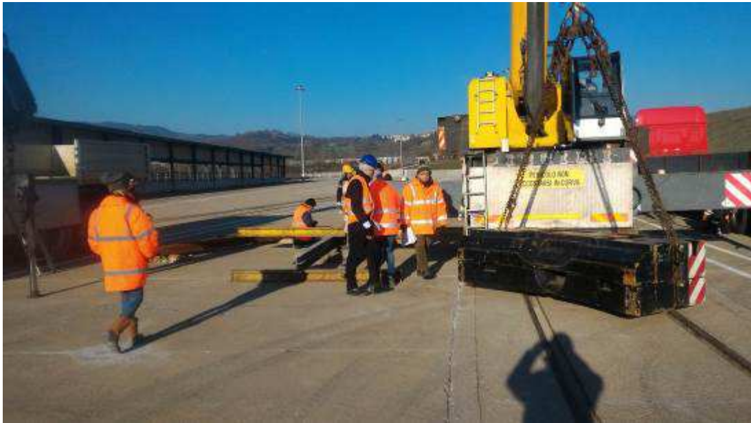
Foto 1 – Prova di carico pavimentazione
