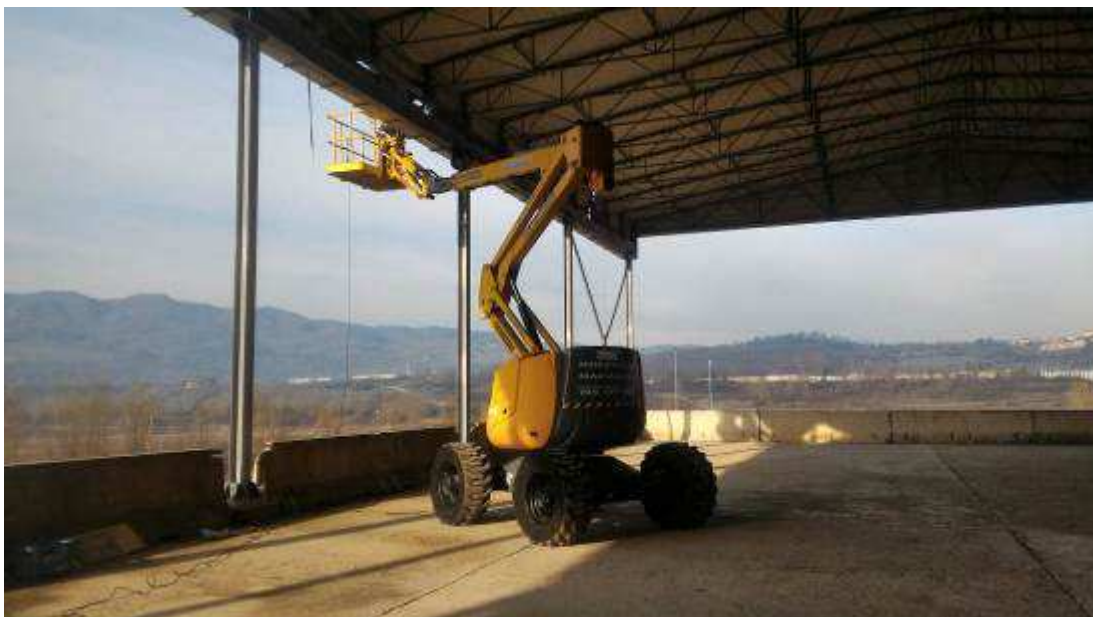
Foto 2 – Riparazione telo copertura piazzole
