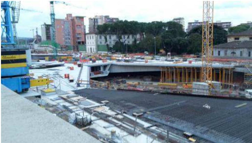
Foto 5 – Rimozione banchinaggio Solaio, Ventaglio Asse 17
