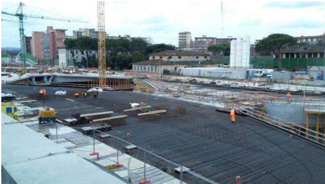
Foto 2 – Montaggio armatura soletta lato Est, Ventaglio Asse 9
