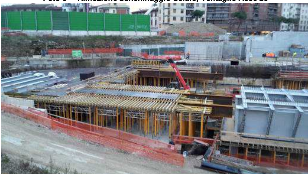
Foto 7 – Banchinaggio Testata Sud - lato Ovest
