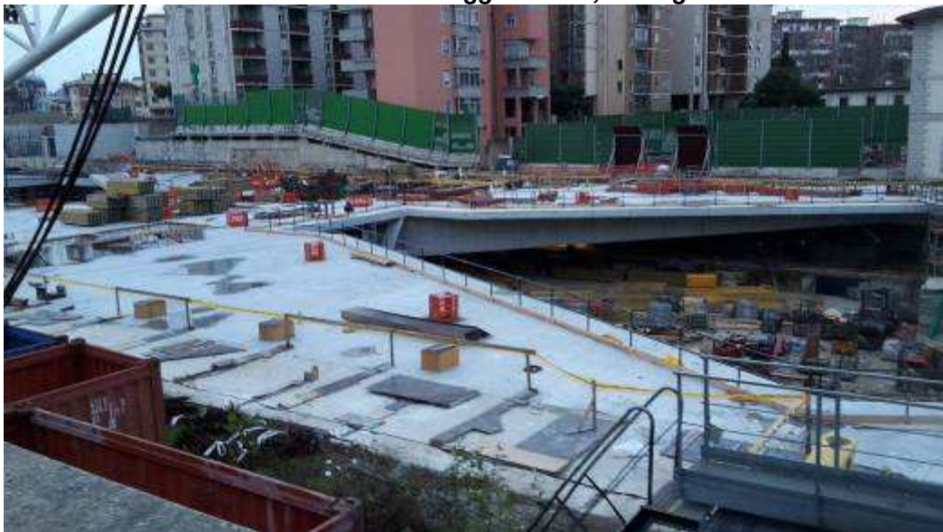
Foto 6 – Rimozione banchinaggio Solaio, Ventaglio Asse 25
