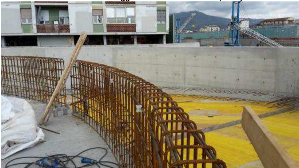
Foto 10 – Banchinaggio Soletta Rampa L0204, Rampa Kiss&Ride
