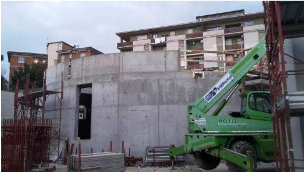
Foto 8 – Getto Parapetto Muro MU10, Rampa Kiss&Ride
