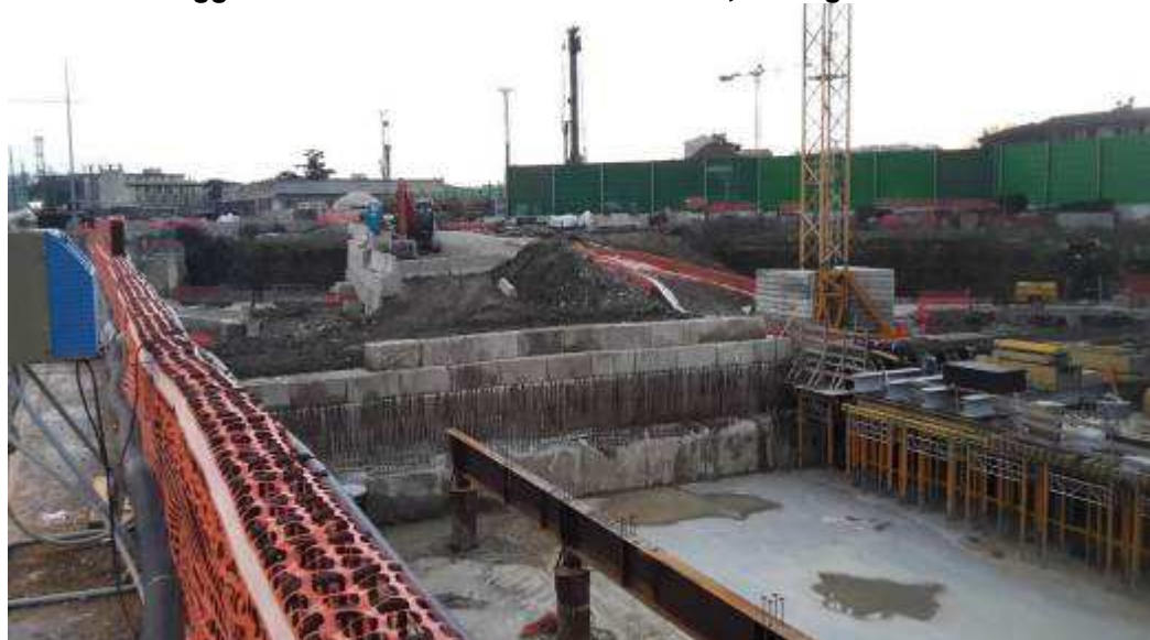
Foto 4 – Rimozione Rampa di accesso camerone, Zona Testata Sud
