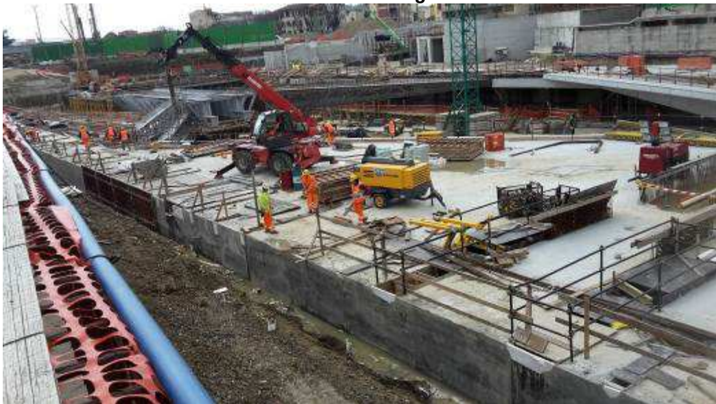
Foto 12 – Ripristino copriferro Travi Cuscino - Risoluzione NC
