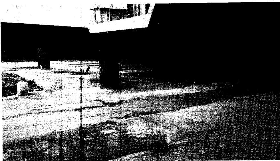
Foto 2 – Taglio Platee per appoggio puntelli banchinaggio, Ventaglio Asse 17
