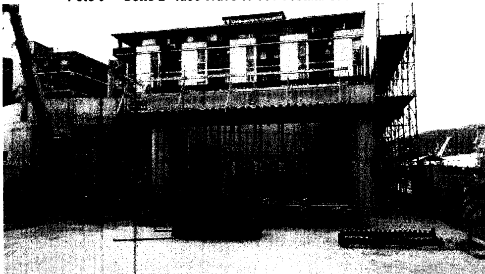
Foto 10 – Getto Trave T2 e parapetto MU10, Rampa Kiss&Ride
