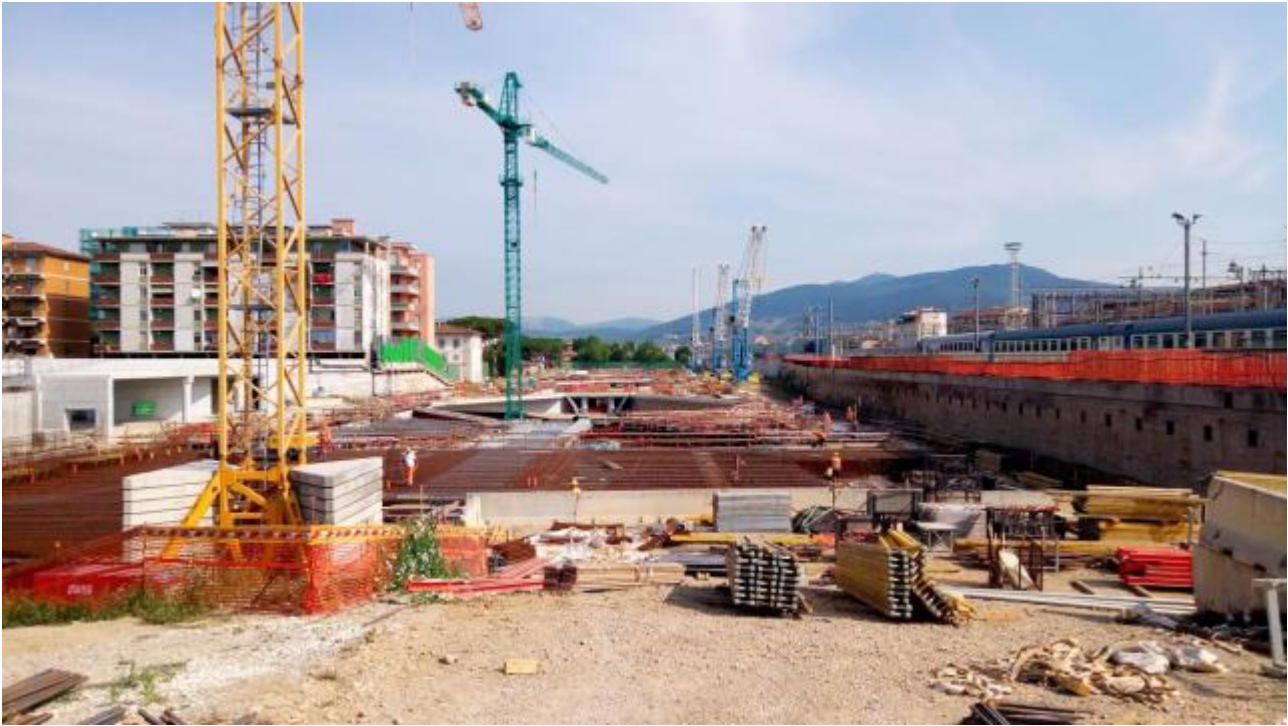
Foto 4 – Panoramica da Sud
