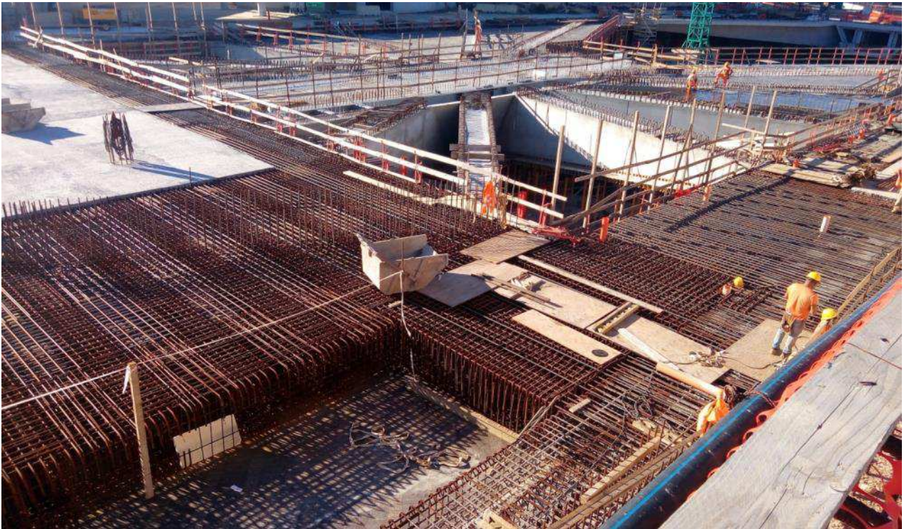
Foto 4 – Posa armatura trave cuscino est allineamento 34
