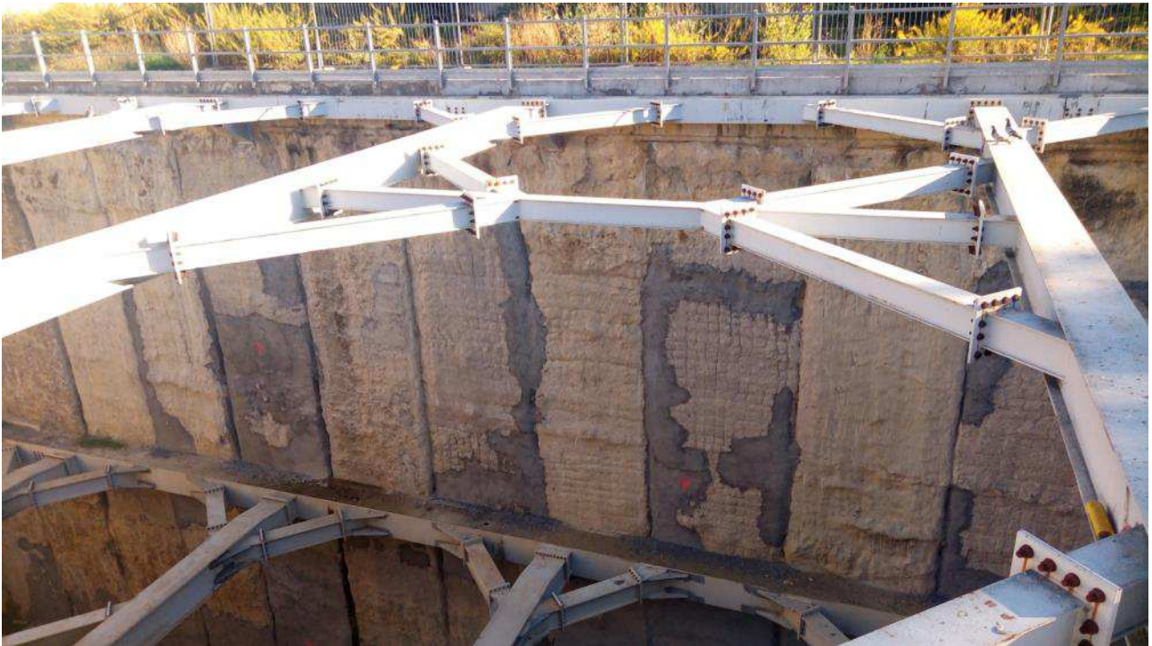
Foto 1 – Interventi di ripristino NC286 Pozzo Nord
