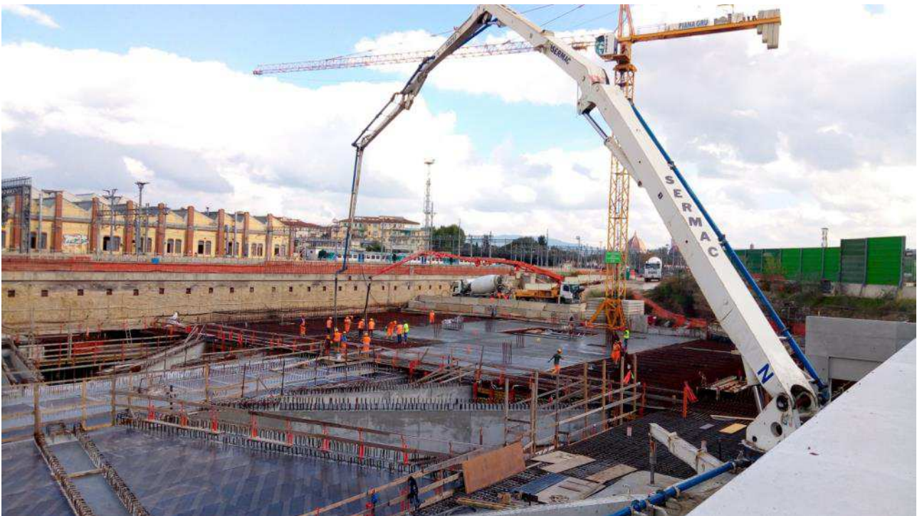
Foto 5 – Getto parte centrale solaio Testata Sud
