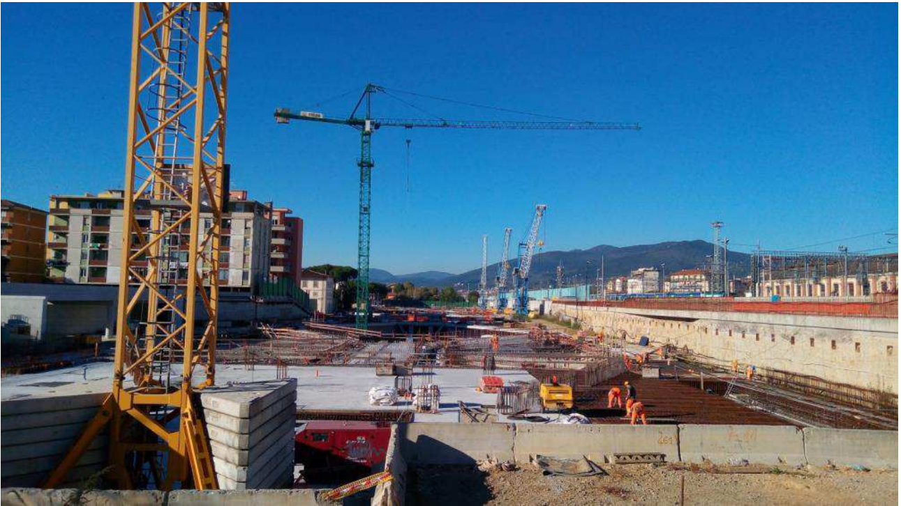
Foto 8 – Panoramica da Sud
