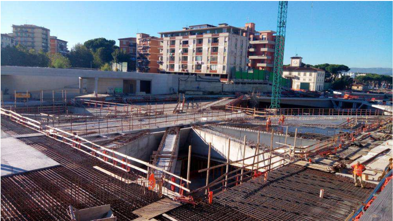
Foto 2 – Banchinaggio solaio liv. 00, Ventaglio Asse 33
