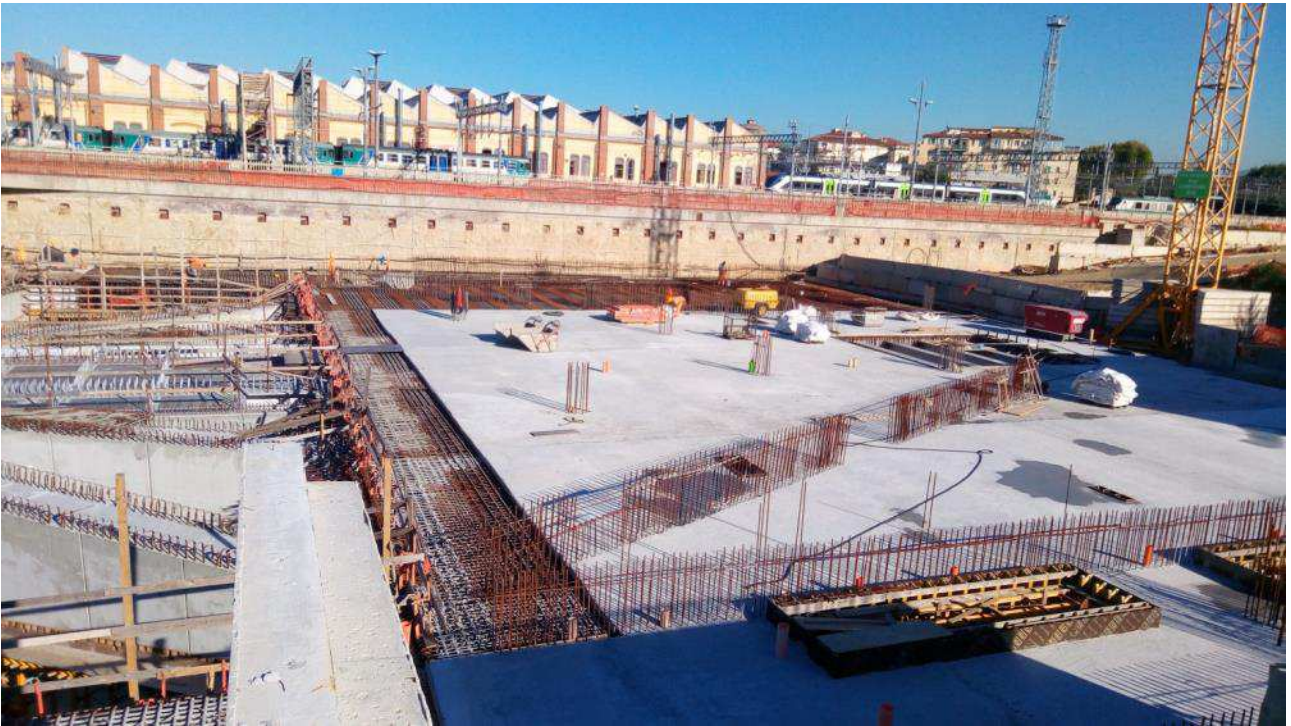
Foto 6 – Getto lato ovest solaio Testata Sud
