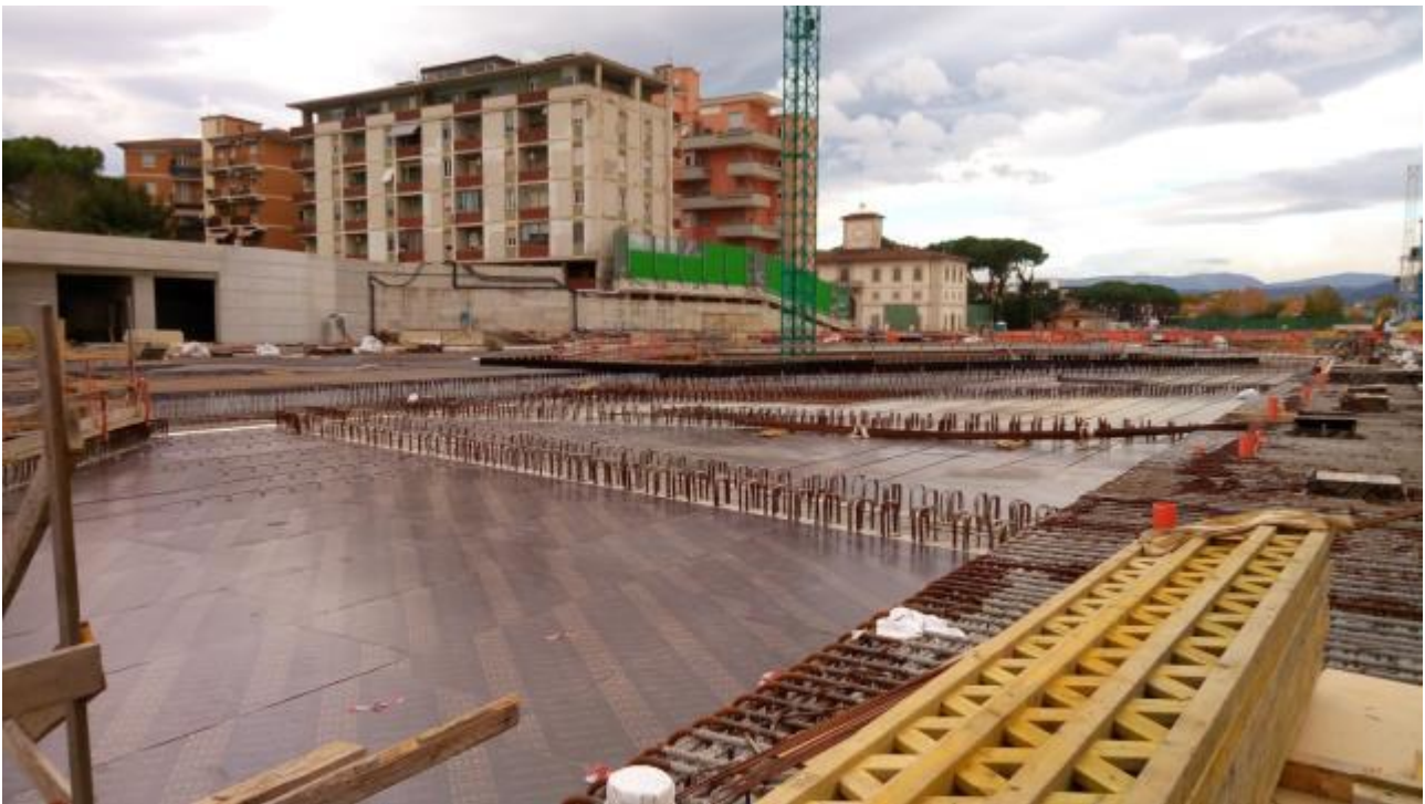
Foto 1 – Banchinaggio solaio liv. 00, Ventaglio Asse 33
