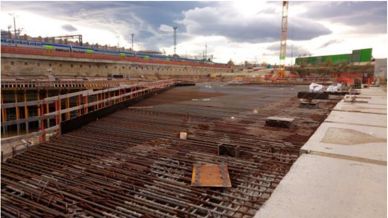
Foto 2 – Posa armatura solaio ventaglio 33
