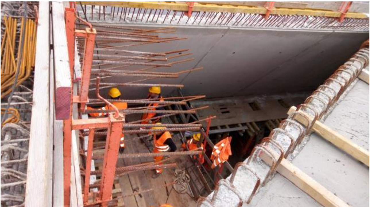
Foto 5 – Realizzazione carpenteria trave estetica lato est – Testata Sud
