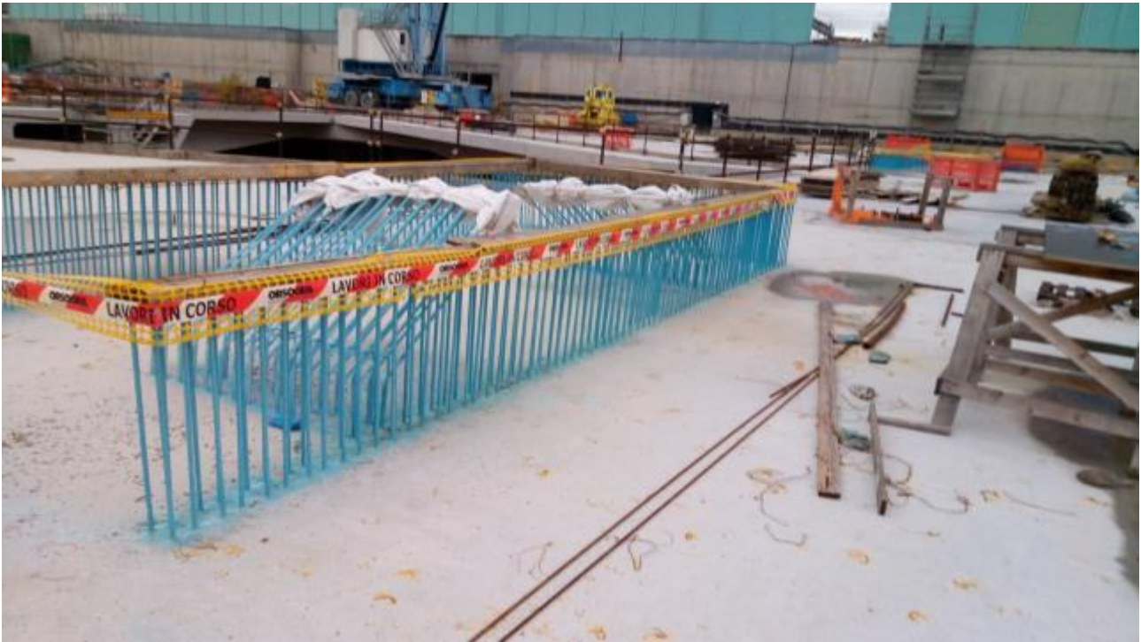
Foto 6– Passivante applicato sui ferri di attesa del solaio liv. 00
