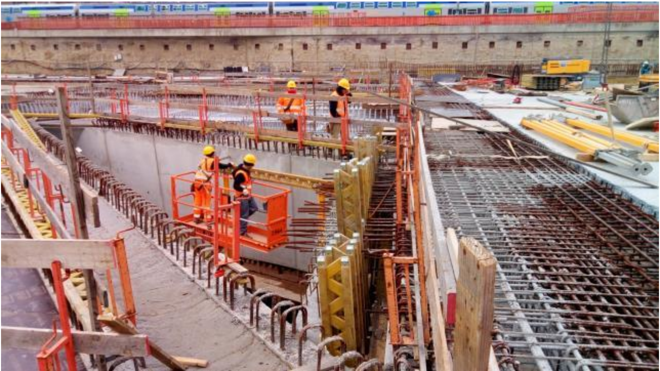
Foto 4 – Trave estetica lato ovest – Testata Sud
