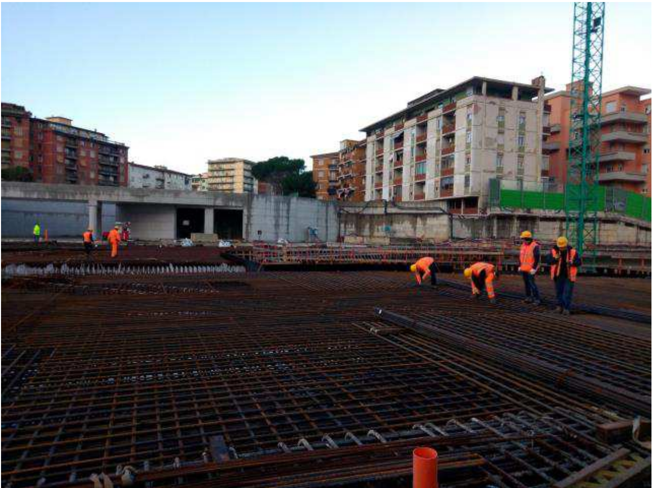
Foto 1 – Posa armatura solaio ventaglio 33
