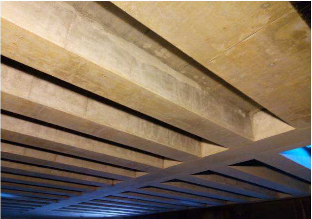
Foto 3 – Scassero solaio Testata Sud
