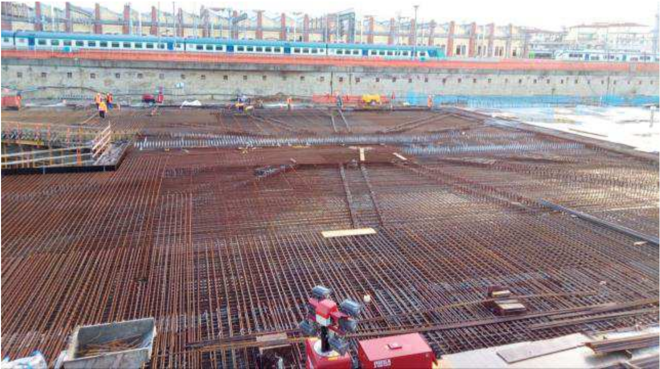
Foto 2 – Posa armatura solaio ventaglio 33
